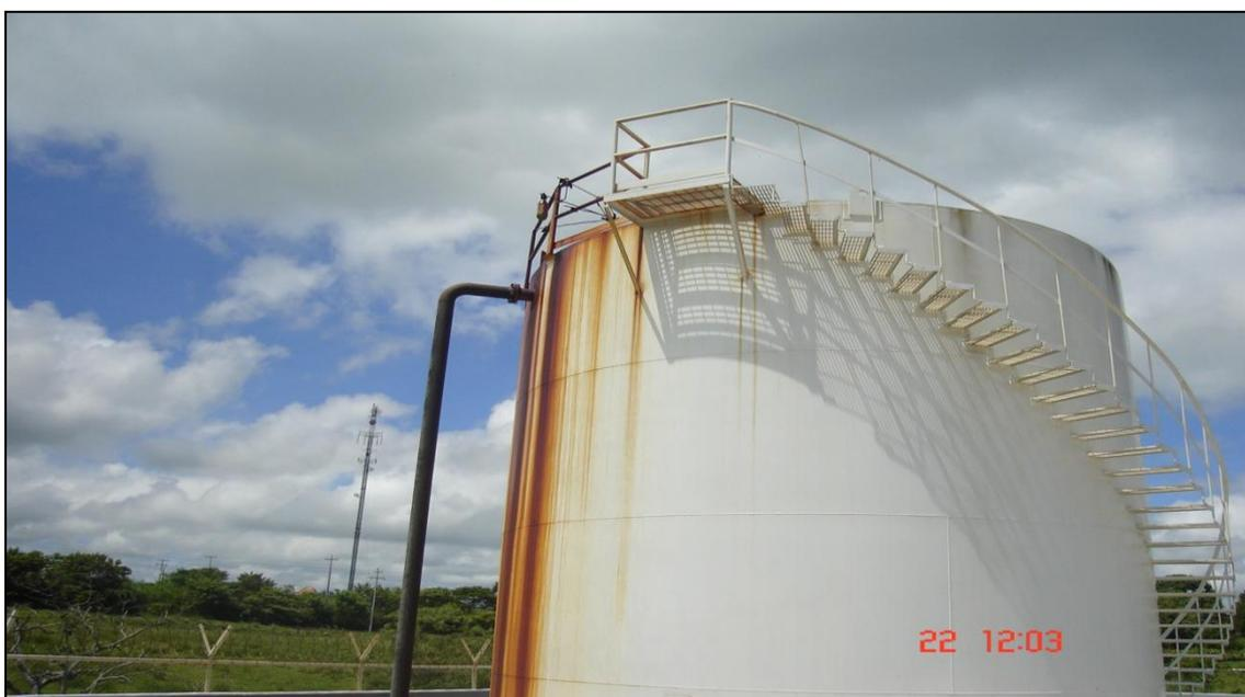
Figura 4.5. Tanque de almacenamiento dañado por la prolongada exposición al venteo de hidrocarburos.(PEP, 2008)
