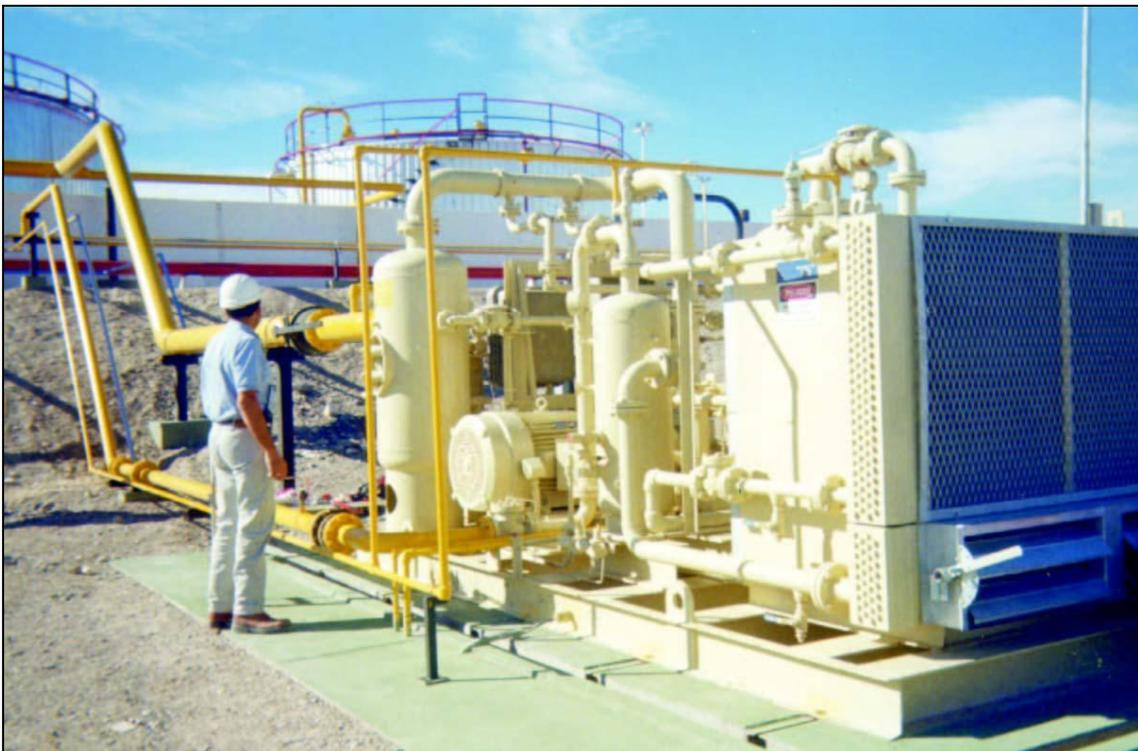
Figura 3.5. Unidad Recuperadora de Vapor instalada en el campo. (Taller de Transferencia de Tecnología PEMEX y Agencia de Protección Ambiental, EUA 25 de abril de 2006 Villahermosa, México)
