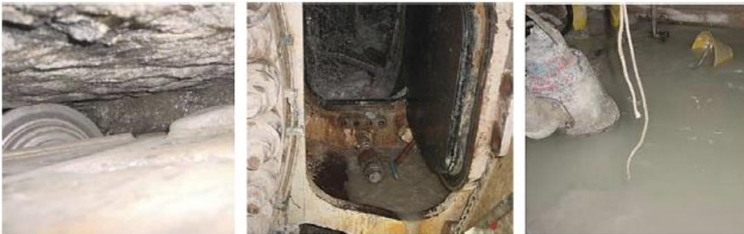
Figura 2.8 Ingreso de agua desde el frente del túnel. (Zhao et al., 2007)
