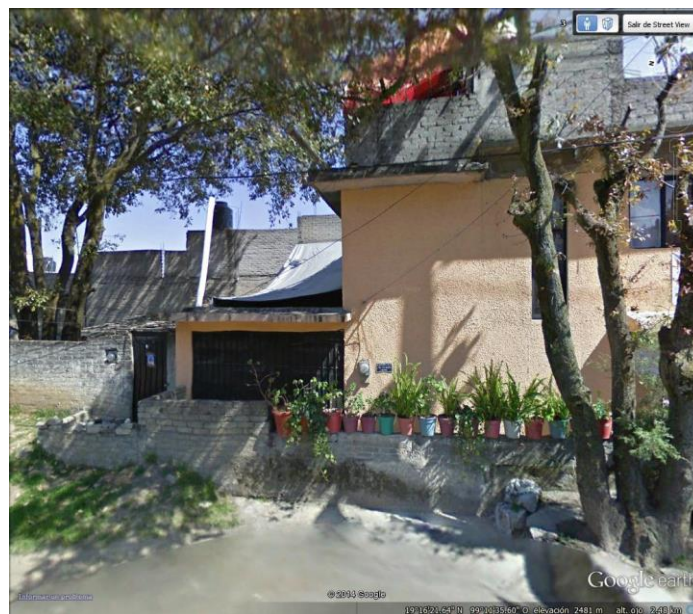
Figura 2. 9 Casa afectada por inundaciones
