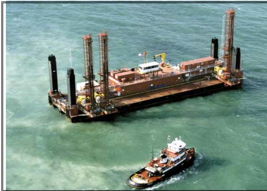
Figura 6. Plataforma autoelevable con tres torres de perforación.
