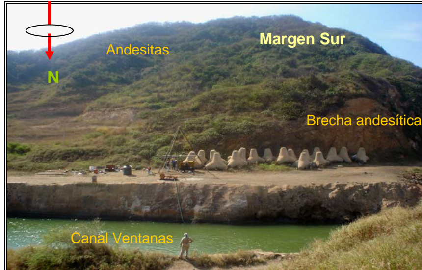
Fotografía 2. Vista frontal de la margen Sur, viendo desde la margen Norte.
