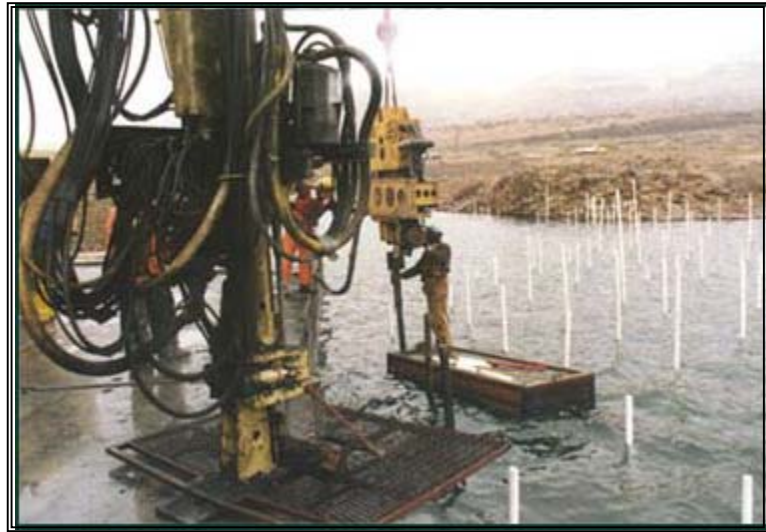
Figura 8. Cargado de explosivo
