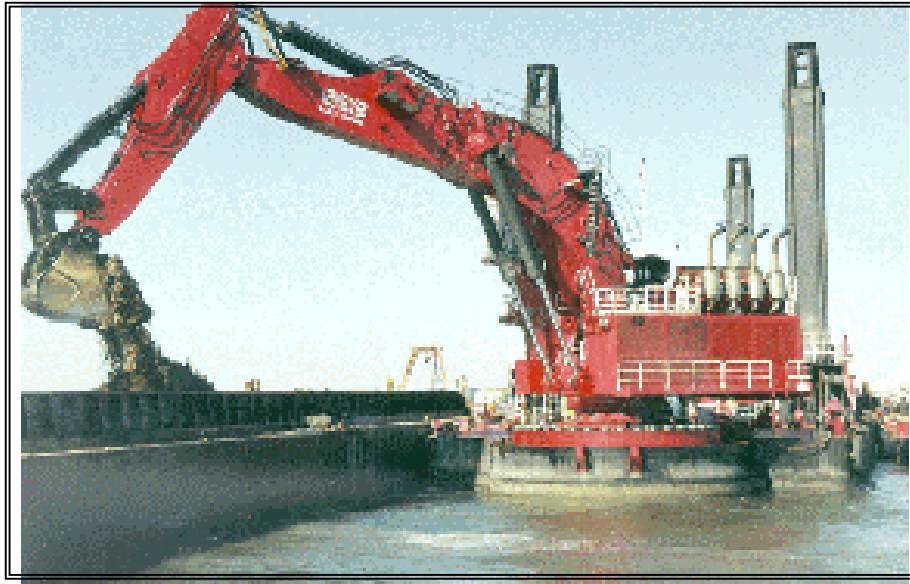
Figura 9. Draga con pala retroexcavadora descargando a la barcaza
