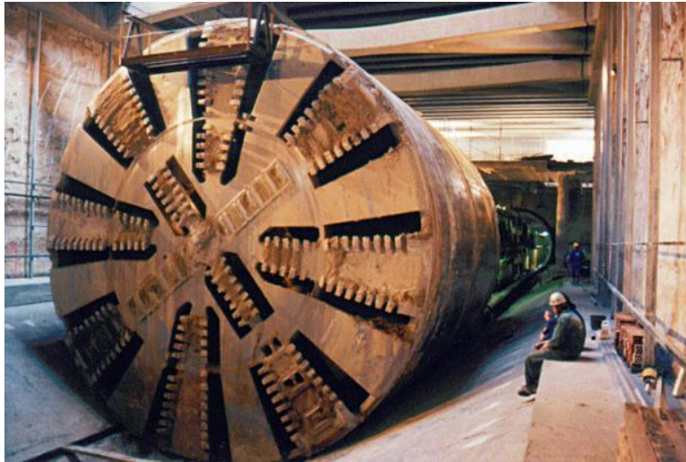
Figura 19. Cabeza de corte de la tuneladora La Almodena. Fuente: Compañía de ecomovilidad, Madrid (2009)
