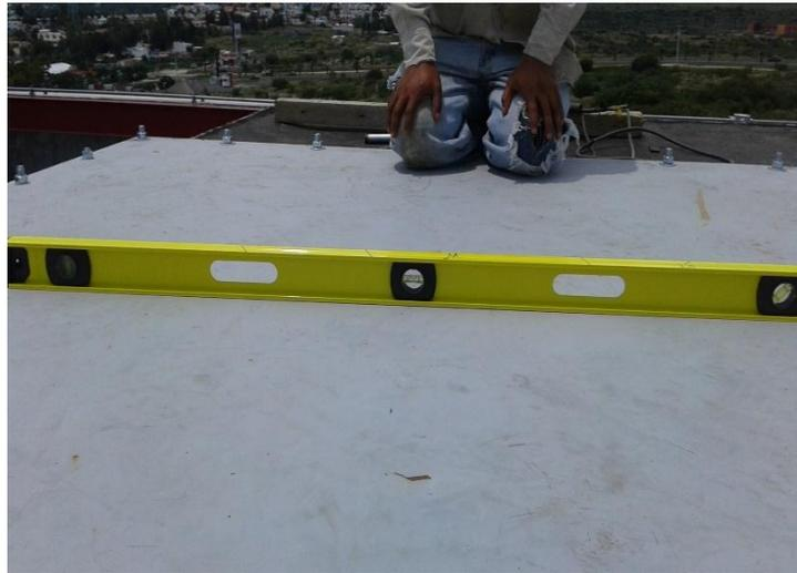
Figura 5.15 Comprobar el nivel de la base de la antena
