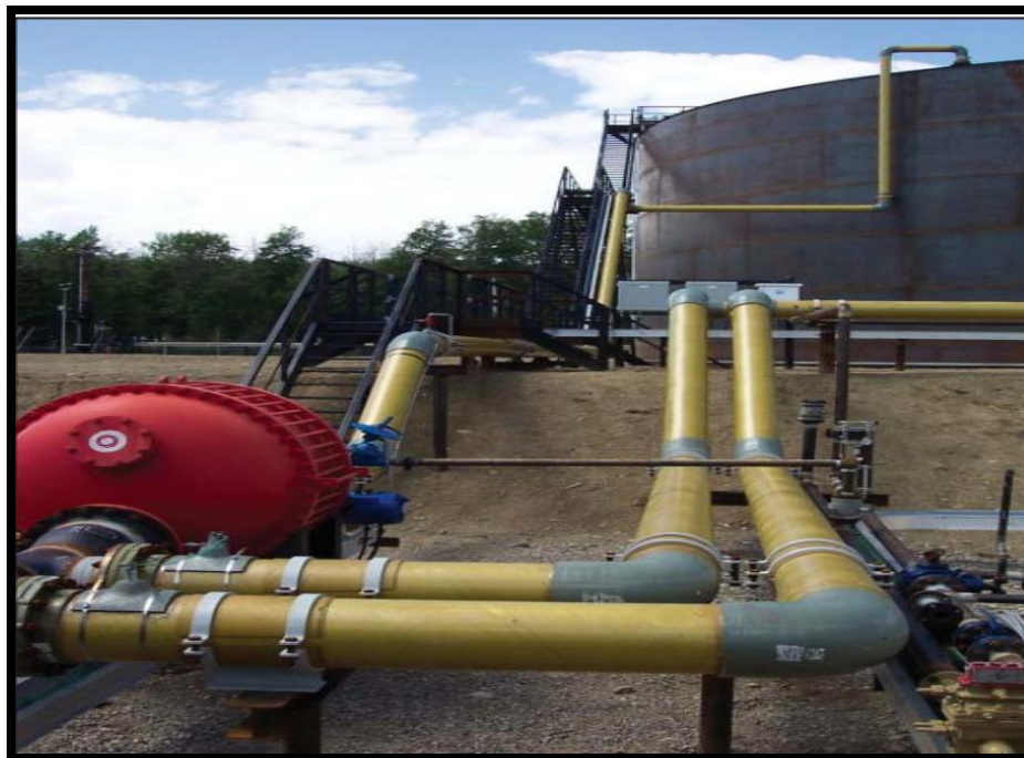
Figura 6.1 Tubería de fibra de vidrio (superficial). Fuente: Tubería de Epóxido reforzada con fibra de vidrio. Fiber Glass Systems.
