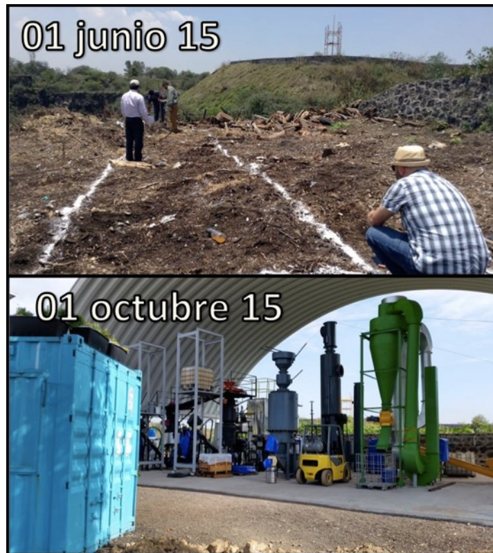
Fotografía 4: Comparativo de avance de construcción. Fuente: G2E.
