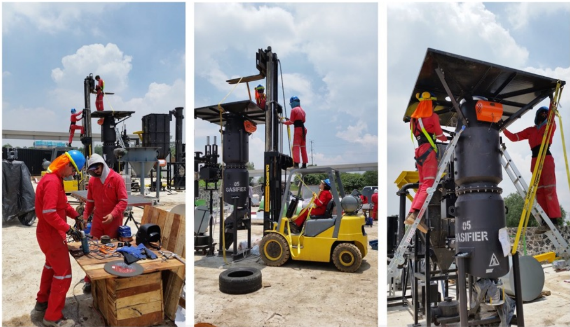
Fotografía 2: Proceso de ensamble de Piro-gasificador. Fuente G2E.
