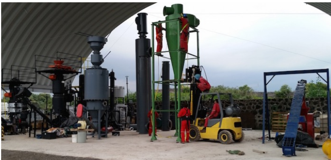
Fotografía 3: Montaje de ciclón del secante. Fuente: G2E.
