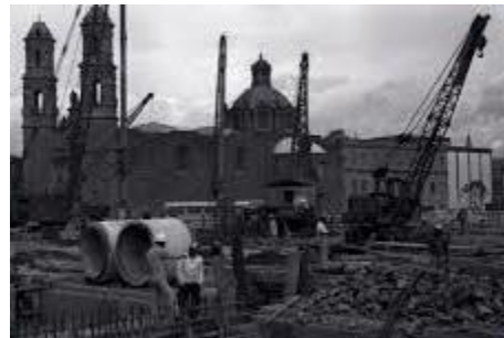
Ilustración 13. Construcción del metro
