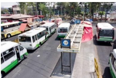
Fotografía 1. Vista al interior del CETRAM Taxqueña
