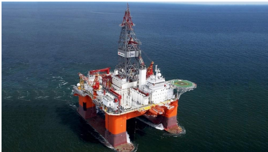
Figura 3 Plataforma Semi-sumergible, Plataforma Bicentenario Pemex.
