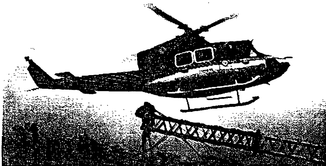
Momentos previos al izaje en el que el liniero engancha a la estructura modular, en el restablecimiento provisional de la línea de transmisión de 230 kV Colima II-93540-Cd Guzmán, por colapso de las estructuras No.79 y 80.
