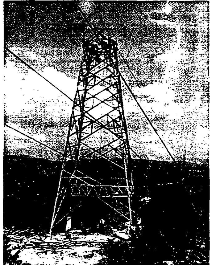
Montaje de estructuras de la línea de transmisión en construcción de 230 kV Mezcala - Los Amates de 140 km de longitud.
