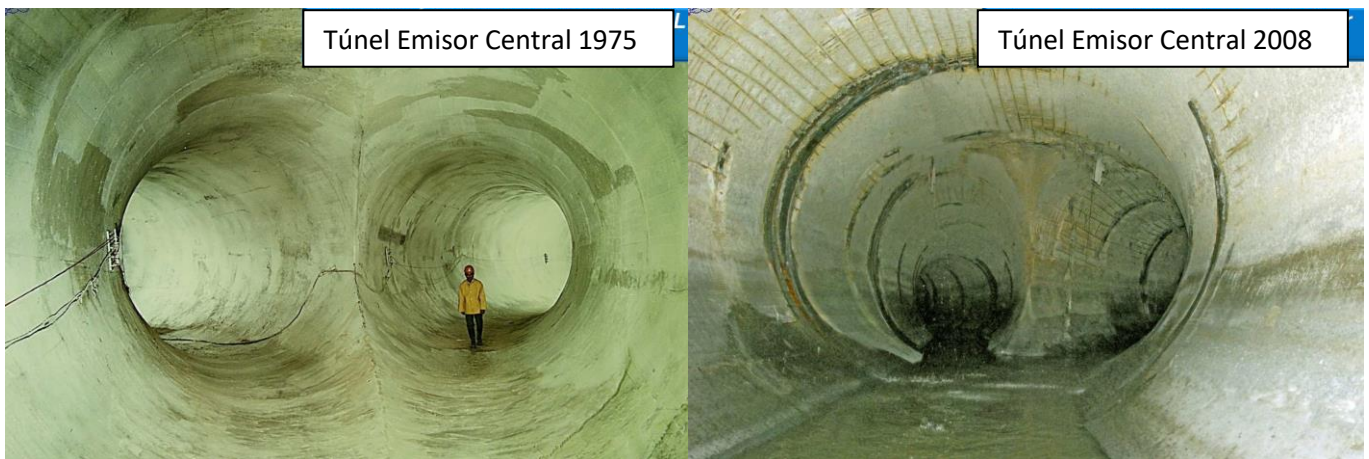
Fig. 7. Confluencia del Interceptor Oriente y Central con el Túnel Emisor Central. A la izquierda se muestra una fotografía de 1975 previo a su inauguración y a la derecha una fotografía que se tomó durante los trabajos de mantenimiento mayor (Moreno, 2014). En la parte baja, se muestra el daño ocasionado por el contacto con las aguas negras; en la sección superior y clave, se observan los daños producidos por los vapores de dichas aguas negras.
