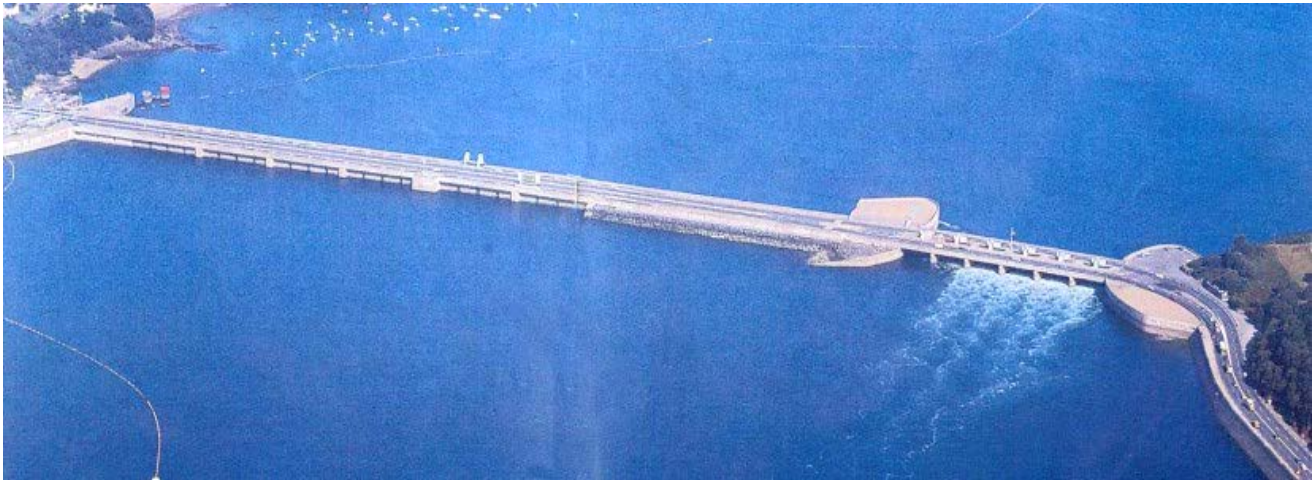
Figura 3.30: Dique en el estuario del Rance, Francia. [91]
