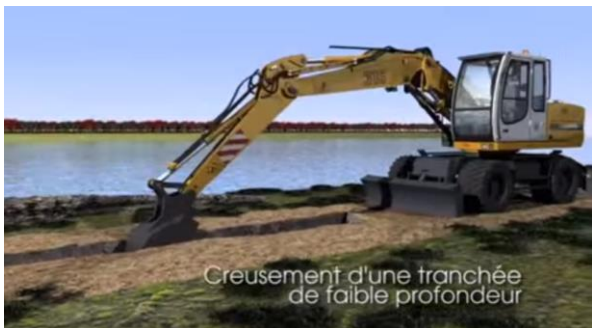
Figura 5.5.a Excavación de zanja guía con excavadora
