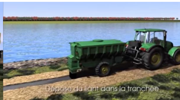
Figura 5.5.b Vertido del cementante en forma líquida en la zanja guía
