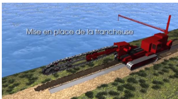
Figura 5.5.c Alineación de la maquinaria en el trazo de la zanja
