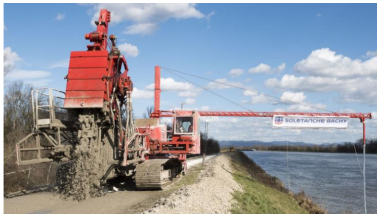
Figura 5.5e Herramienta Trench – Mix® realizando una pantalla impermeable a la orilla de un cuerpo de agua. Referencia: Obras – SOLETANCHE BACHY
