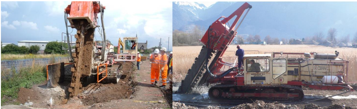
Figura 5.5a Equipo para el corte y mezclado de suelo – cemento que emplea la técnica Trench – Mix.
