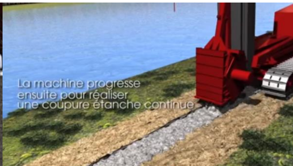
Figura 5.5.d Realización del corte y mezclado del suelo y cemento– Superficie
