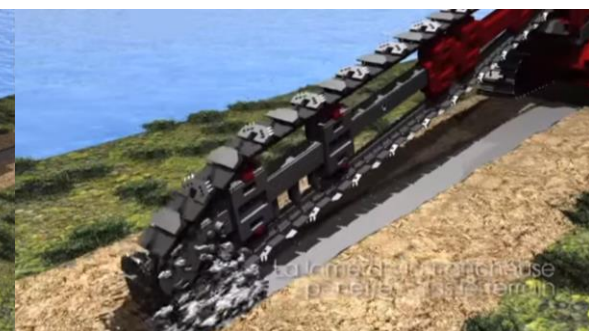
Figura 5.5.d Realización del primer corte de la zanja – Etapa 1
