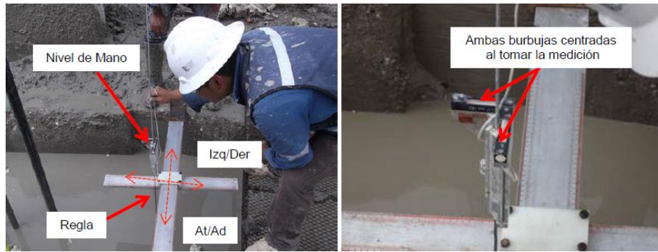
Figura 5.3.1.2b Regletas en forma transversal al brocal con nivel de burbuja en ambos sentidos. Referencia: Obra CIMESA, Reforma 509
