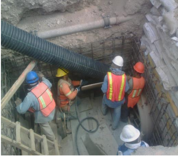
Ilustración 20. Colado de losa de fondo y primer trepado de muros perimetrales en caja, fotografía tomada por el autor, 2017.
