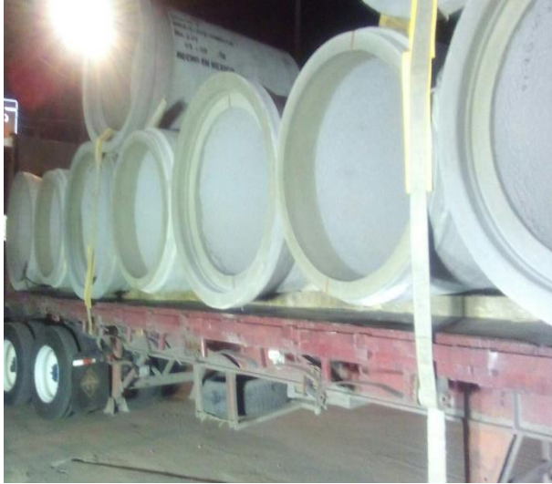
Ilustración 22. Suministro de tubería de concreto reforzado, autor desconocido.
