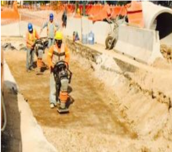
Ilustración 16. Colocación y compactación de capas de relleno. Espíndola A. 2017.
