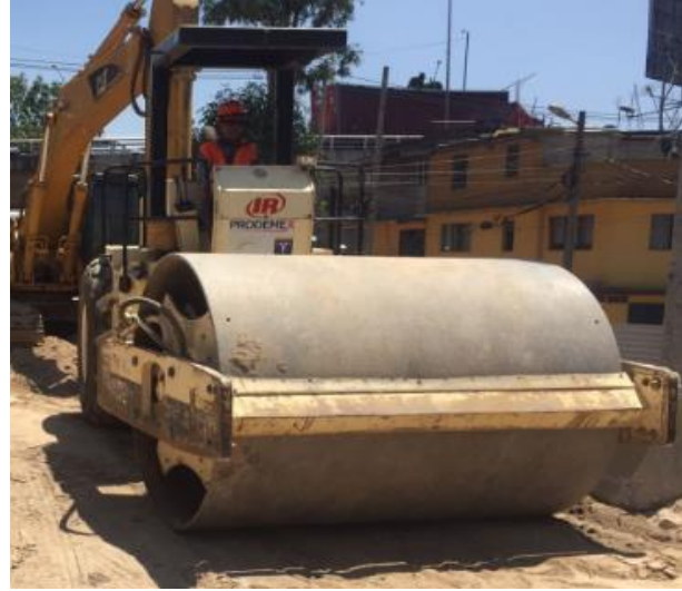
Ilustración 11. Vibro compactador INGERSOLL RAND, Espíndola A. 2017.
