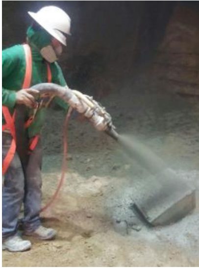
Ilustración 27. Muestreo de artesa para verificación de resistencia a compresión de concreto lanzado, autor desconocido.
