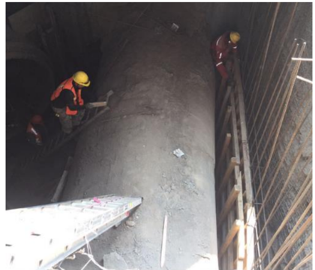
Ilustración 19. Colocación de cimbra en muros perimetrales, Espíndola A. 2017.
