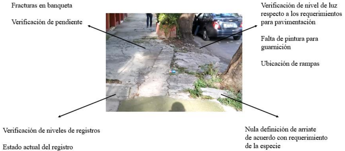
Ilustración 5. Ejemplo de las observaciones derivadas del recorrido en el sitio en el que se ejecutarán los trabajos, fotografía tomada por el autor, 2016.
