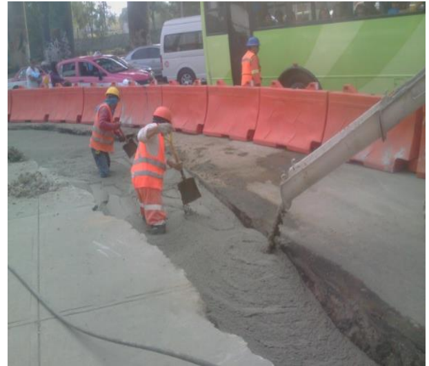
Ilustración 17. Colocación de relleno fluido, Espíndola A. 2017.
