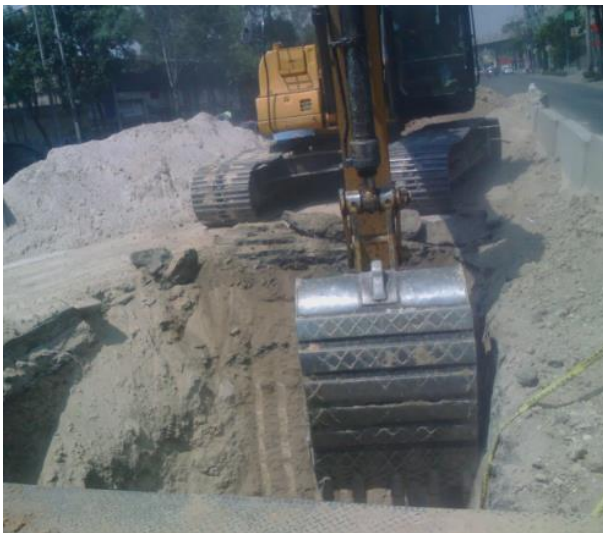
Ilustración 14. Excavación de zanja, Espíndola A. 2017.
