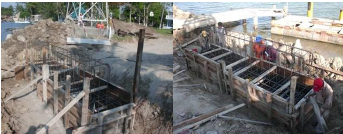
Imagen No.56.-Cimbra y acero de refuerzo para la construcción de la zapata de la trabe T-10.
