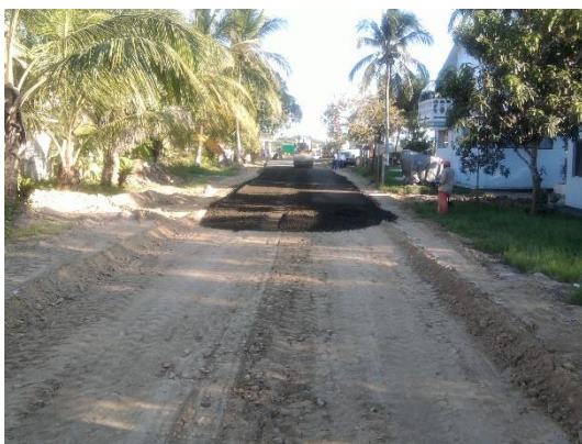
Imagen No.170.-Compactacion con el rodillo metálico vibratorio liso, el material con la humedad óptima para la sub-base del camino de acceso al muelle.
