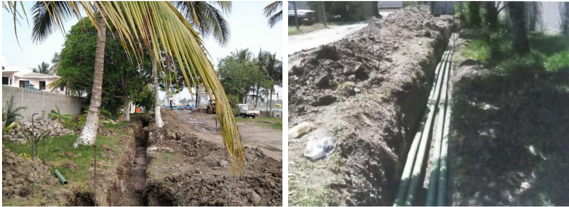
Imagen No.189.- Excavación con retroexcavadora de las cepas y colocación de las tuberías de PVC (canalizaciones).
