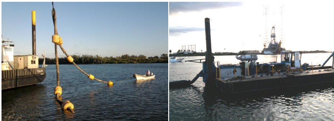
Imagen No.158.- Acoplamiento de la tubería a la draga con apoyo de la grúa y plataforma flotante, en el embalse del rio Tuxpan.
