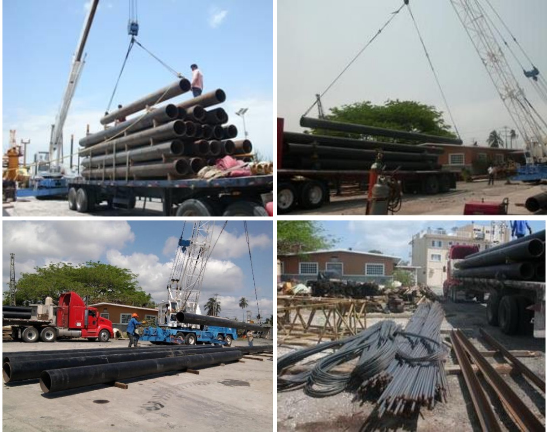
Imagen No.24.- Bodega para los materiales y patio del taller para la fabricación de Pilotes.
