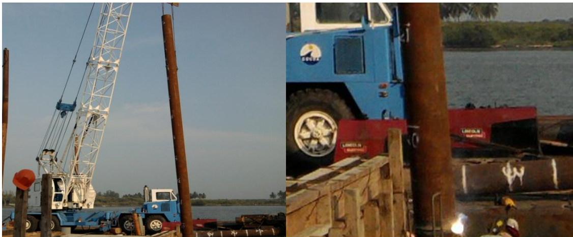
Imagen No.90.- Izado del segundo tramo de pilote para el acoplamiento al primer tramo del pilote ya hincado, realizando el trazo, corte, descabece y aplicación de soldadura.
