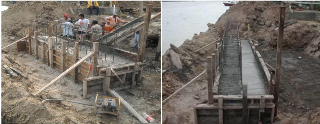
Imagen No.57.-Cimbra, acero y concreto para la construcción de la zapata de la trabe T-10.
