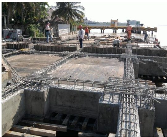
Imagen No.117.- Cimbra de madera para la losa del muelle, en los ejes del 13 al 1 entre los ejes D a G.
