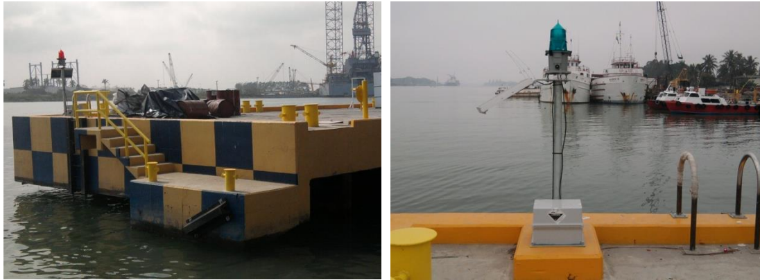
Imagen No.152.- Instalación de balizas con linterna marina roja (babor) y verde (estribor) en muelle del buque.
