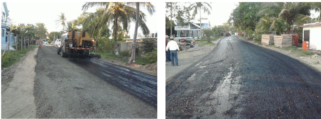
Imagen No.173.-Riego de impregnación y de liga aplicadas con la petrolizadora sobre la base del camino de acceso al muelle.
