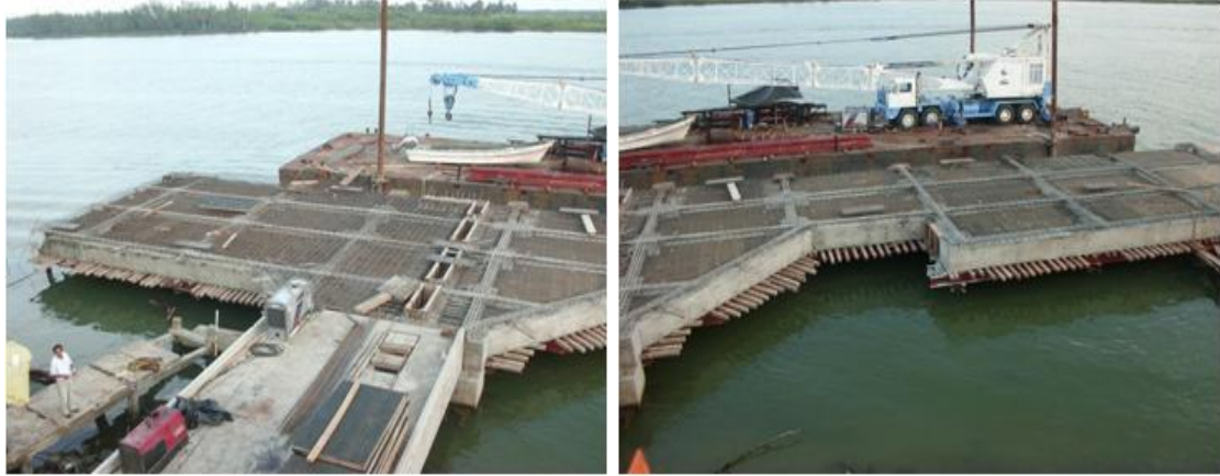
Imagen No.121.- Cimbra, tuberías de PVC, ángulo estructural en trincheras y registros para las instalaciones eléctricas e hidráulicas sobre la losa del muelle.
