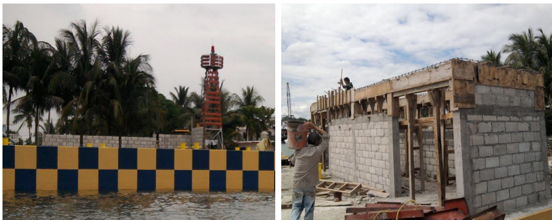
Imagen No.139.- Construcción de la caseta de sistema contra incendios, con muros de block de concreto, castillos, dala perimetral y trabe.
