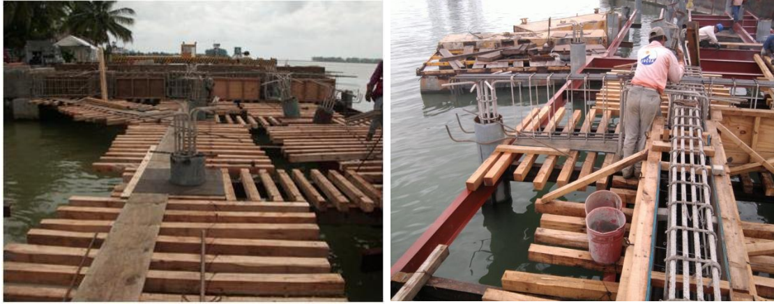
Imagen No.111.- Desplante de cimbra común de madera, habilitados y armados de pilotes, cabezales y trabes en ejes 6, 5, y 4 entre los ejes D a G.
