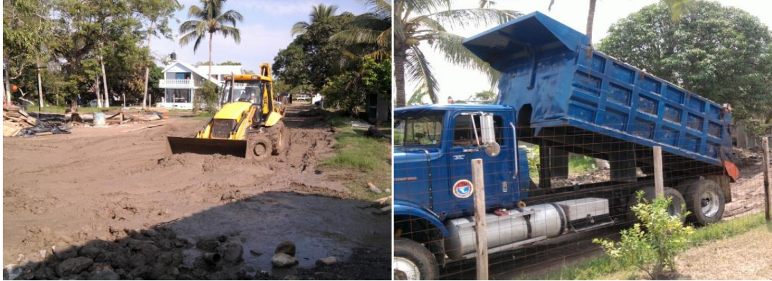
Imagen No.162.-Depósito, carga y acarreo del material producto del dragado, dentro del área del muro de contención (tarquina) en tierra.
