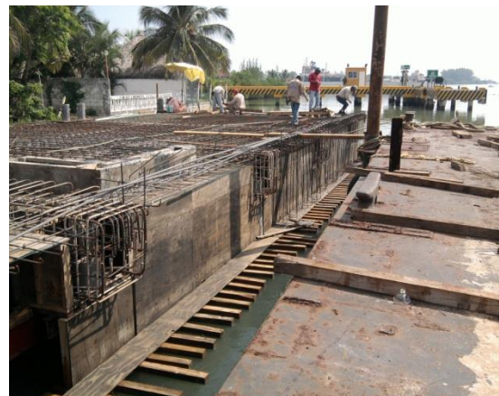
Imagen No.117.- Cimbra de madera para la losa del muelle, en los ejes del 13 al 1 entre los ejes D a G.
