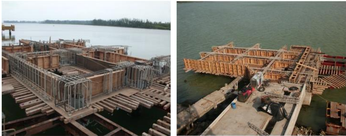
Imagen No.105.- Colocación de cimbra común de madera con desmoldante, así como el habilitado y armado de acero de refuerzo en pilotes, cabezales y traveses de los ejes 13, 12, 11 y 7 entre los ejes D a G.
