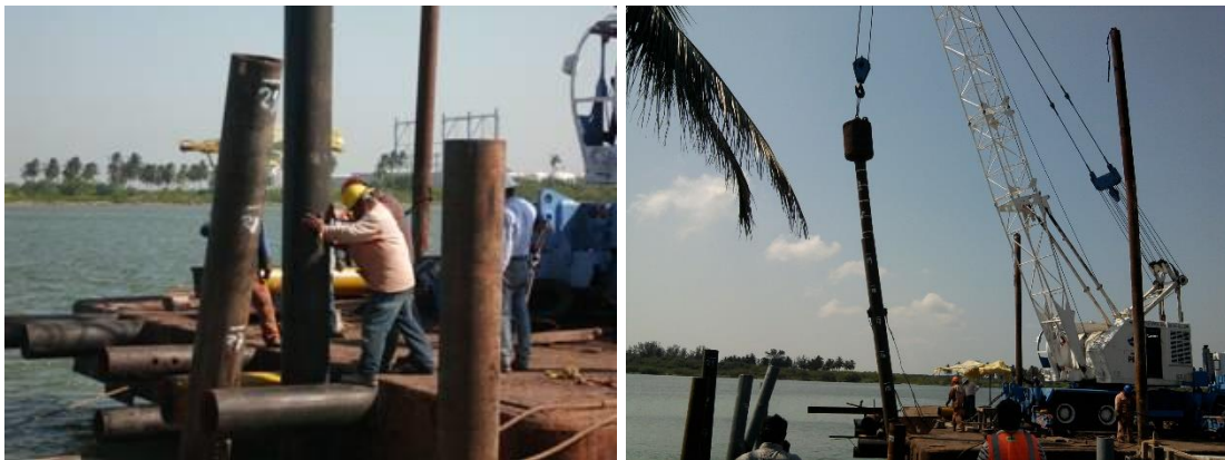
Imagen No.92.- Maniobras, izado, trazos, ángulo de inclinación, posición e hincado del primer tramo del pilote inclinado (PI-28).
