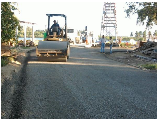
Imagen No.172.-Compactador de rodillo metálico vibratorio liso, compactando el material con la humedad óptima para la base a lo largo del camino de acceso al muelle.
