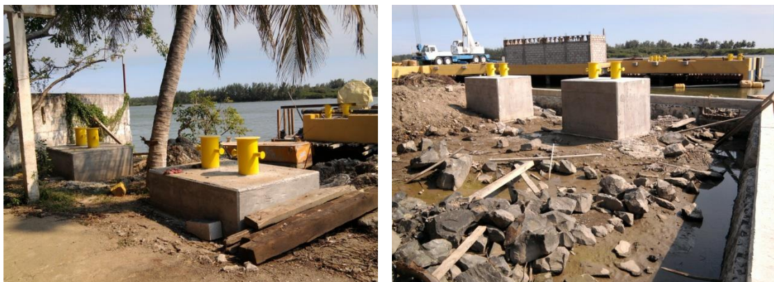
Imagen No.144.- Aplicación de pintura en bitas dobles de amarre para el buque en tierra.
