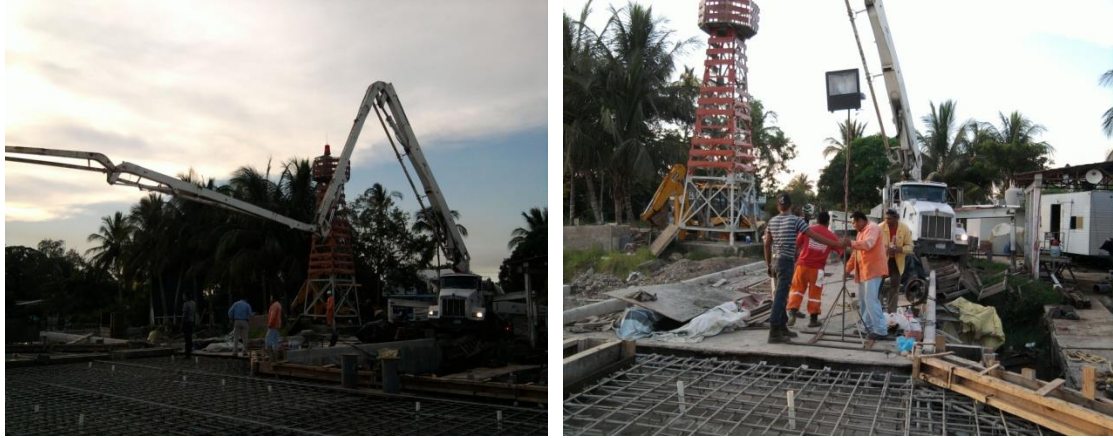
Imagen No.126.- Bomba estacionaria con pluma telescópica, para la colocación del concreto en la trabe T-4, guarniciones y losa del muelle.
