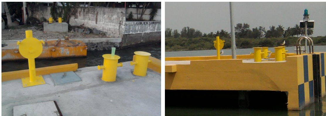
Imagen No.150.- Instalación de tres soportes para salvavidas anular en muelle del buque.
