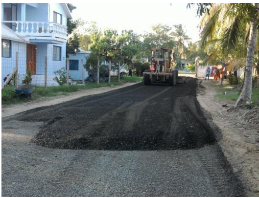
Imagen No.171.-Extendido y Mezclado del material con la Motoconformadora para la base del camino de acceso al muelle.
