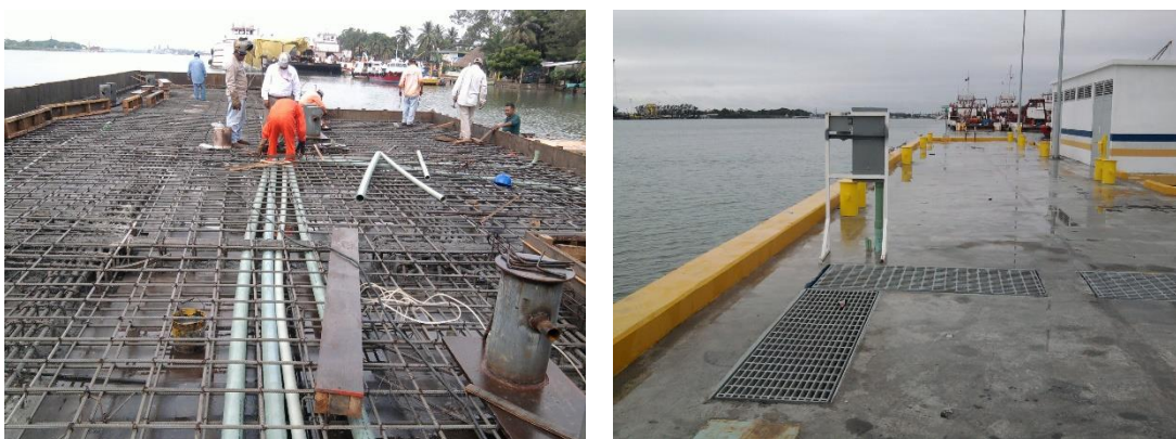
Imagen No.183.- Trabajos previos para las instalaciones eléctricas e hidráulicas, ahogadas en la plataforma del muelle.
