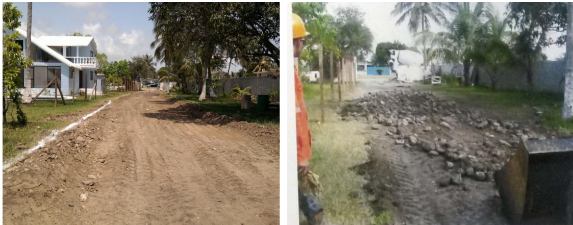
Imagen No.36.- Excavación y mejoramiento a base de gravarena del camino de acceso al muelle.
