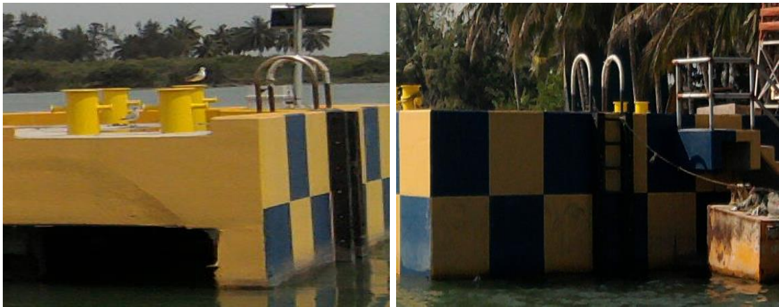
Imagen No.149.- Instalación de escaleras marinas en muelle del buque.
