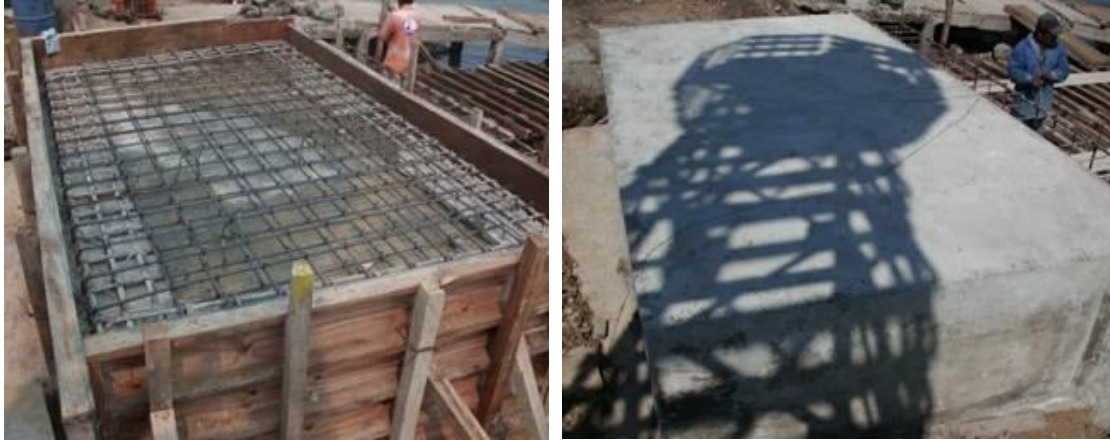
Imagen No.64.- Relleno de tepetate compactado, acero de refuerzo y concreto para losa de la rampa de concreto, acceso al muelle.
