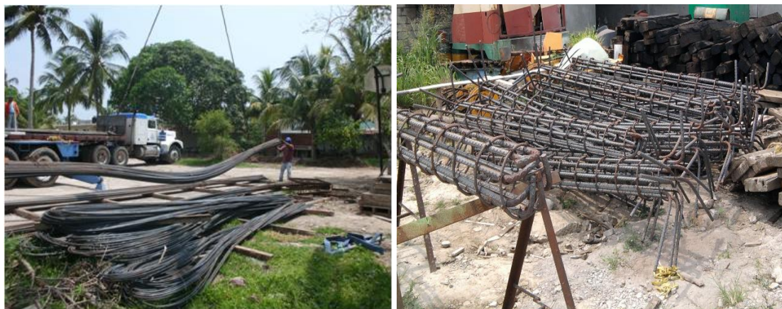
Imagen No.47.- Suministro, habilitado y armado de acero de refuerzo de pilotes en la obra.
