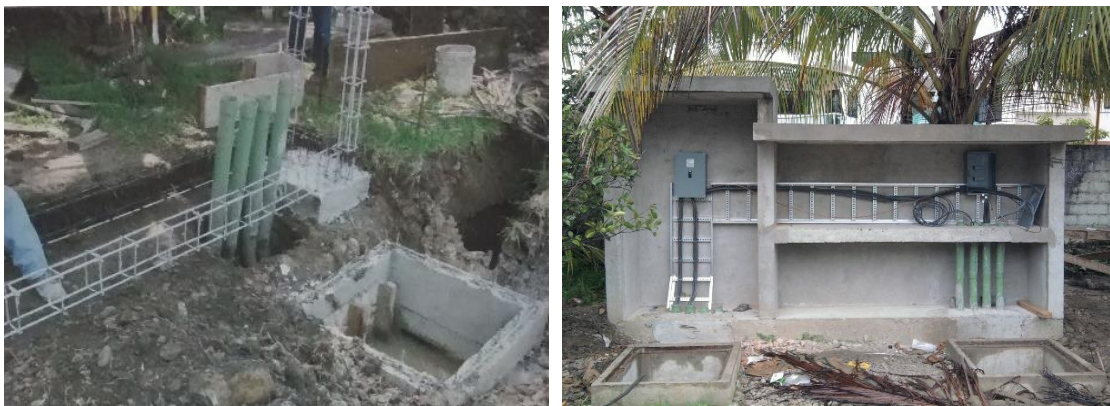
Imagen No.192.- Colocación de registro prefabricados y construcción de nicho para el control de la iluminación del muelle.
