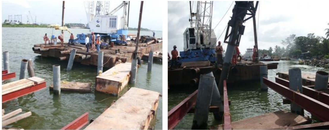
Imagen No.103.- Hincado de los pilotes verticales (PV) e inclinados (PI), de los ejes 6, 5 y 4 entre los ejes D a G.
