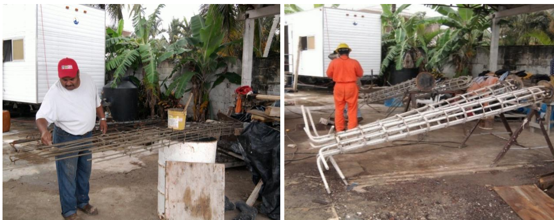
Imagen No.48.- Pintura primario RPB4 y acabado RE32, en el acero de refuerzo.
