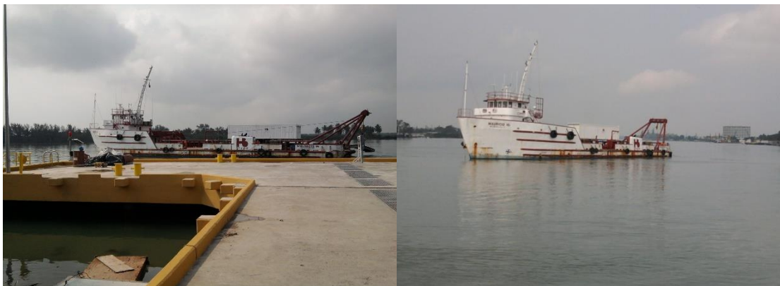
Imagen No.165.-Buque con viga de acero realizando rastrillado, dando varias pasadas frente al muelle del buque Justo Sierra, para dar nivelación en el canal de navegación interior del río Tuxpan.
