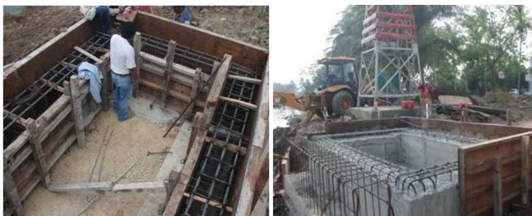
Imagen No.63.- Acero de refuerzo, cimbra y concreto en las traveses de la rampa de acceso al muelle.
