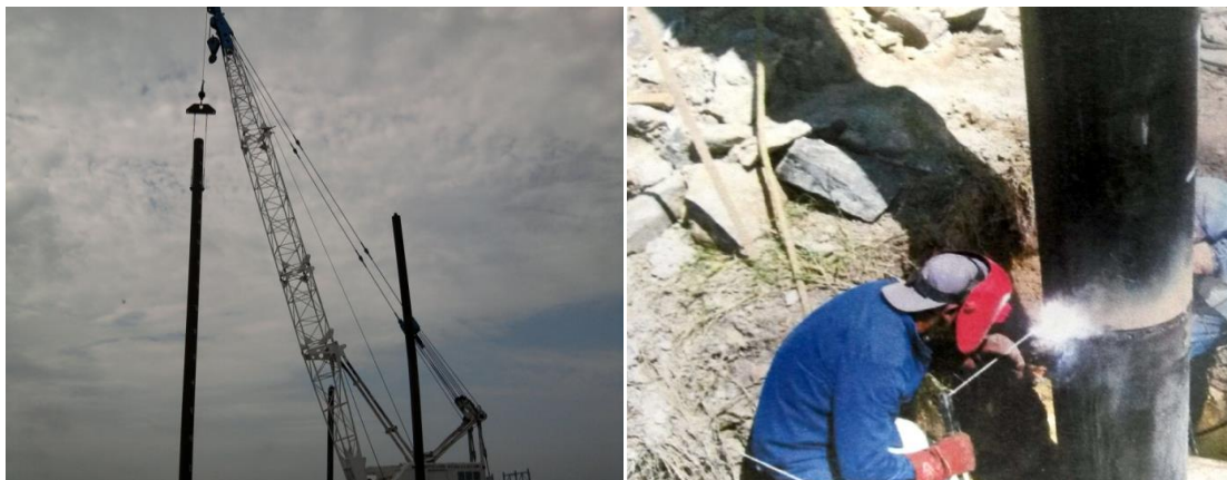
Imagen No.53.- hincado del primer tramo y aplicación de soldadura para la unión del segundo al primer tramo del pilote, para la cimentación de la trabe T-10.
