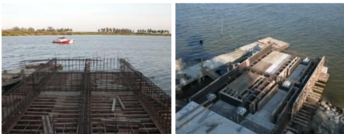
Imagen No.79.- Colocación de acero de refuerzo, cimbra de madera para las traves, trincheras y losa, en la construcción de la pasarela de acceso al muelle en río.
