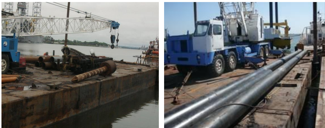
Imagen No.44.- Chalán (balsa) con grúa para montaje de pilotes y traslado de equipos y materiales del almacén a la obra.
