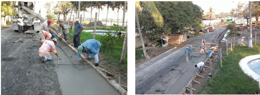
Imagen No.179.-Vaciado, extendido y pulido del concreto premezclado f'c=200\text{Kg/cm}^2 , para la construcción de las cunetas del camino de acceso al muelle.
