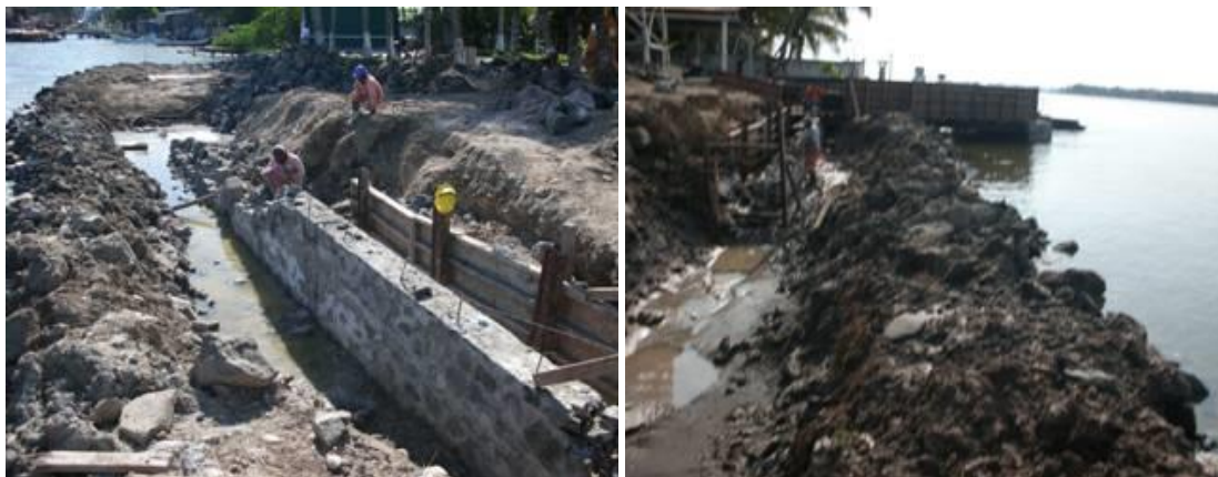
Imagen No.68.- Desplante del muro de contención y ademe con viguetas y madera, para la contención del terreno y protección de la baliza existente.
