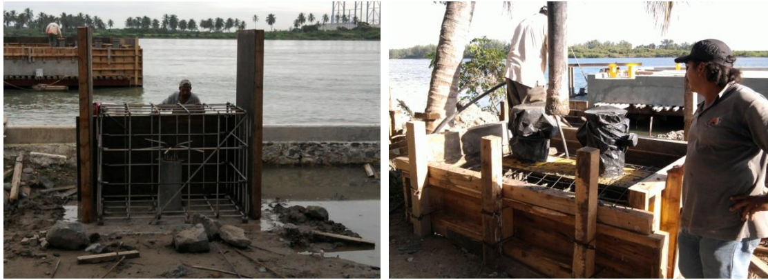
Imagen No.143.- Cimbra común de madera, acero de refuerzo, y colocación de bitas dobles de amarre del buque en tierra.
