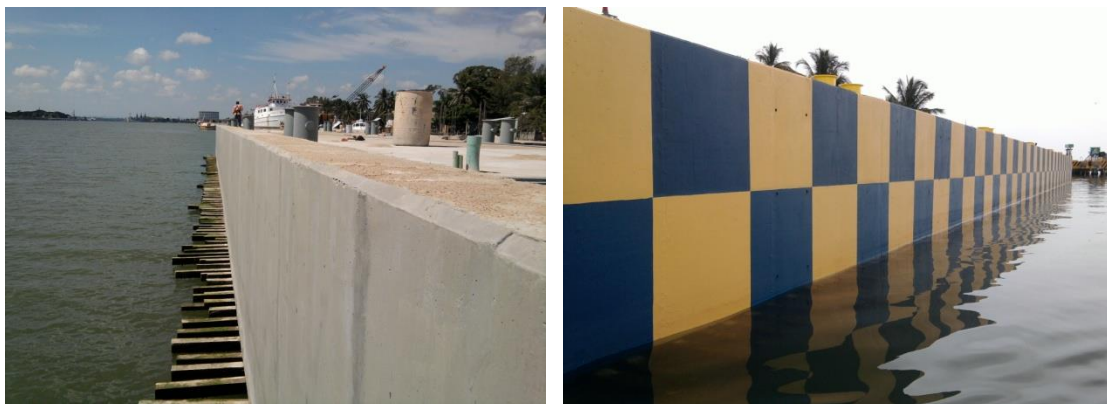
Imagen No.146.- Limpieza, trazo, y aplicación de pintura color azul y oro, a base de pintura inorgánica de zinc autocurante silicato base de solvente, marca COMEX, en pantalla de atraque del muelle.
