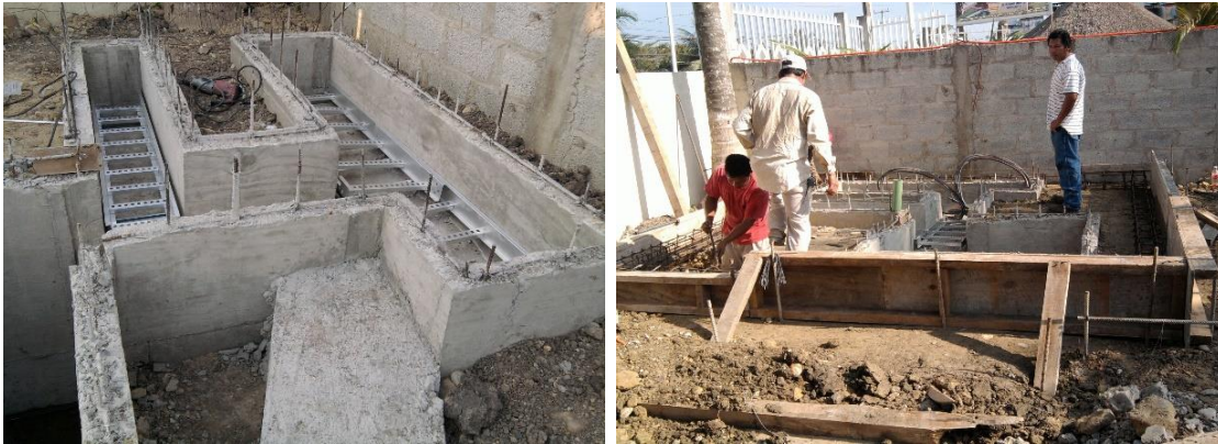
Imagen No.184.- Construcción de dalas de desplantes y trincheras para la caseta de la subestación eléctrica.
