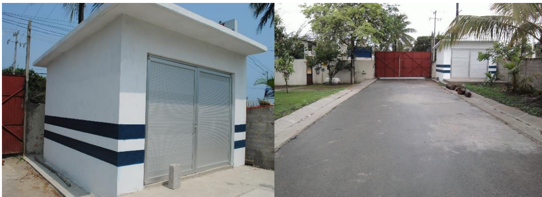
Imagen No.186.- Caseta de la subestación eléctrica en la entrada del predio de la Base de Operaciones Oceanográficas y del muelle del buque “Justo Sierra”.
