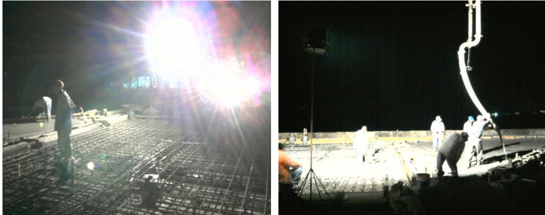
Imagen No.130.- Continuando con el colado de la trabe T-4, guarniciones y losa del muelle, con alumbrado provisional.
