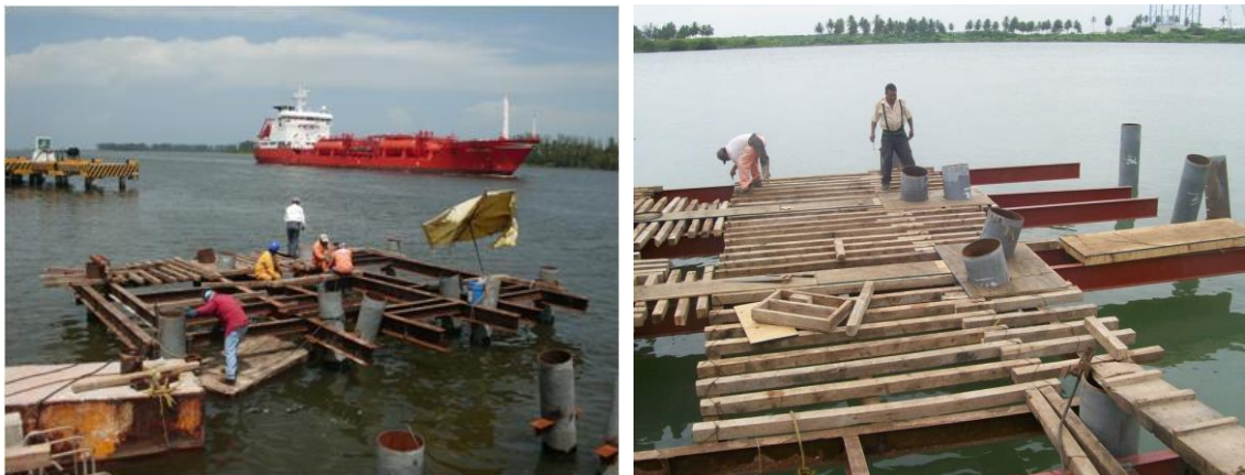
Imagen No.100.- Colocación de arrastre de la cimbra de madera para desplante y construcción de las superestructuras del muelle.
