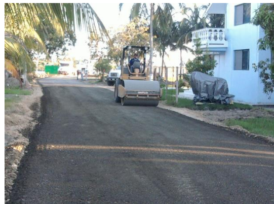
Imagen No.172.-Compactador de rodillo metálico vibratorio liso, compactando el material con la humedad óptima para la base a lo largo del camino de acceso al muelle.
