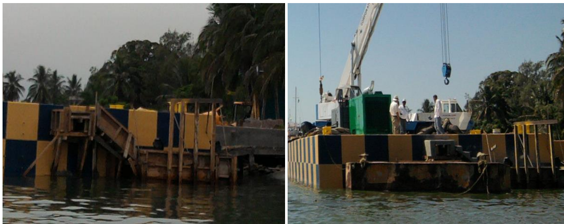
Imagen No.137.- Colocación de concreto premezclado ( f'c=350 \text{ Kg/cm}^2 ), para la construcción de las trabes (T-1), losa y escalera, para el muelle de lanchas.
