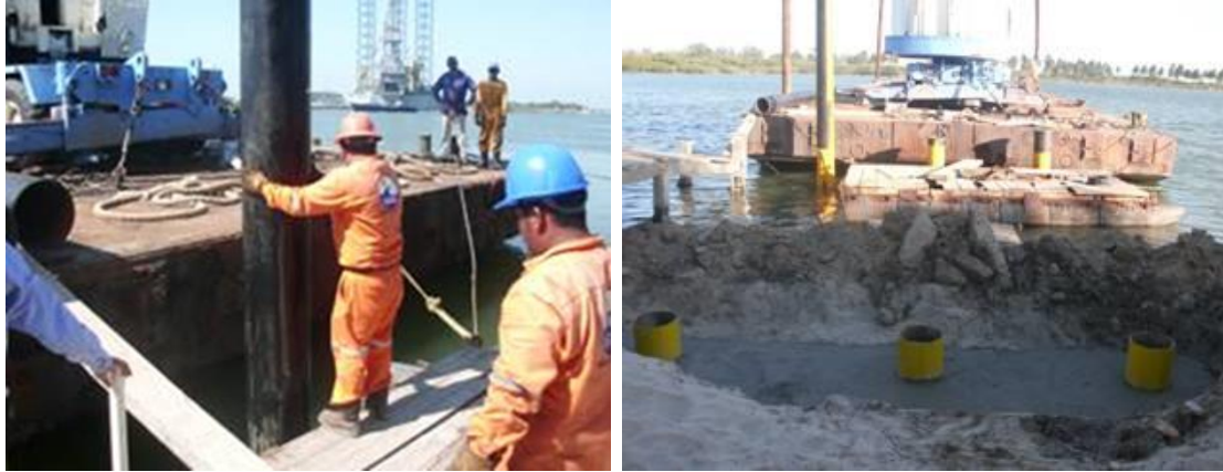
Imagen No.72.- Izado, hincado y ubicación de pilotes verticales en el río para la trabe T-8.
