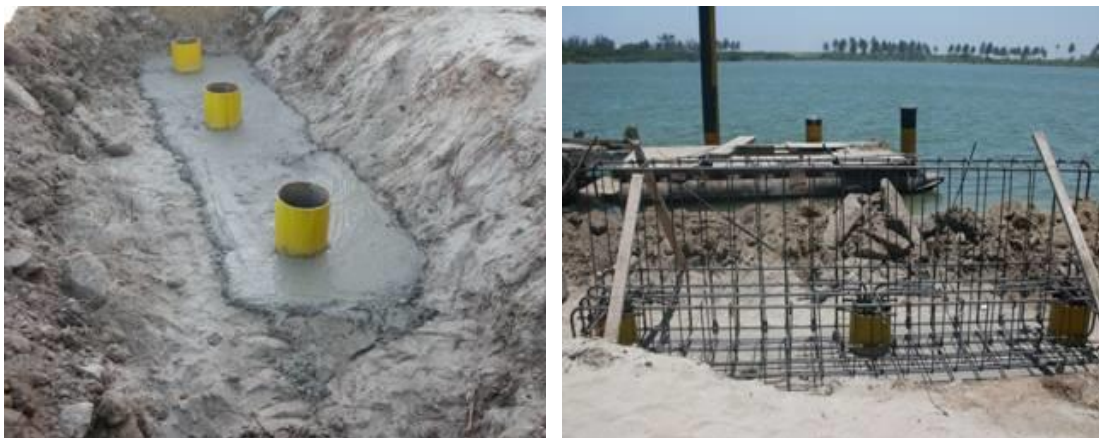
Imagen No.55.- Hincado de los tres pilotes, plantilla y acero de refuerzo en pilotes y trabe T-10.
