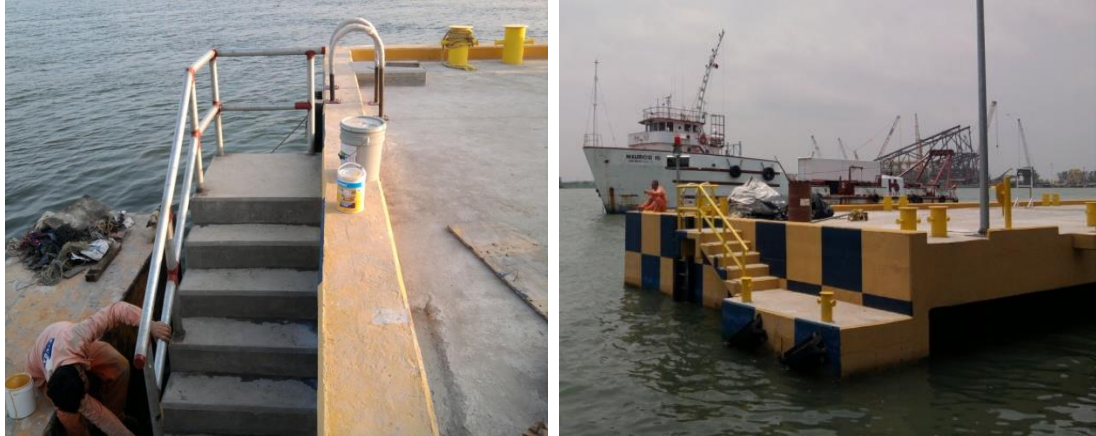
Imagen No.138.- Colocación de bitas sencillas, defensas y barandal metálicos pintados de color amarillo, del muelle de lanchas.
