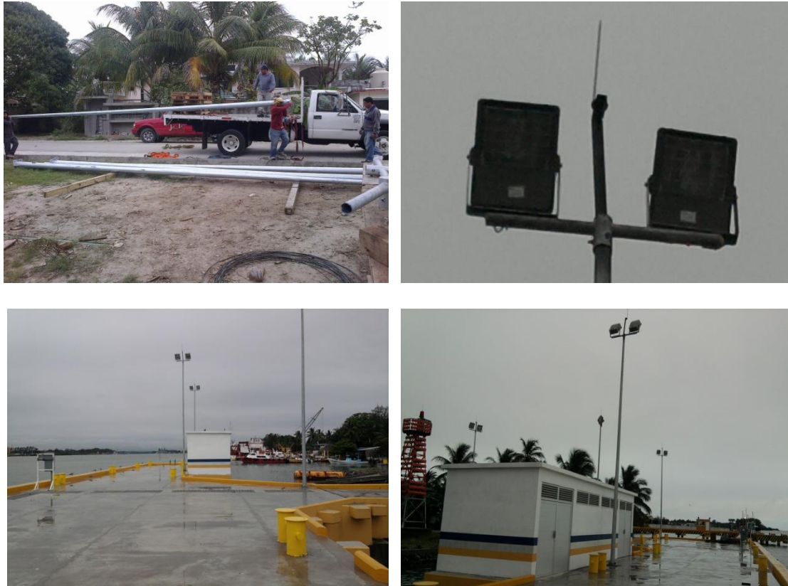
Imagen No.151.- Instalación de cinco postes, con puntas Faraday (pararrayos) y diez lámparas de 400 watts de vapor de sodio de alta presión, en muelle del buque.
