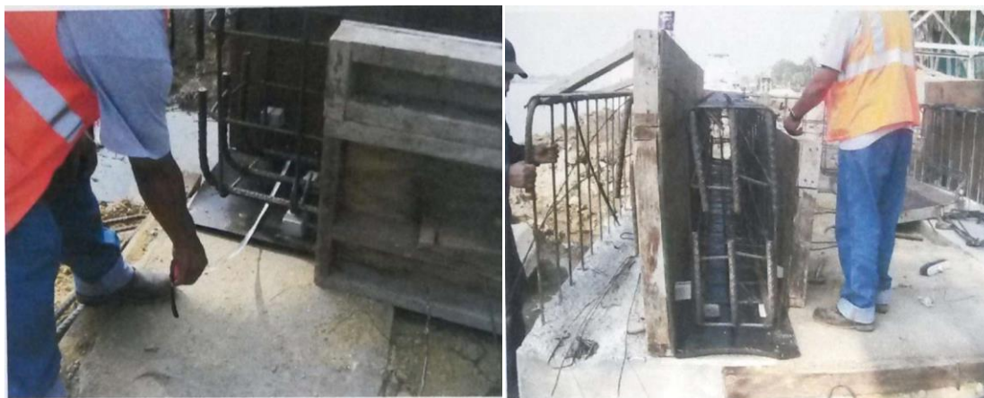
Imagen No.62.-Colocacion de junta de neopreno de 12.7 mm (1/2") de espesor entre las traveses de la rampa de acceso al muelle y la trabe T-10.
