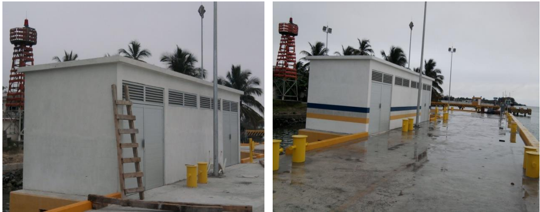
Imagen No.141.- Acabados en interior y exterior de la caseta de sistema contra incendios, aplanados, acabados de pintura y cancelería.
