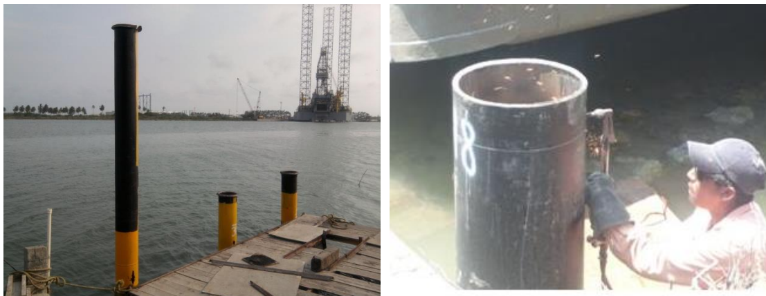
Imagen No.73.- Hincado y descabece de pilotes verticales de acero en el río.
