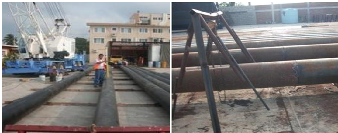
Imagen No.40.- Alineado y Atiesado para la aplicación de soldadura en pilotes
