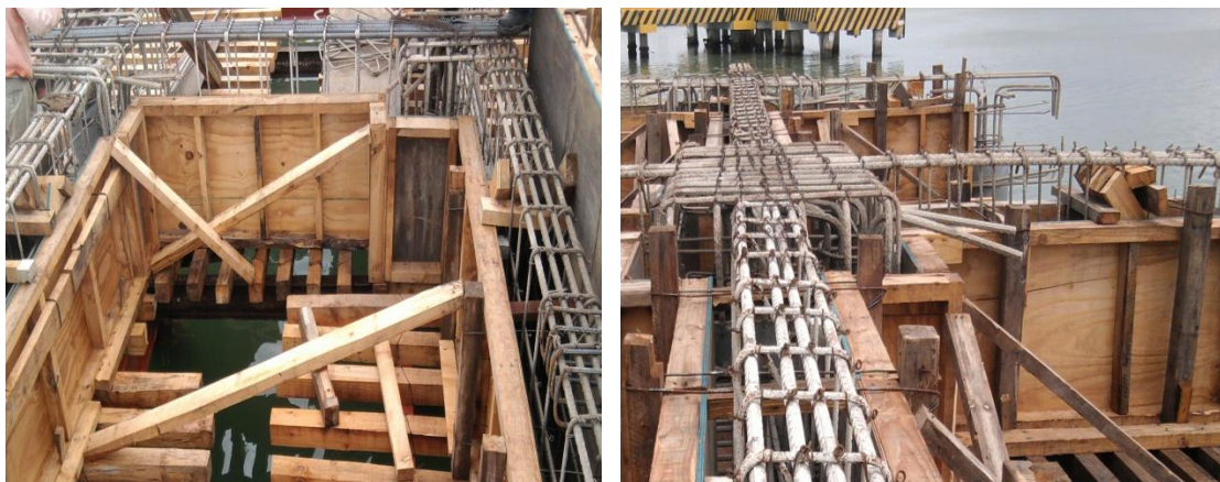
Imagen No.106.- Colocación de tapón a base de polines y barrotes en traveses de los ejes 13, 12, 11 y 7 entre los ejes D a G, tramos pendientes para armar y colar monóticamente con la trabe (T-4) pantalla.
