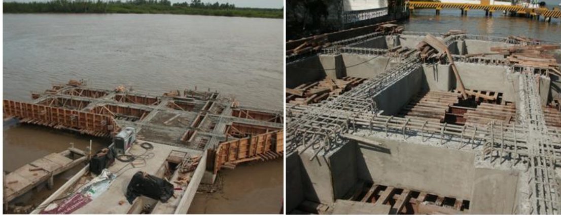
Imagen No.108.- Descimbrado y curado de los cabezales y traveses, entre los ejes 13, 12, 11, y 7 del eje D a G, del muelle.
