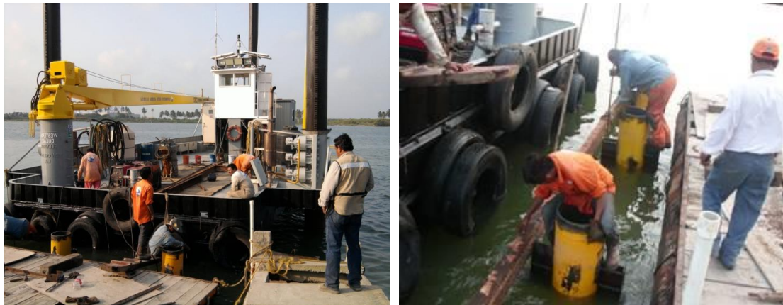
Imagen No.74.- Habilitado, colocación y soldado de ménsulas, para apoyo de la obra falsa de la trabe T-8 en el río.
