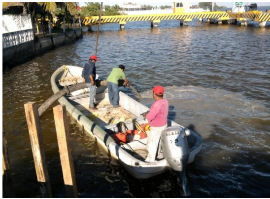
Imagen No.160.-Draga hidráulica de succión, probando el sistema de inyección de agua a presión (bomba tipo JET) y descarga del material producto del dragado, realizadas en las áreas de la dársena y maniobras para el buque oceanográfico, en el río Tuxpan.
