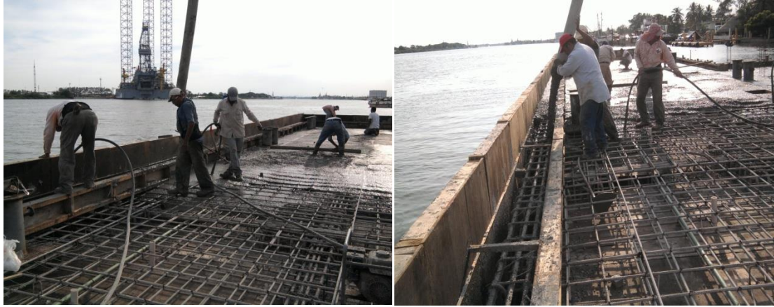
Imagen No.128.- Colocación y acomodo del concreto con los vibradores, extendiendo el concreto con pala, cuchara y regla para dar los niveles y acabado pulido con llana metálica en la trabe T-4, guarniciones y losa del muelle.
