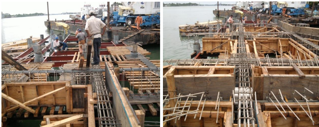
Imagen No.112.- Cimbra con canalones de madera y armados de acero de refuerzo de pilotes, cabezales y trabes, de ejes 6, 5, y 4 entre ejes D a G.
