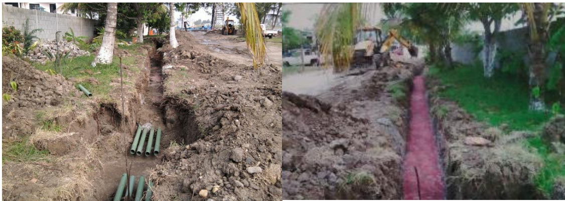
Imagen No.190.- Relleno compactado de arena y colocación de firme de 10 cm sobre las canalizaciones de las tuberías de PVC, para la acometida de la subestación eléctrica al muelle.
