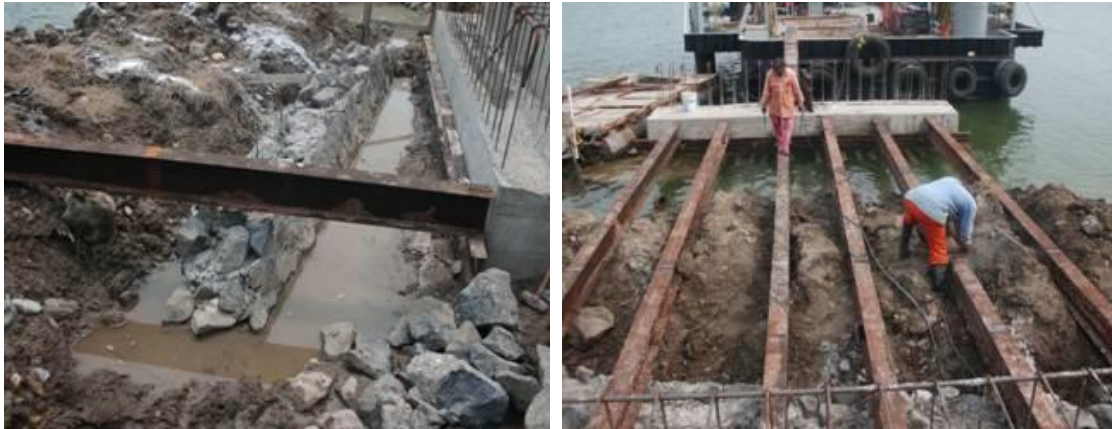
Imagen No.70.- Construcción del muro de contención y obra falsa a base de viguetas, para la construcción de la pasarela acceso al muelle.
