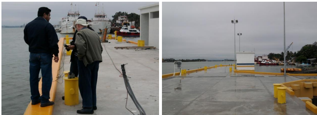
Imagen No.147.- Aplicación de pintura para tráfico pesado en guarniciones del muelle.
