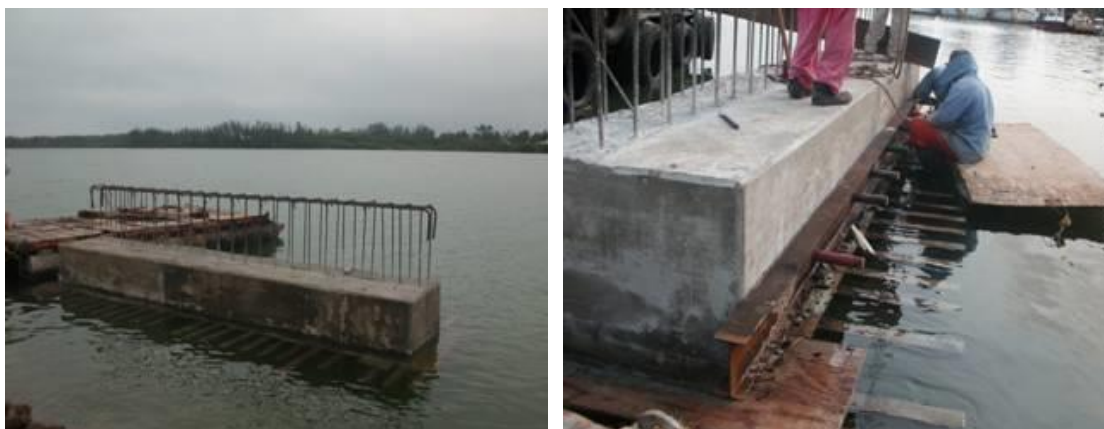
Imagen No.76.- Instalación de vigueta IPR tipo I de 6"x4" de acero estructural sobre la trabe T-8 en río.
