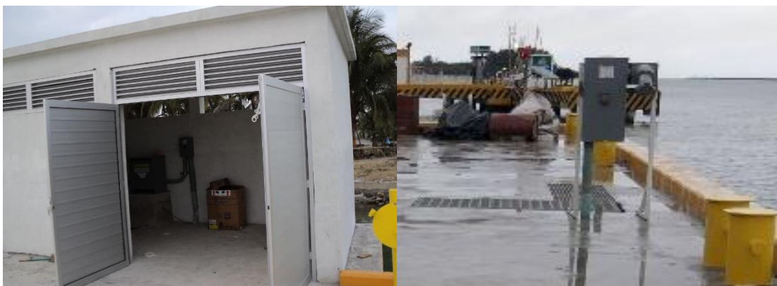
Imagen No.194.- Acometida eléctrica en la caseta contra incendios y el contacto de toma de corriente durante el atraque del Buque Oceanográfico.
