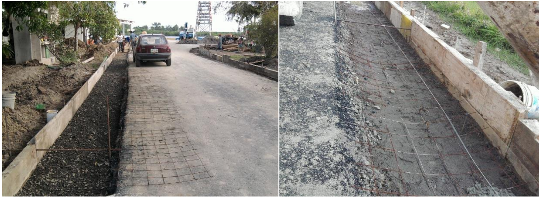
Imagen No.178.-Cama de arena humedecida compactada y cimbra de madera en fronteras de las cunetas del Camino de Acceso al Muelle.
