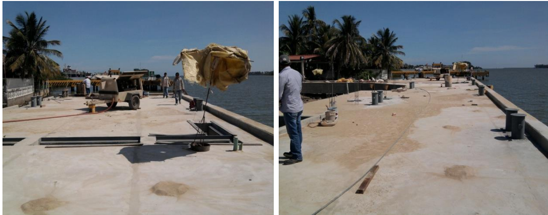
Imagen No.145.- Limpieza de la losa del muelle a base de presión de aire con compresor y retiro de materiales sobrantes en el muelle.
