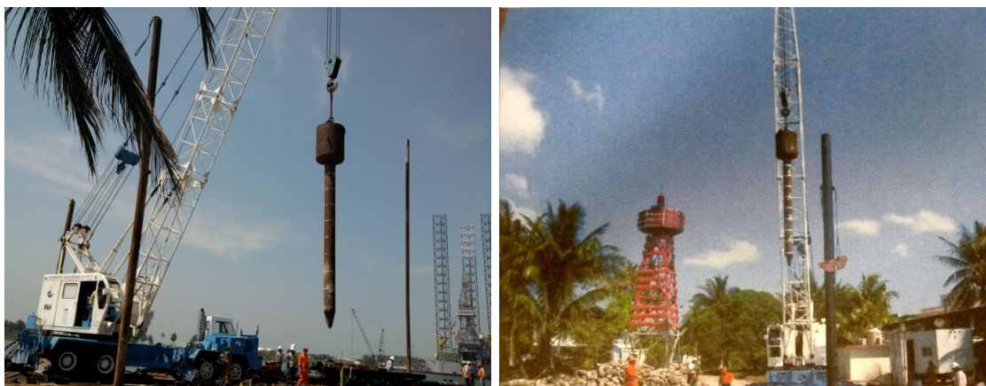
Imagen No.54.- Hincado del segundo pilote con pilón (5.235Ton.), para la cimentación de la trabe T-10.
