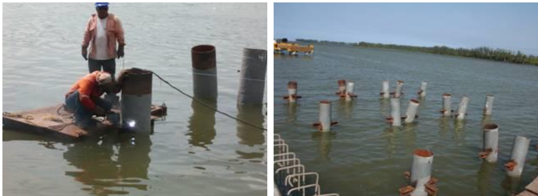
Imagen No.98.- Colocación y soldado de ménsulas en los pilotes, a base de tramos de viguetas IPR tipo I de 6"x4" para la obra falsa.
