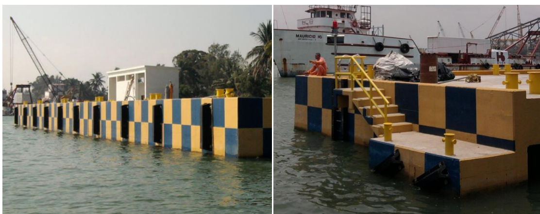
Imagen No.148.- Instalación de diez defensas marinas en muelle del buque y barandal con dos defensas en muelle de lanchas.
