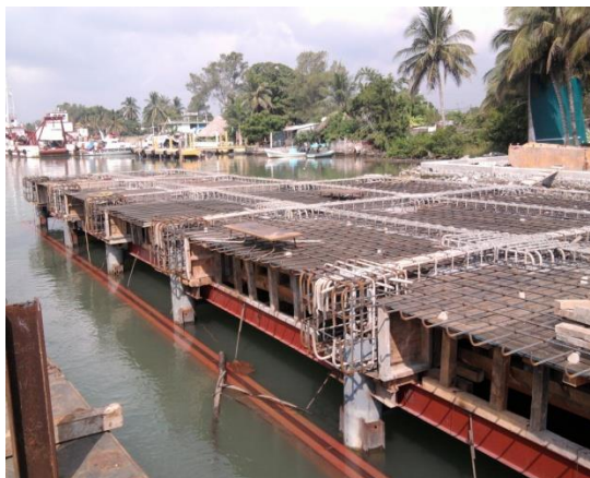
Imagen No.117.- Cimbra de madera para la losa del muelle, en los ejes del 13 al 1 entre los ejes D a G.
