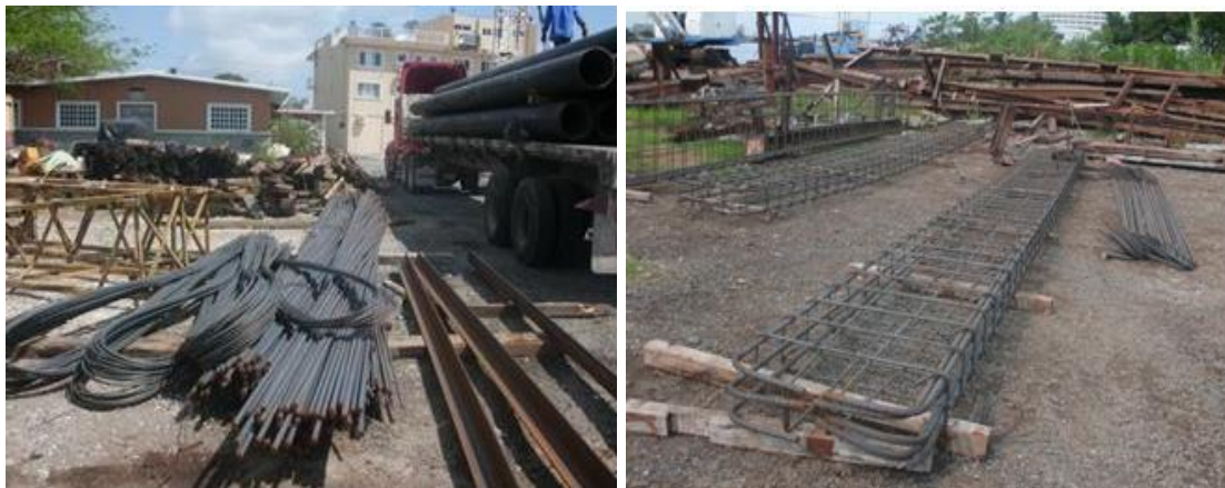
Imagen No.46.- Suministro, habilitado y armado de traveses en patio de bodega del contratista.
