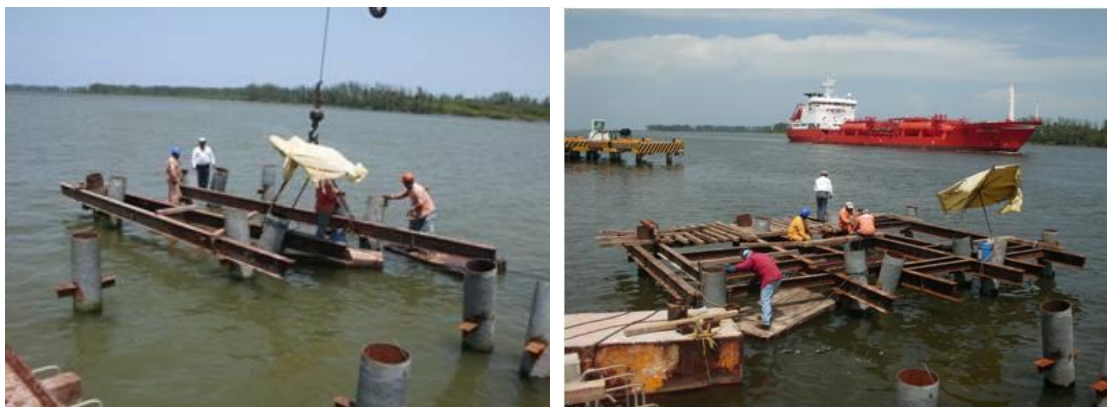
Imagen No.99.- Colocación de la obra falsa, a base de viguetas IPR tipo I de 12"x6.5", para desplante y cimbrado de las traves, de las superestructuras del muelle.
