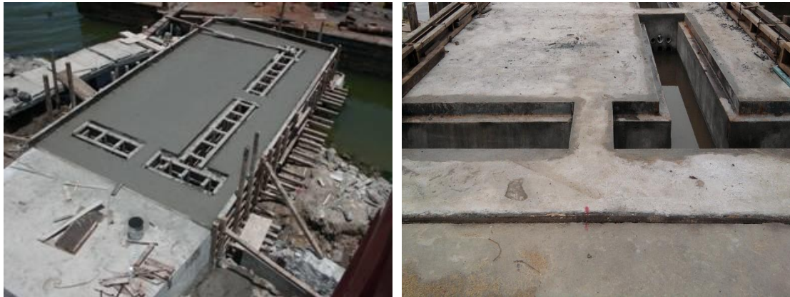
Imágenes No.82.- Colocación de concreto y juntas constructivas, en la pasarela de acceso al muelle en río.
