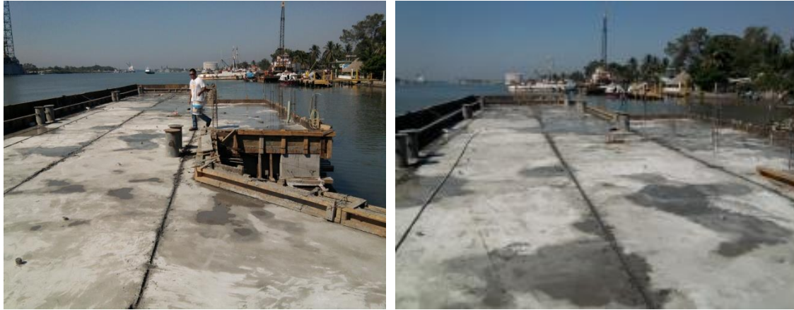
Imagen No.134.- Construcción de juntas en la losa del muelle.
