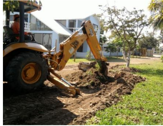
Imagen No.26.- Trazo, despalme de arbustos, pasto y árboles sobre el Camino de Acceso al Muelle.
