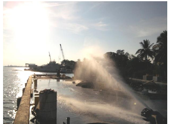
Imagen No.160.-Draga hidráulica de succión, probando el sistema de inyección de agua a presión (bomba tipo JET) y descarga del material producto del dragado, realizadas en las áreas de la dársena y maniobras para el buque oceanográfico, en el río Tuxpan.
