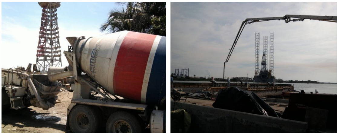
Imagen No.127.- Colocación del concreto en la trabe T-4, guarniciones y losa del muelle, del eje 1 al 7 entre G a D.
