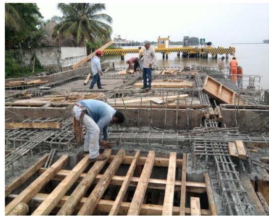
Imagen No.117.- Cimbra de madera para la losa del muelle, en los ejes del 13 al 1 entre los ejes D a G.
