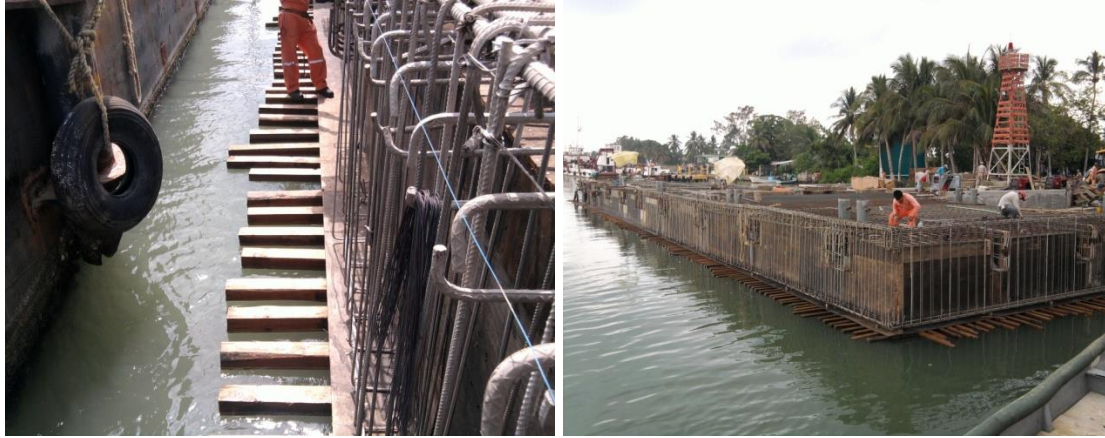
Imagen No.120.- Cimbra de madera y acero de refuerzo para el armado de la trabe pantalla de atraque (T-4).
