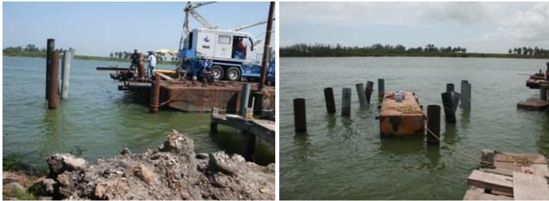
Imagen No.96.- Hincado de pilotes en los ejes 13 y 12 entre los ejes D a G.
