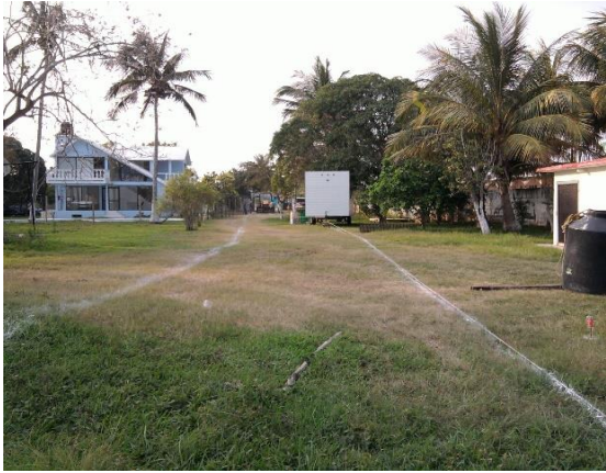
Imagen No.26.- Trazo, despalme de arbustos, pasto y árboles sobre el Camino de Acceso al Muelle.
