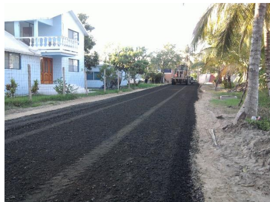
Imagen No.171.-Extendido y Mezclado del material con la Motoconformadora para la base del camino de acceso al muelle.
