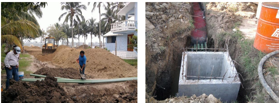
Imagen No.182.-Trabajos previos de las instalaciones eléctricas para los cruces en el camino de acceso al muelle.
