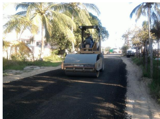
Imagen No.170.-Compactacion con el rodillo metálico vibratorio liso, el material con la humedad óptima para la sub-base del camino de acceso al muelle.
