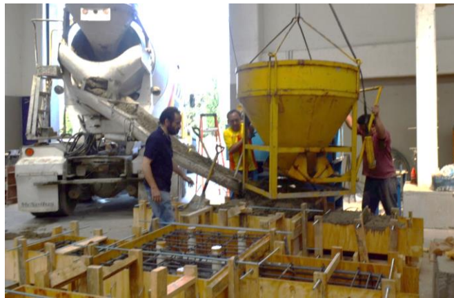
Figura 3.4: Colado del concreto en los modelos.
