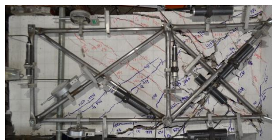
d) Agrietamiento final, ciclo 40.
