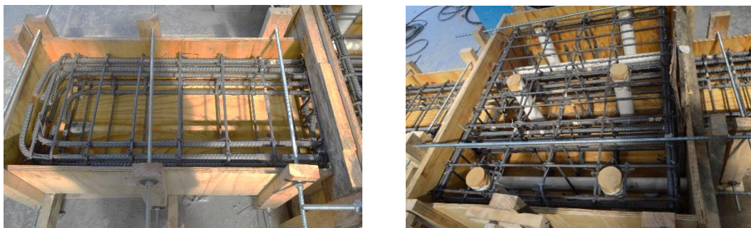
c) Viga lado sur
