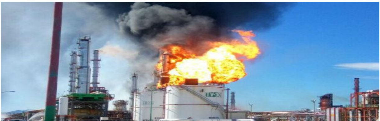
Figura 6 Explosión de tanque de almacenamiento.
