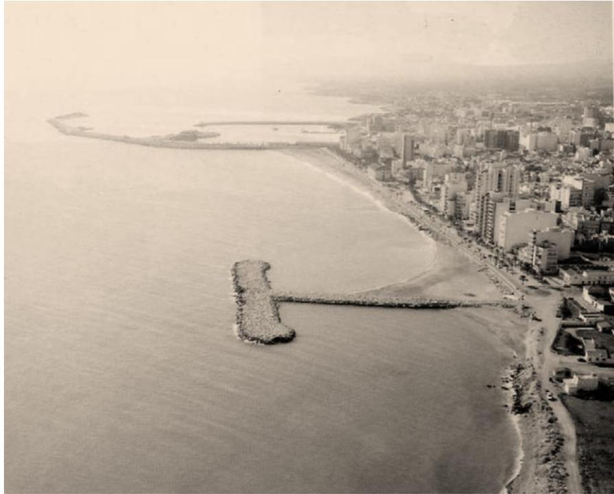
*Figura 2. 1 Dique para control de sedimentos (fuente: [http://geoaphyprojectrules.blogspot.mx/2012/07/breakwaters\\_08.html](http://geoaphyprojectrules.blogspot.mx/2012/07/breakwaters_08.html))*
