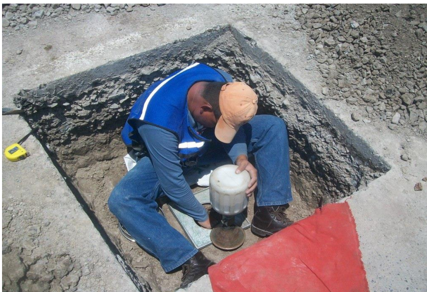
Figura 36 – Extracción de muestra en capa de subbase hidráulica para análisis en laboratorio, agosto de 2012.
