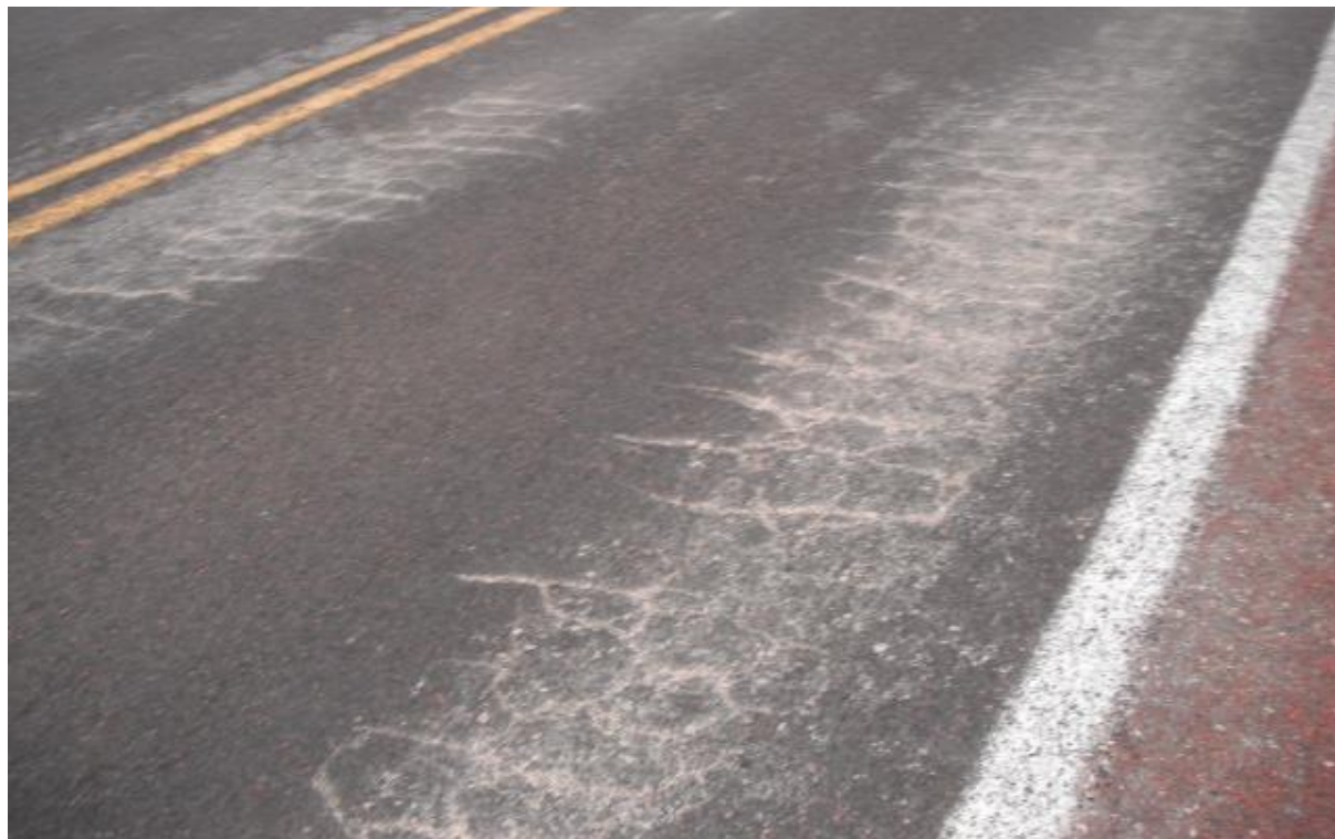
Figura 25 – Carpeta asfáltica en el km 48+000 cuerpo único, abril de 2012.
