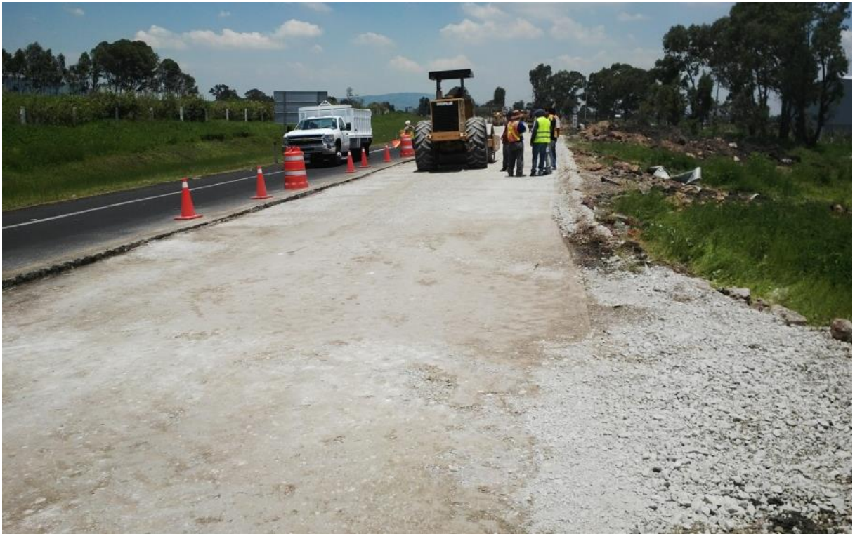
Figura 74 – Colocación de la capa de base granular tratada con 2% de cemento Portland.
