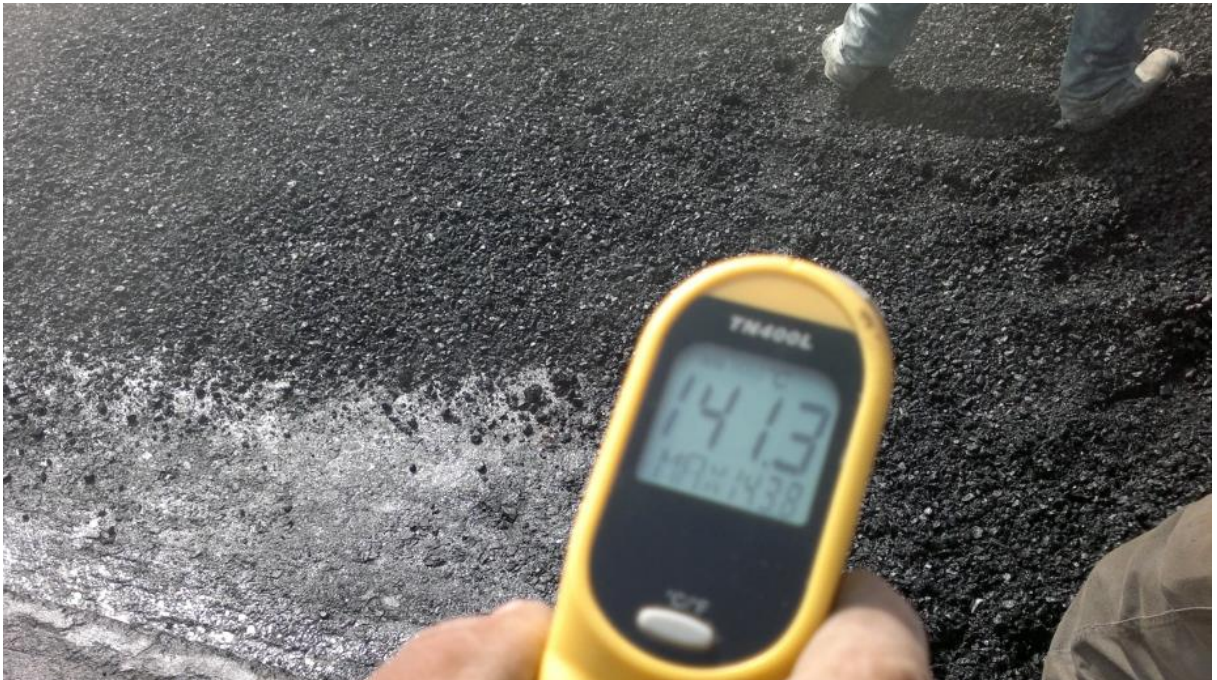
Figura 58 – Control de temperatura de colocación del concreto asfáltico con AC-20 modificado con SBS.
