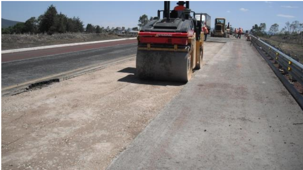
Figura 54 – Tendido y compactación de la capa de base hidráulica repuesta.
