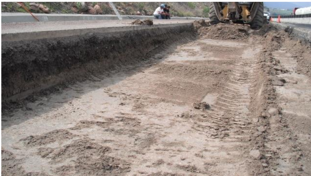
Figura 53 – Retiro de la capa de subbase granular hidráulica y sub-rasante saturados.
