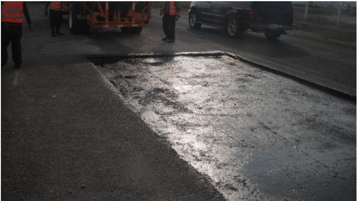
Figura 56 – Riego de liga con emulsión de asfalto sobre la capa de base granular hidráulica.
