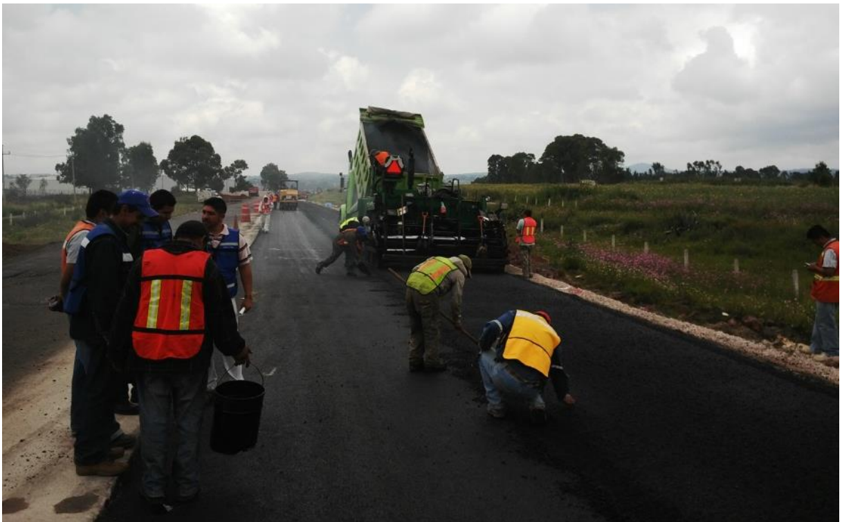
Figura 75 – Tendido y compactación de la capa de rodamiento en concreto asfáltico modificado con SBS.
