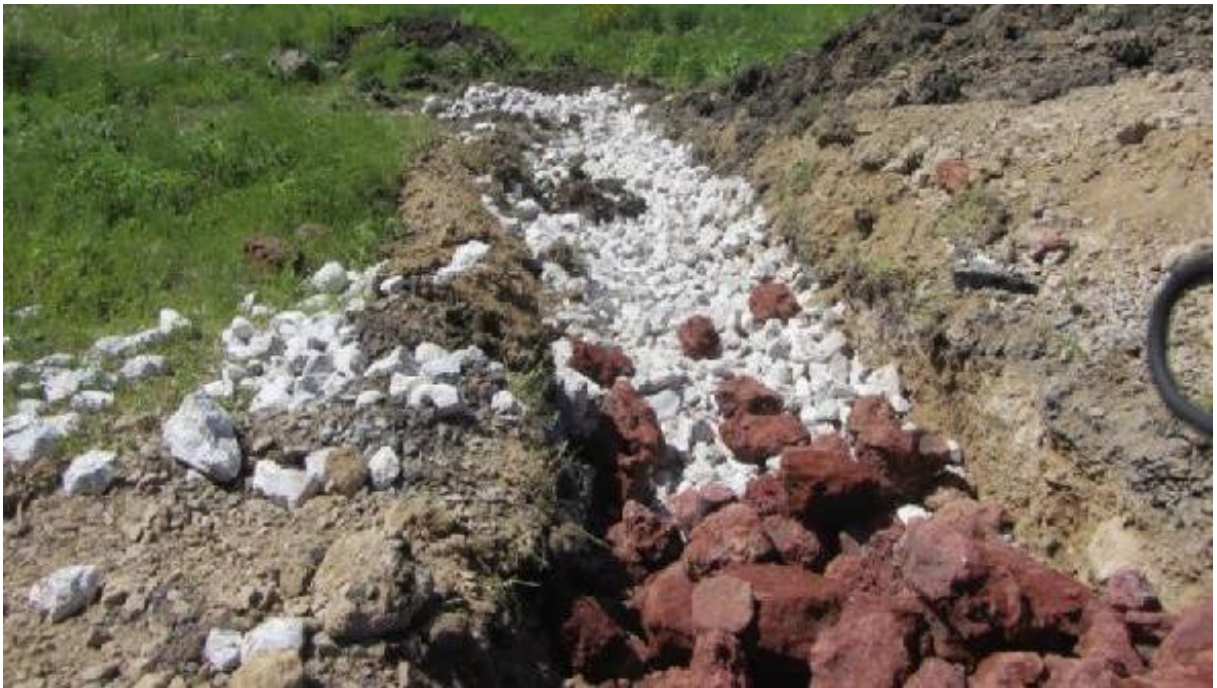
Figura 49 – Dren lateral relleno con material de pedraplén y tezontle grueso, octubre de 2012.
