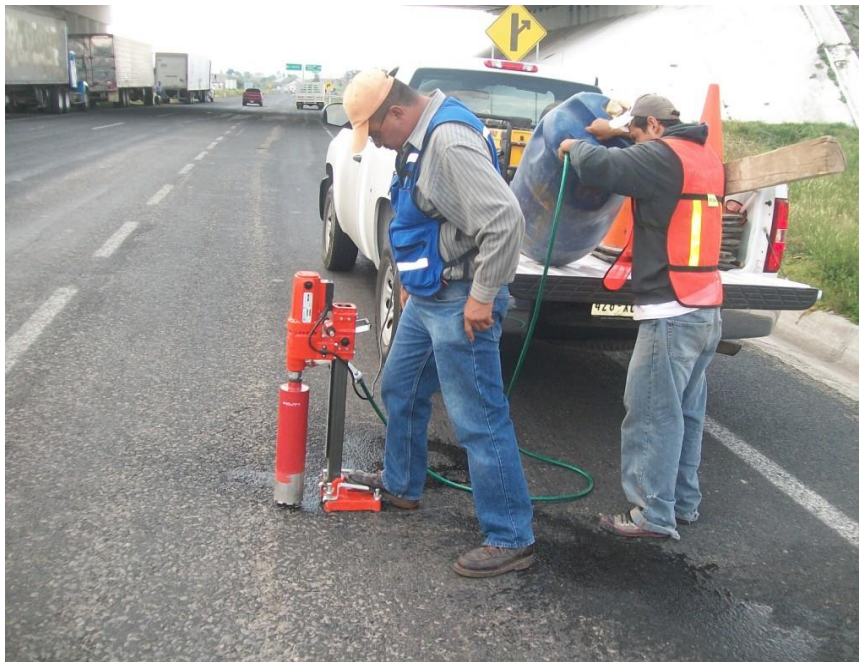
Figura 34 – Extracción de muestra de carpeta asfáltica para análisis en laboratorio, agosto de 2012.
