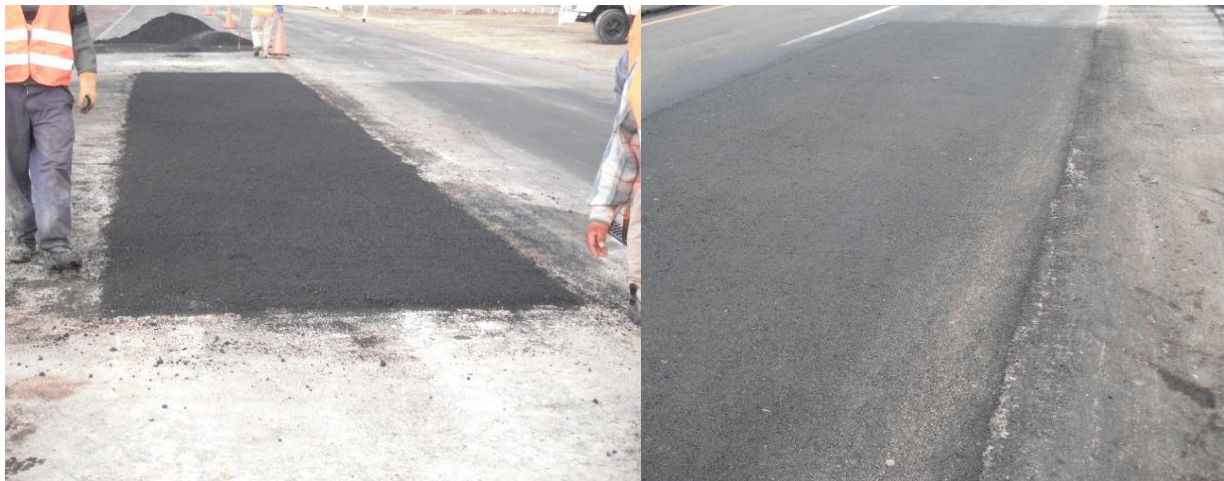
Figura 29 – Ejemplo de bacheo superficial (reposición de carpeta asfáltica), mayo de 2012.
