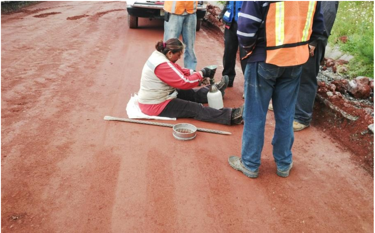
Figura 72 – Control de calidad de los materiales de la capa subrasante.
