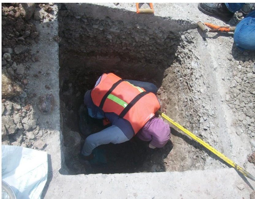
Figura 37 – Extracción de muestras en capas de terracerías para análisis en laboratorio, agosto de 2012.
