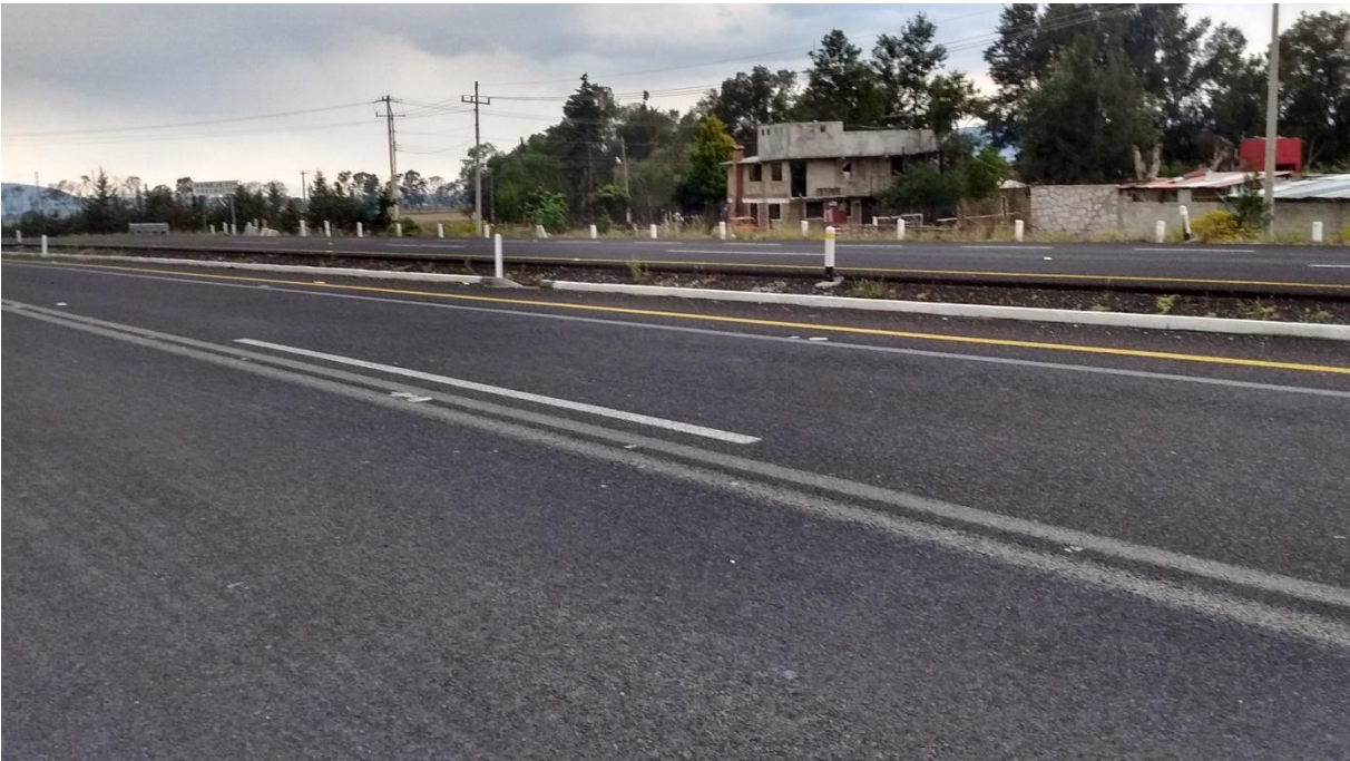
Figura 85 – Tramo reconstruido con la sección propuesta sin problemas superficiales ni estructurales.
