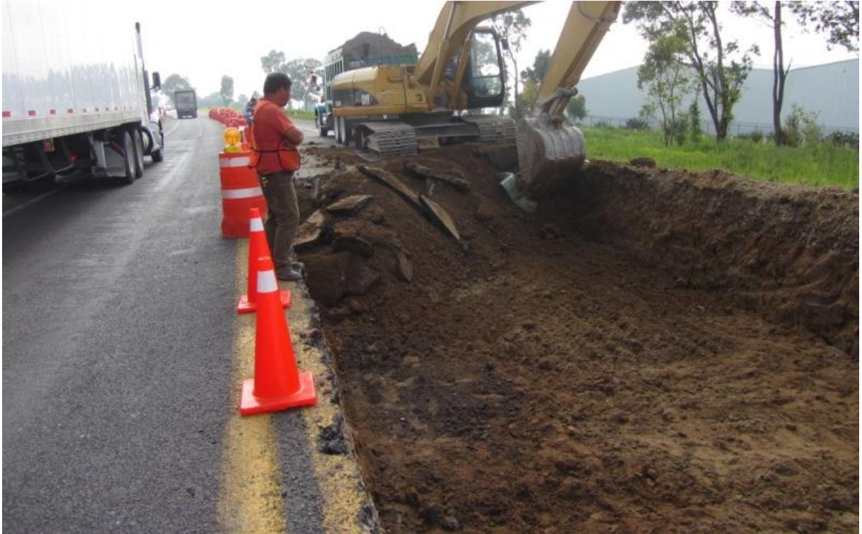
Figura 67 – Remoción de las capas del pavimento degradado hasta la profundidad del nuevo proyecto.
