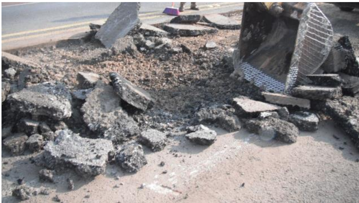
Figura 51 – Retiro de la capa de rodamiento en concreto asfáltico.
