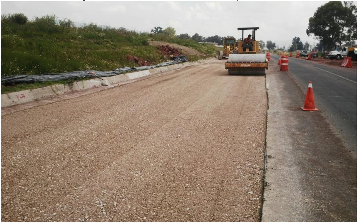
Figura 73 – Colocación de la capa de subbase granular hidráulica.
