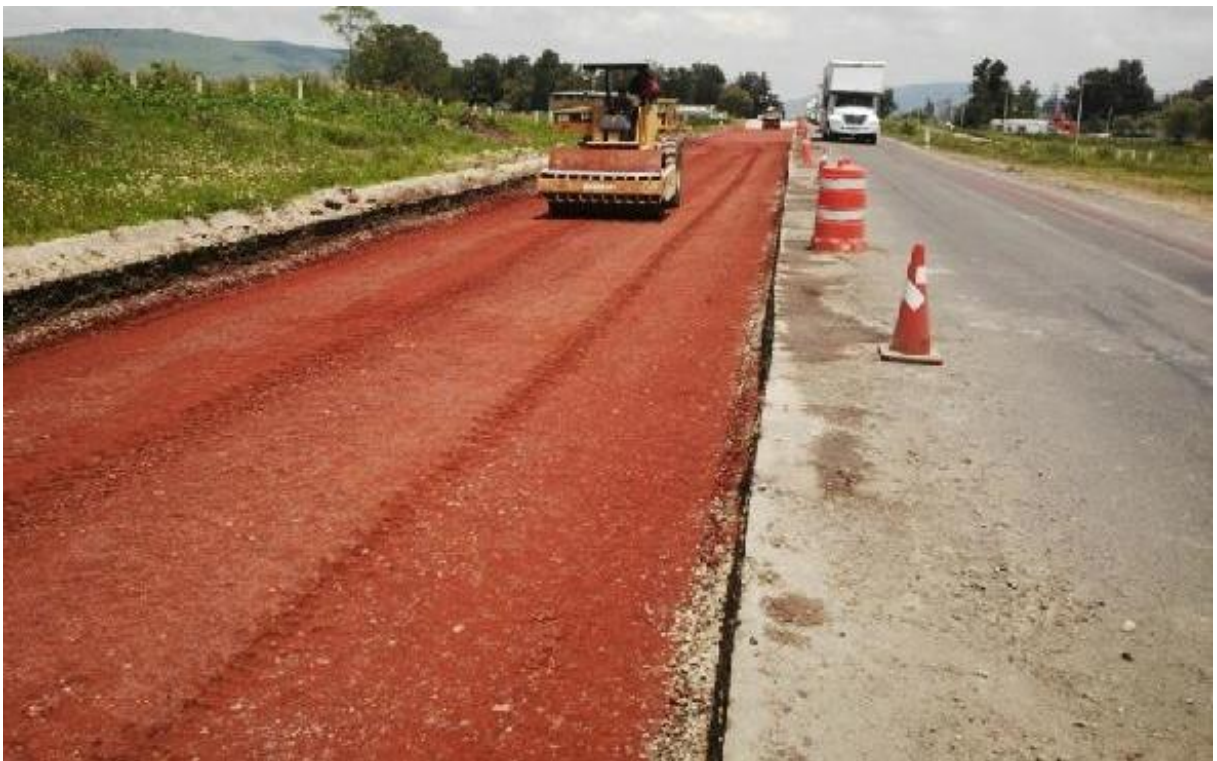
Figura 71 – Colocación de capa de subrasante en materiales filtrantes medios y ligeros.
