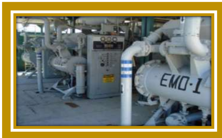
Figura 1.17. Motores de generación de energía tipo diésel. Tomada de notas de clase “Elementos De Perforación”. Mario Rosas.
