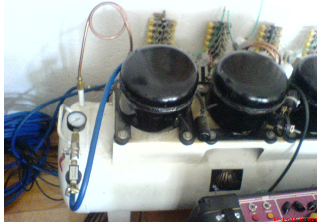
Figura 4.15 Acumulador de aire comprimido.
