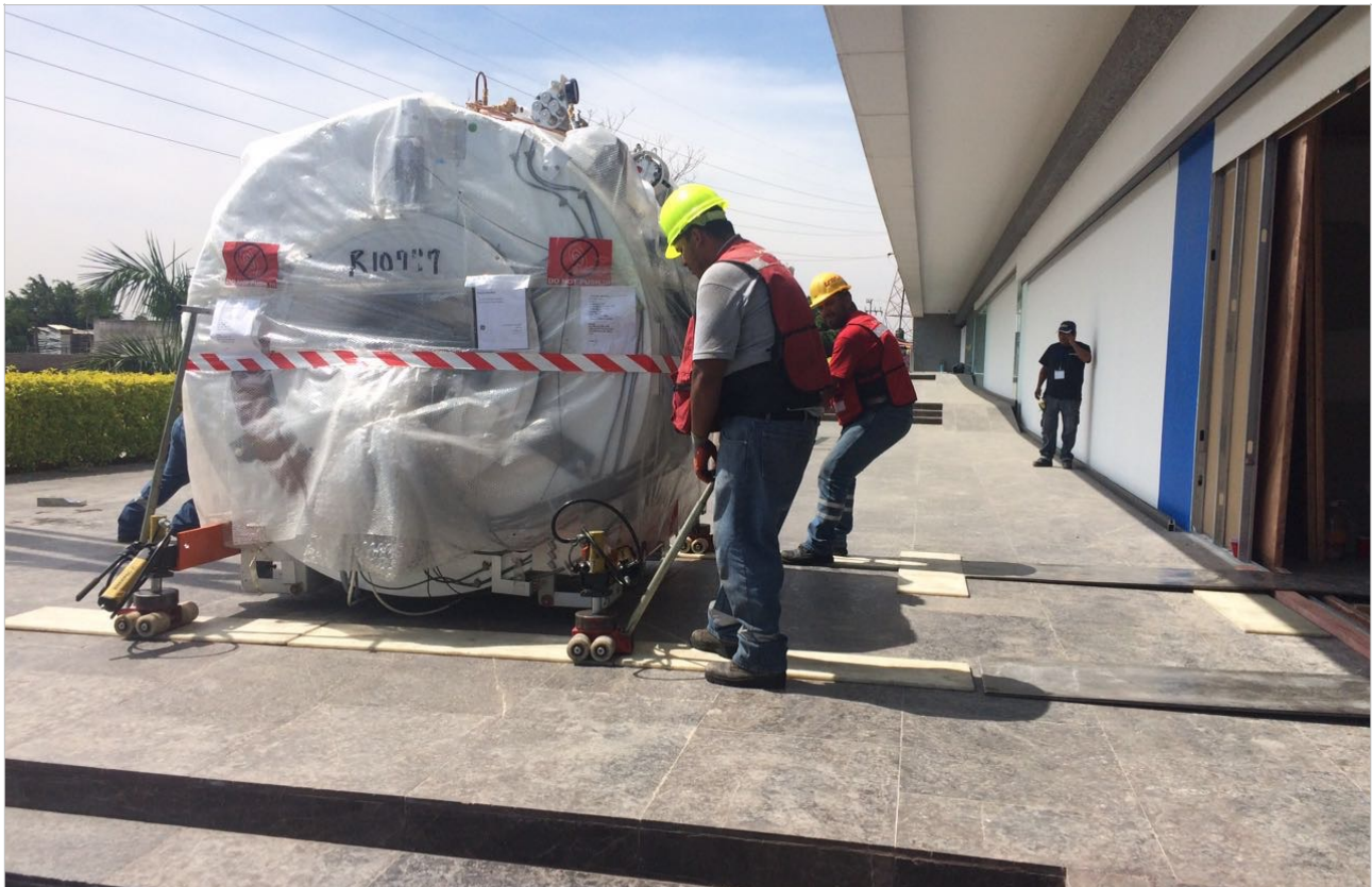
Figura 4.5 Maniobra de ingreso de iman a sala de Resonancia Magnética en CADEM Pirámide Cuernavaca, Morelos.
