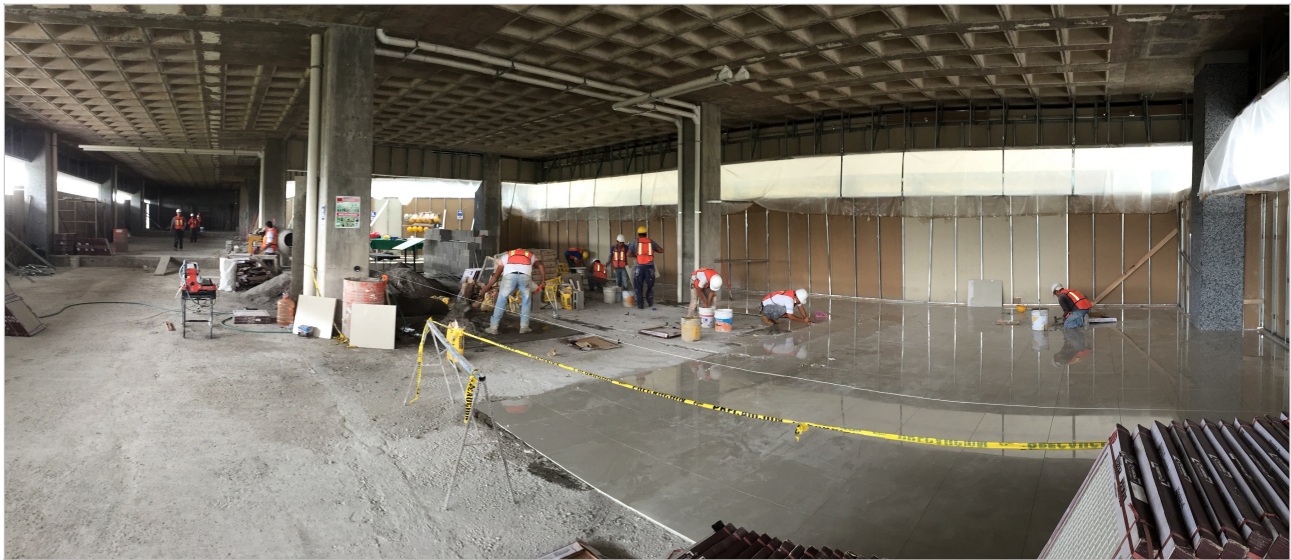
Figura 2.2 Interior del local. Colocación de piso porcelanato
