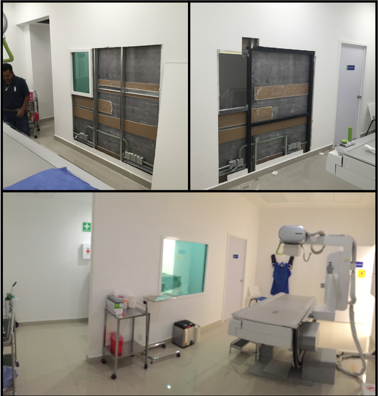
Figura 5.1 Arriba izquierda: Mirilla original y muro cortado para cambio. Arriba derecha: Cristales retirados y refuerzo de PTR para nueva mirilla. Abajo: Área terminada con mirilla de nuevo tamaño.
