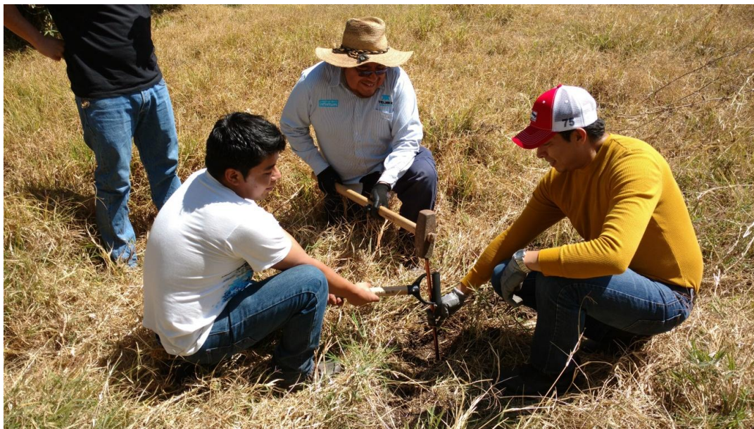
Figura 4.10 Golpeando las varillas con el mazo hasta que queden completamente enterradas en el terreno.
