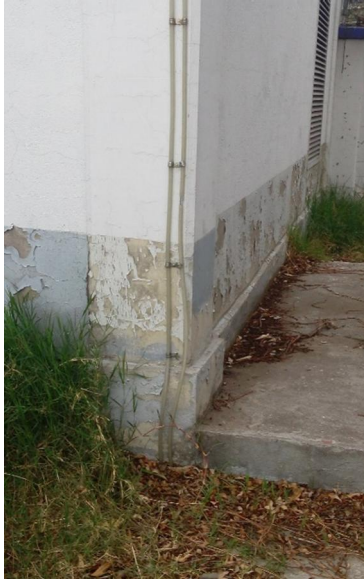
Figura 4.4b Conductor de puesta a tierra en el patio exterior.
