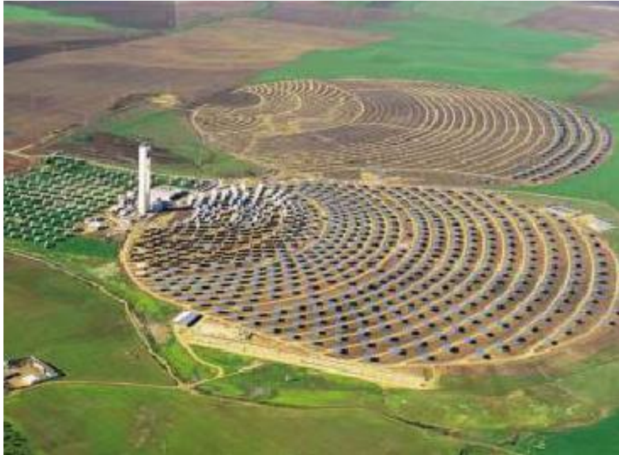
Figura 1.3. Parque solar PS100 y PS200, Sevilla, España.
