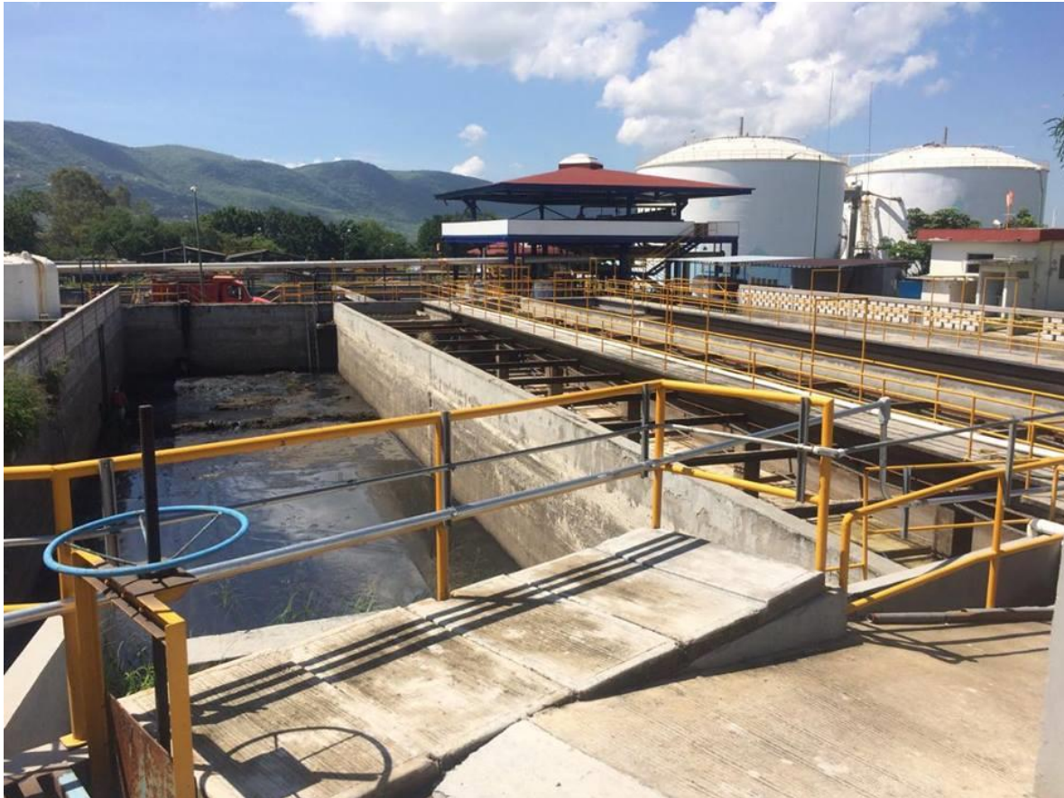
Figura 18 Instalaciones de ECCACIV
