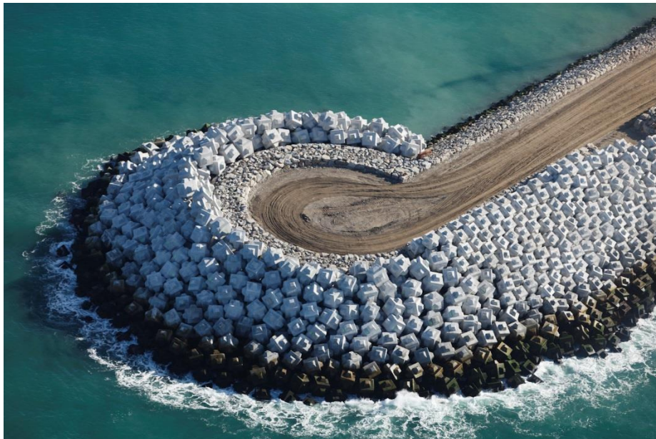
Figura 3.1.1 DRPS cubierto en el manto exterior por cubípodos
