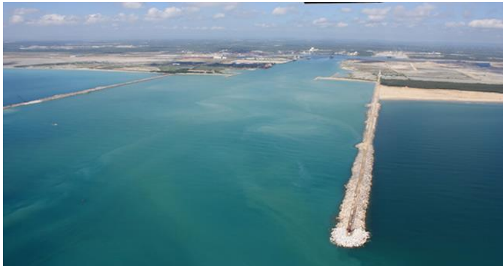
Figura 1.1.1 Canal de acceso al puerto de Altamira, Tampico, México.
