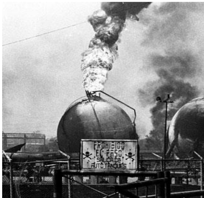
FIGURA 23. EXPLOSIÓN DE LAS PLANTA DE ALMACENAMIENTO Y DISTRIBUCIÓN DE SAN JUAN IXHUANTEPEC. ARCHIVO EXCÉLSIOR.
