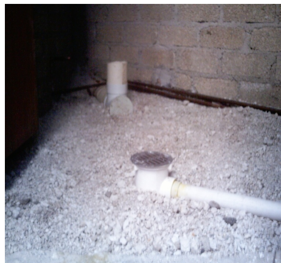
Figura 2.2 Separación de agua negra y gris.
