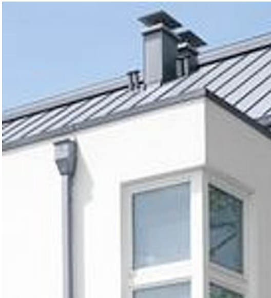
Figura 3.3 Bajantes de agua de lluvia
