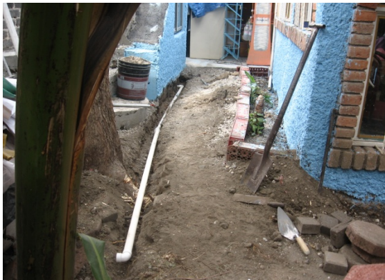
Figura 2.5 Ramales, bajantes y depósito de agua gris.
