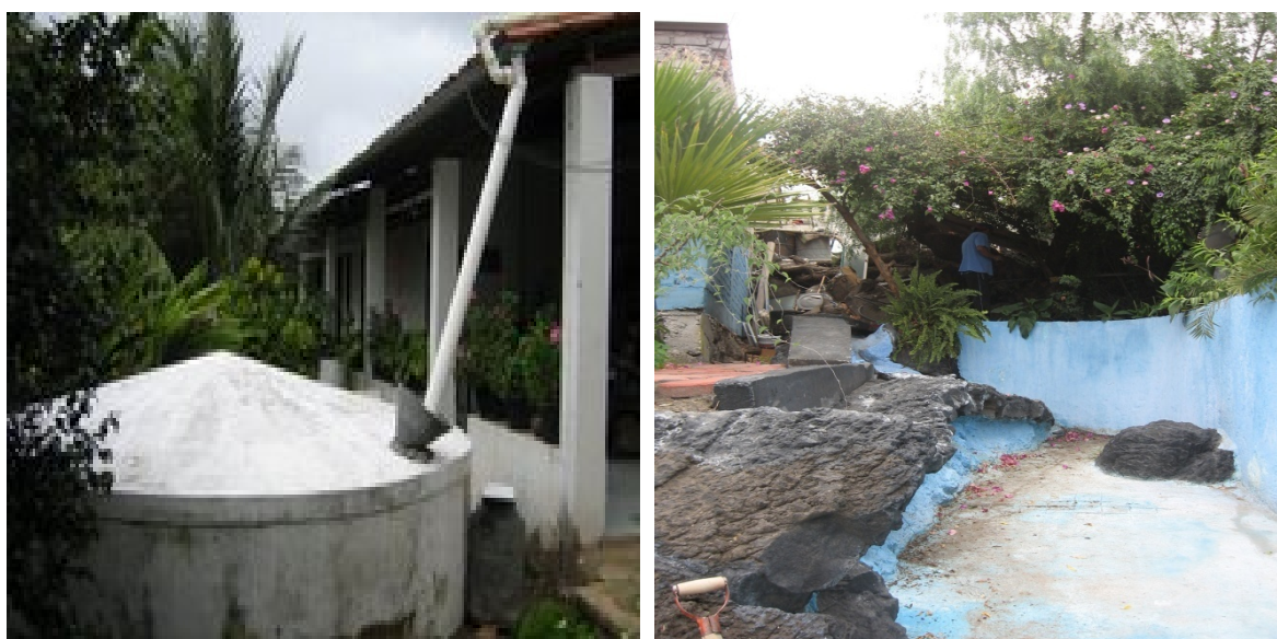
Figura 3.7 Depósito natural y concreto
