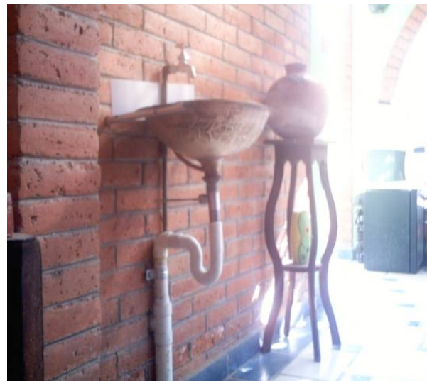
Figura 2.4 Separación de agua negra y gris en planta baja.
