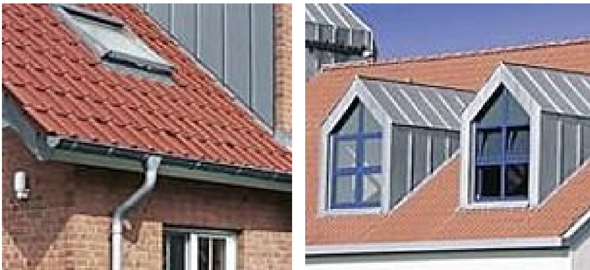
Figura 3.2 Techos y bajantes de agua de lluvia
