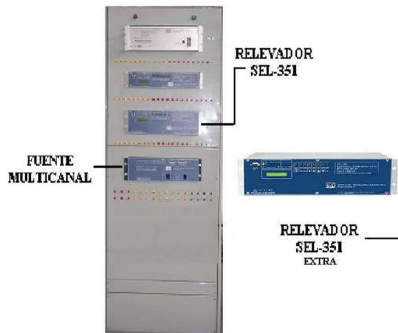
Figura 5.50 Gabinete de Protecciones y Relé Extra
