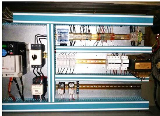
Las fotos anteriores nos muestran al antes y después de los tableros de control del sistema, el sistema completo lo componen 3 tableros idénticos a este y otros 3 pequeños tableros para el control de compresores en azotea.
