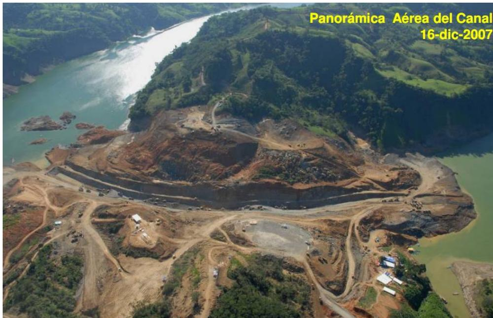
Figura 3.5. Canal excavado a cielo abierto
