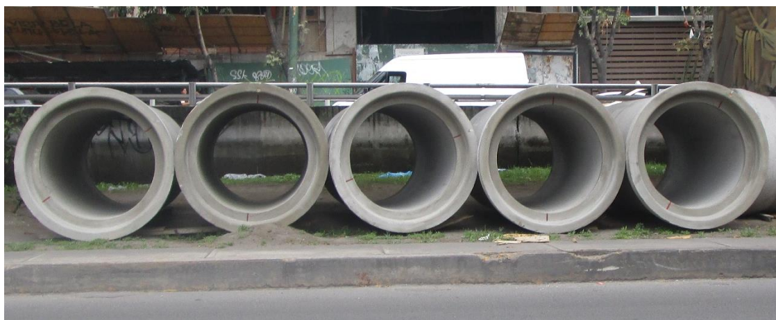
Figura 63 Tubos de concreto reforzado estibados en obra
