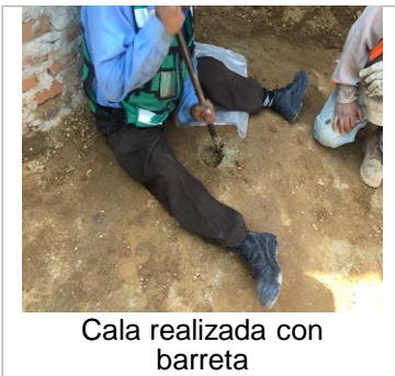
Diagrama 1 Proceso de elaboración de prueba de compactación en campo
