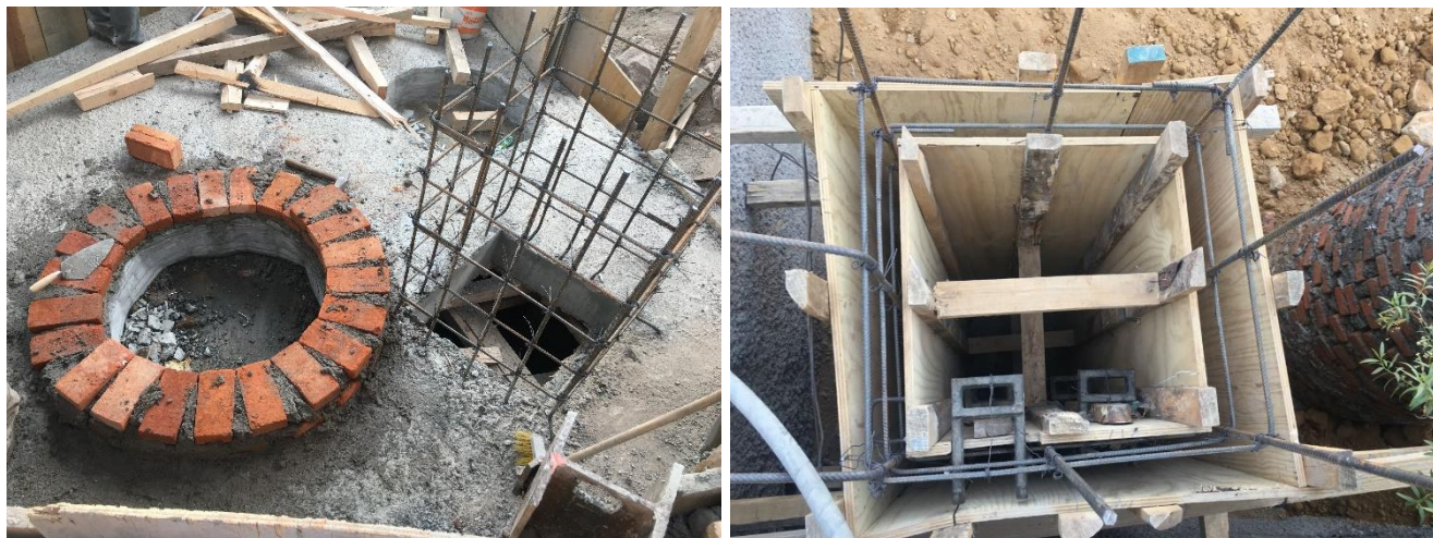
Figura 61 Armado y cimbrado de un paso hombre sobre losa tapa de una caja de deflexión
