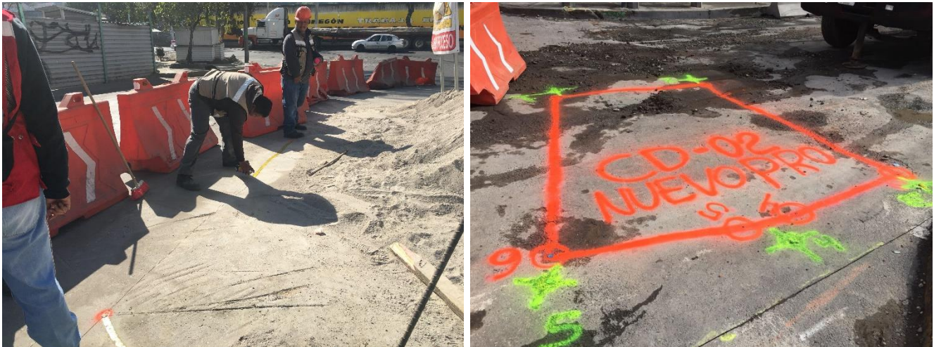
Figura 32 Trazos realizados por brigada de topografía
