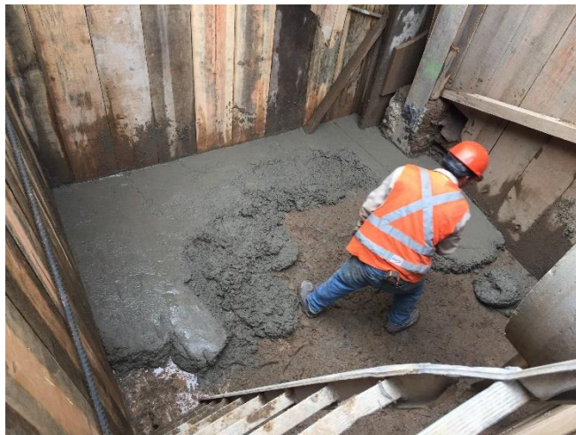
Figura 50 Colado de plantilla de concreto pobre fabricado en obra
