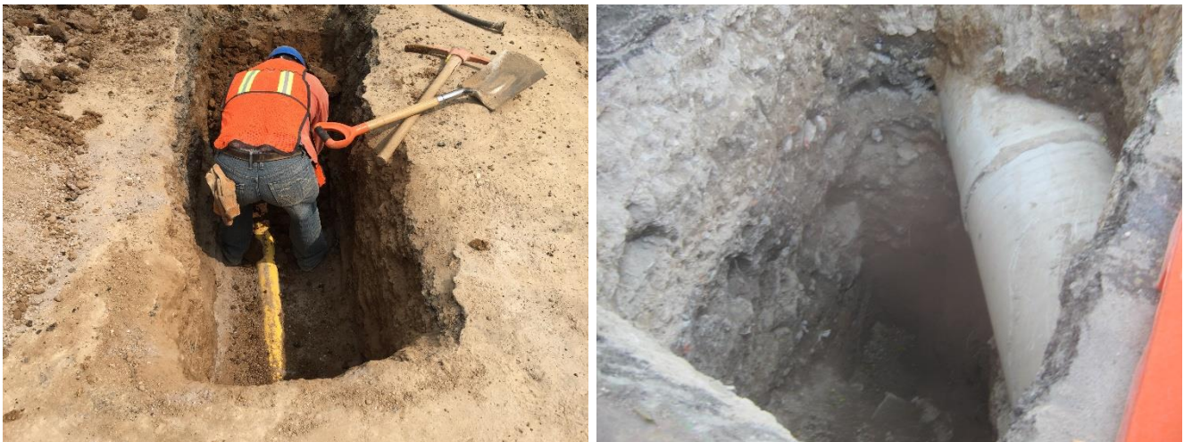
Figura 17 Calas realizadas para ubicar tubería de gas natural y colector existente
