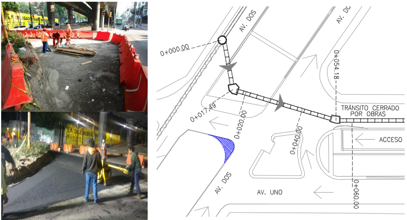
Figura 23 Ampliación de radio de giro sobre Avenida dos
