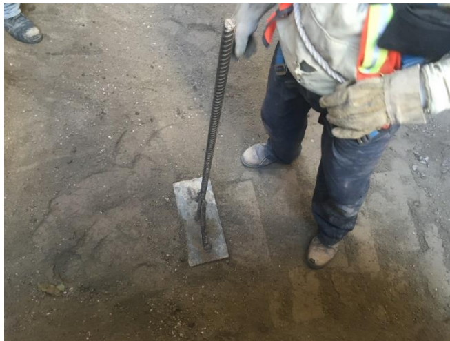
Figura 49 Colocación y compactación de cama de arena con pisón elaborado en obra
