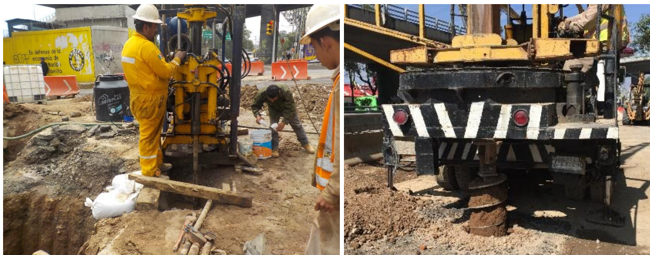
Figura 37 Perforación en el suelo para construir muro Berlín como sistema de contención
