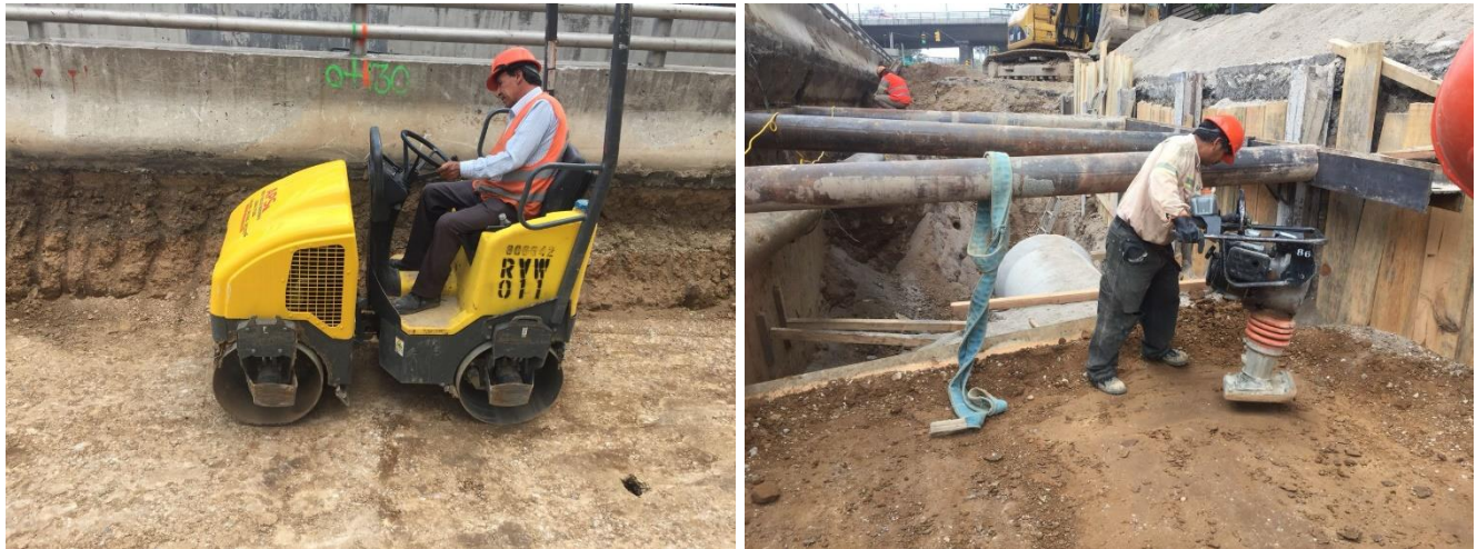
Figura 73 Compactación del material de relleno con rodillo vibratorio en tándem y apisonador manual (bailarina)
