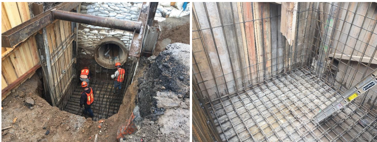
Figura 51 Armado de losa de fondo y muros perimetrales con varillas del número 4 (1/2") para pozo caja
