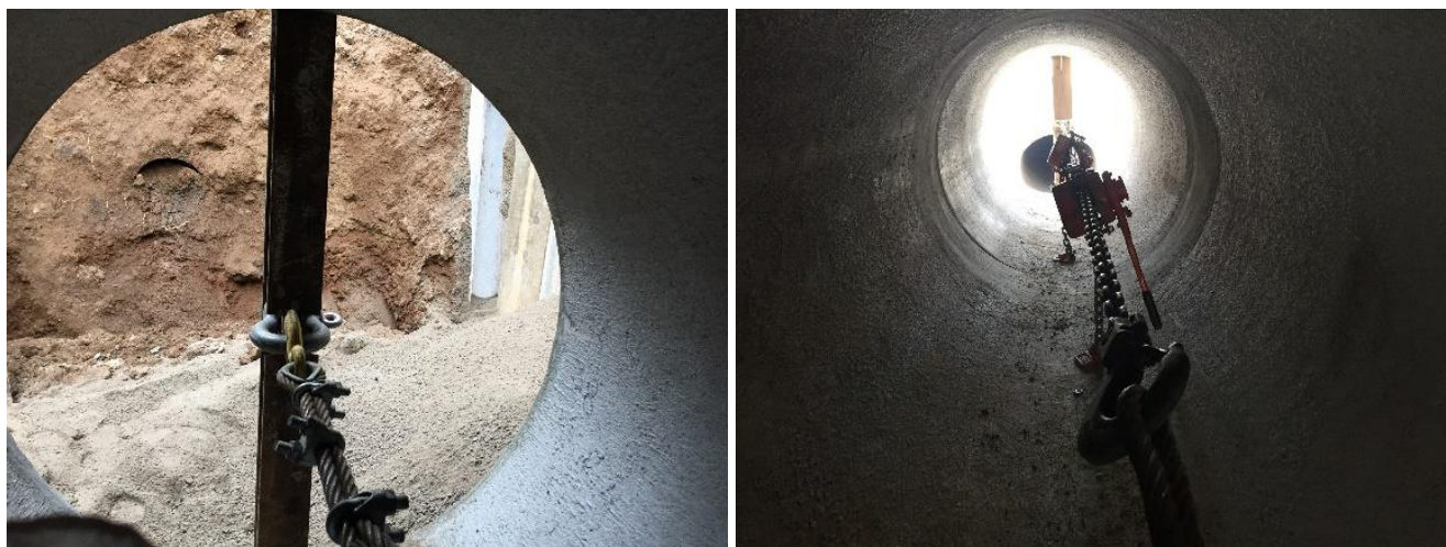
Figura 67 Dispositivo de tracción para instalación de tubería
