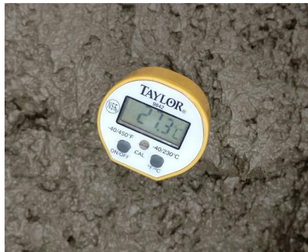
Figura 13 Termómetro colocado en concreto en estado fresco
