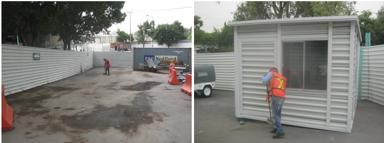
Figura 21 Almacén y oficinas en obra
