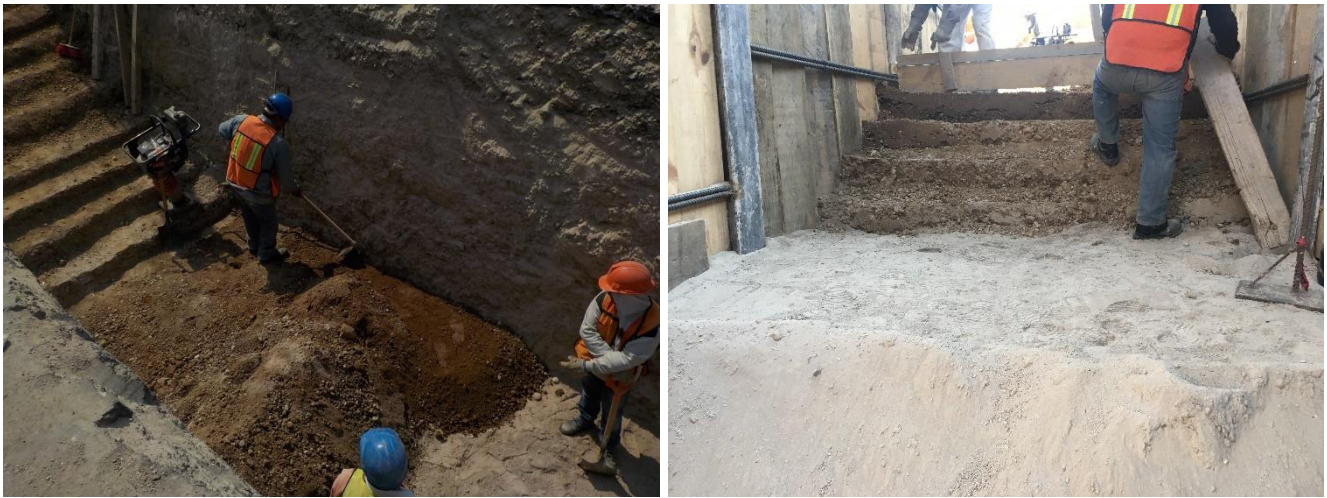
Figura 72 Capas de relleno de zanja de tubería
