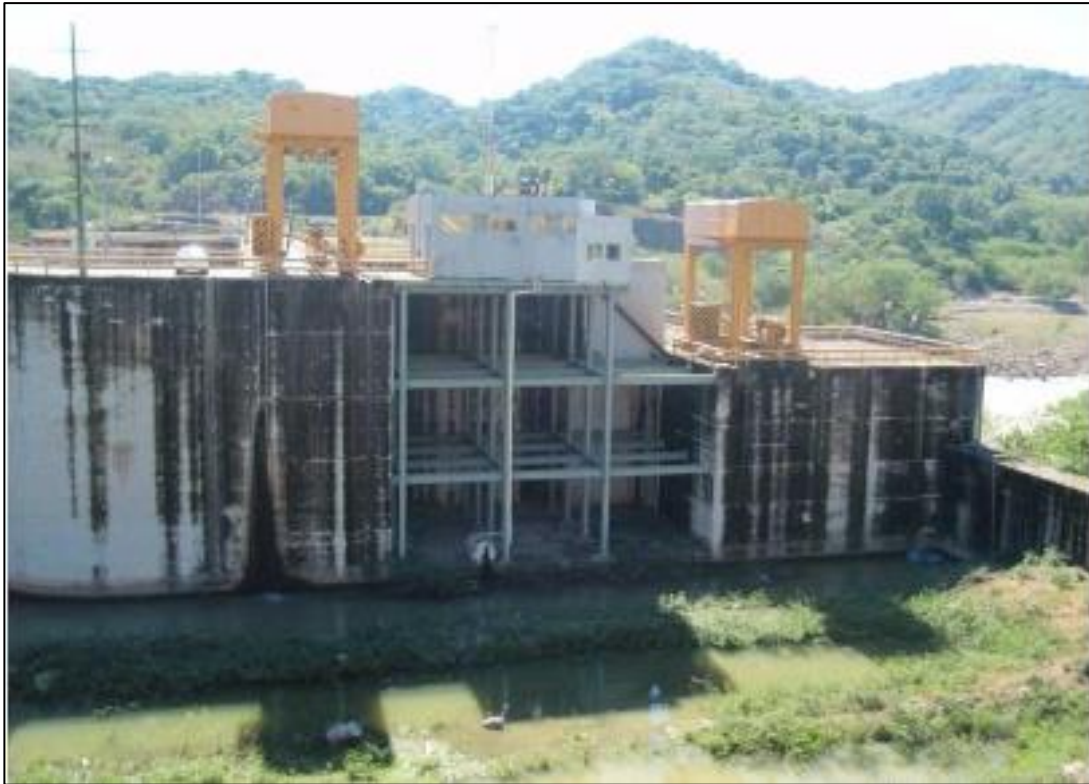
Figura 2.6 Detalle de la plataforma de la P.R. San Rafael
