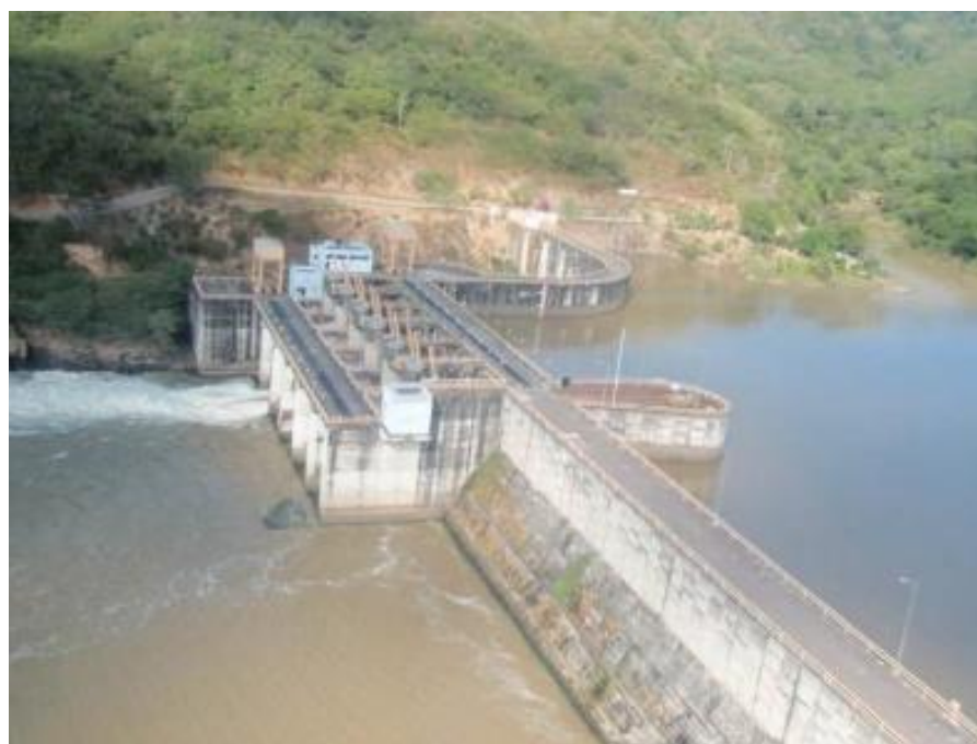
Figura 2.3 Cortina y Obra de excedencias de la P.R. San Rafael
