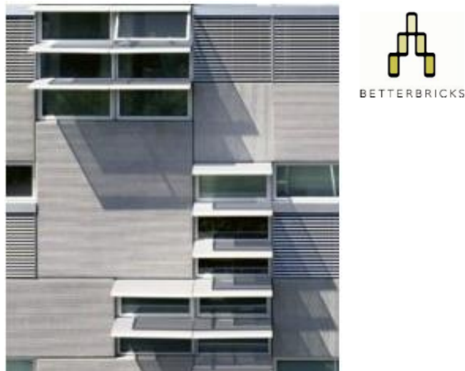
Fig. 27 Ventanas edificio Alley 24, BetterBricks.
