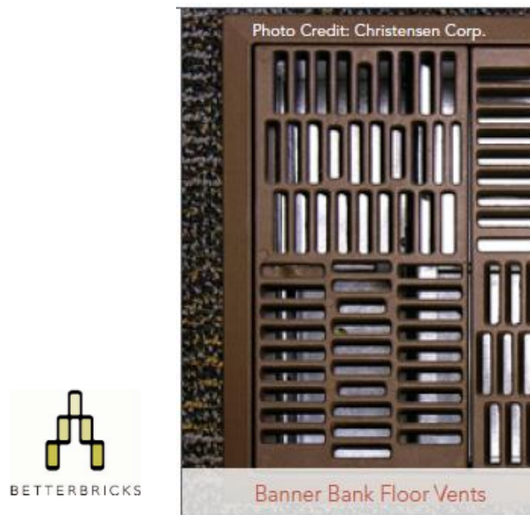
Fig. 24 Ventilación en pisos, edificio Banco Banner, BetterBricks.
