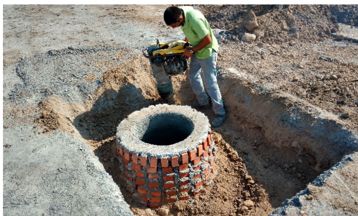
Figura 3.16 (a) Inicio de la excavación para elevar el pozo de visita (b) Se retiran los barrotes y se limpia para que se proceda a la elevación (c) Se inicia la elevación para tenerlo a nivel de rasantes (d) Compactación.
