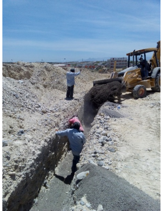
Figura 3.8 Tendido de CNC para plantilla
