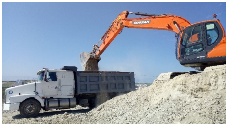
Figura 3.4 Carga de material usando excavadora Doosan 340
