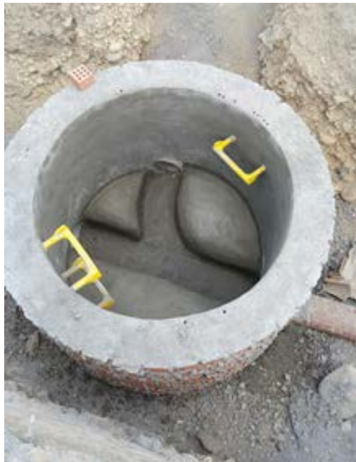
Figura 3.18 Colocación de escalones para pozos de visita.
