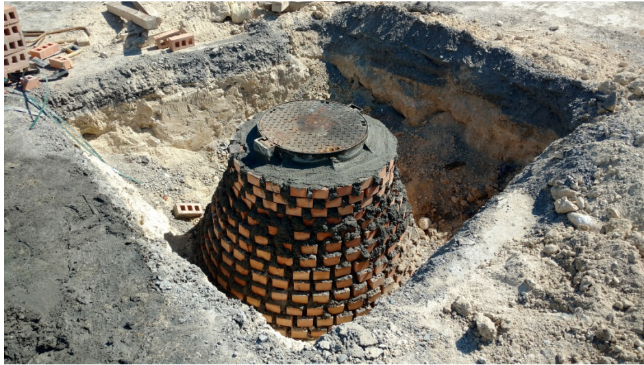
Figura 3.17 Colocación de brocal.
