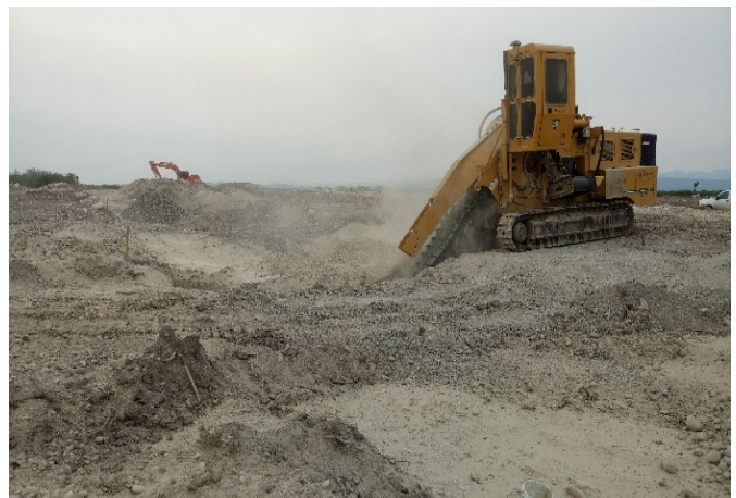
Figura 3.9 Corte de zanja (a) Utilizando excavadora Doosan (b) Utilizando zanjadora
