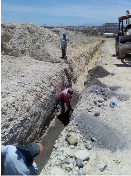
Figura 3.8 Tendido de CNC para plantilla
