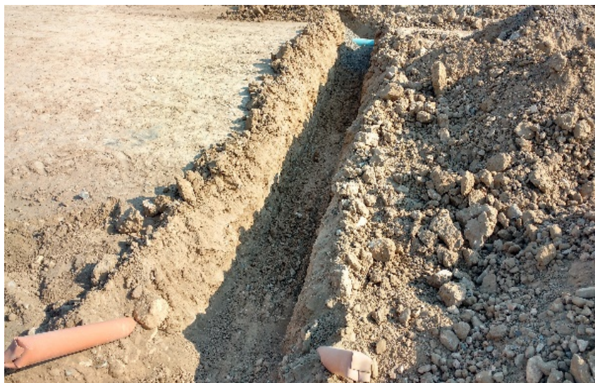
Figura 3.22 Corte de zanja entre las descargas domiciliarias para la colocación de tomas de agua .
