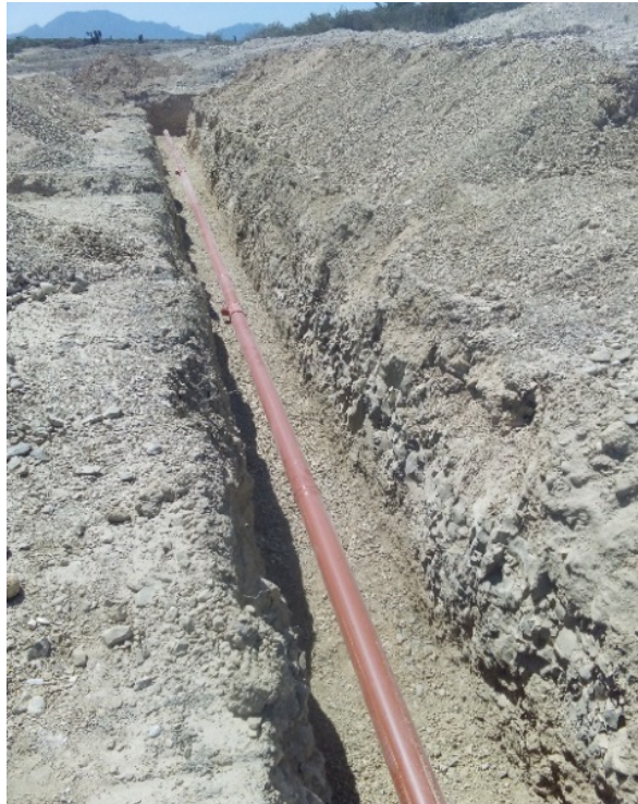
Figura 3.10 Tendido de tubería de 8"
