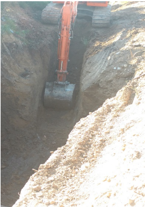
Figura 3.9 Corte de zanja (a) Utilizando excavadora Doosan (b) Utilizando zanjadora
