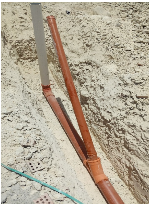
Figura 3.15 Muestra descarga sencilla de 6" (izquierda) y Descarga doble de 4" (derecha)
