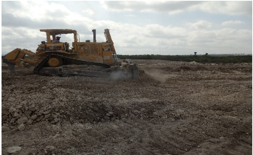
Figura 3.2 Corte del terreno (c) Corte con Buldócer
