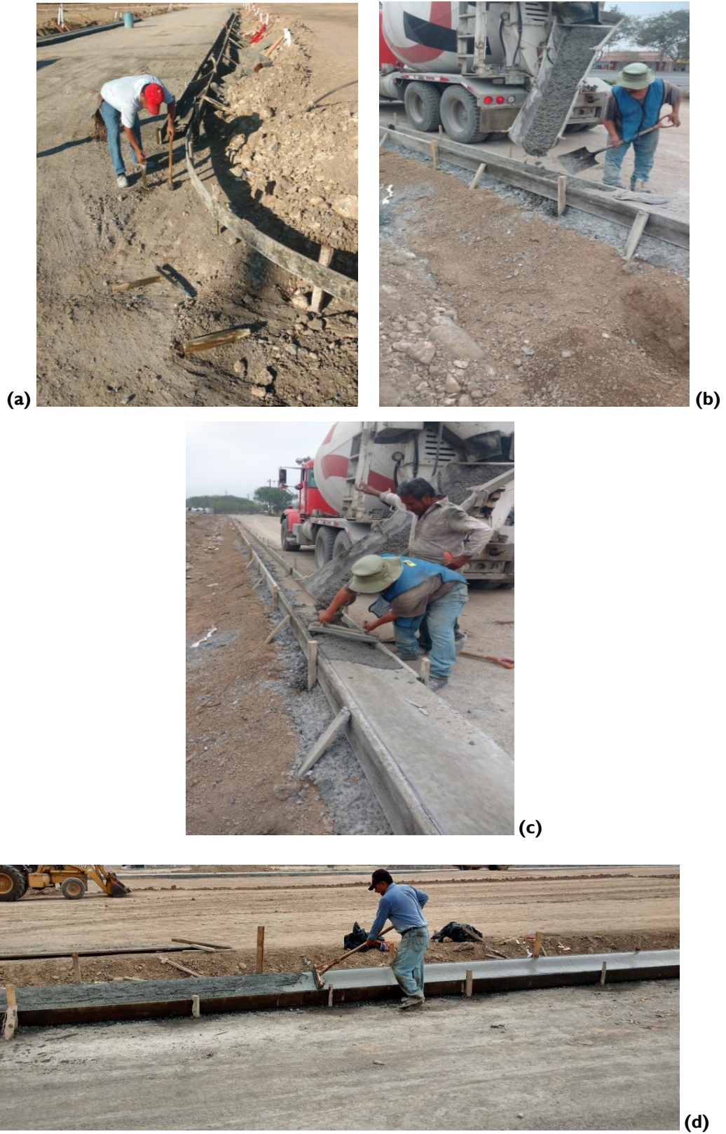
Figura 3.28 Colocación de cordones: (a) Colocación de cimbra (b) Vertido de concreto (c) Retiro de excedentes y (d) Afine con tarja
