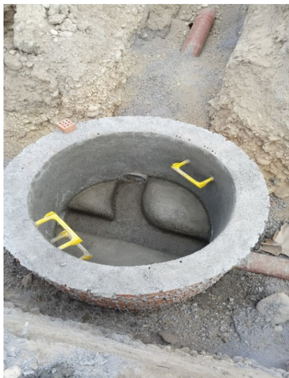
Figura 3.11 Nivel al que llegan los pozos de visita para su posterior elevación
