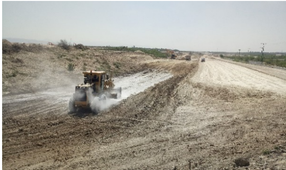
Figura 3.6 Homogenización de la cal con la tierra.
