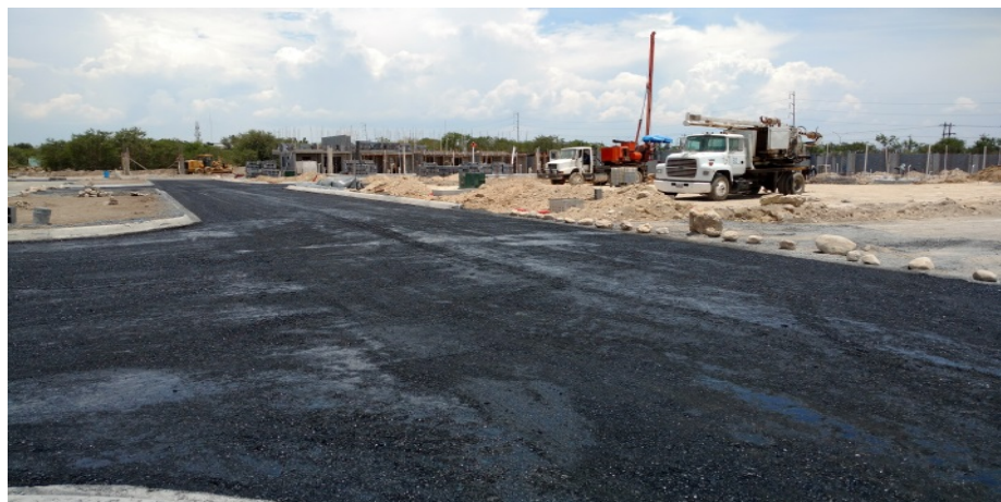
Figura 3.30 Impregnación de capa base para después verter la carpeta asfáltica.
