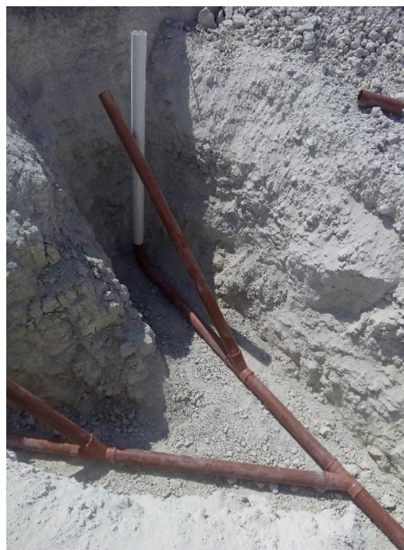
Figura 3.15 Muestra descarga sencilla de 6" (izquierda) y Descarga doble de 4" (derecha)
