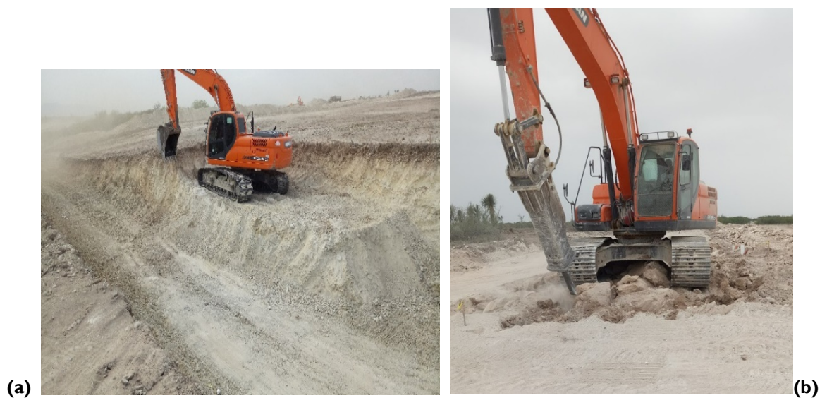
Figura 3.2 Corte del terreno (a) Corte con excavadora y (b) Corte con excavadora equipada con martillo neumático.
