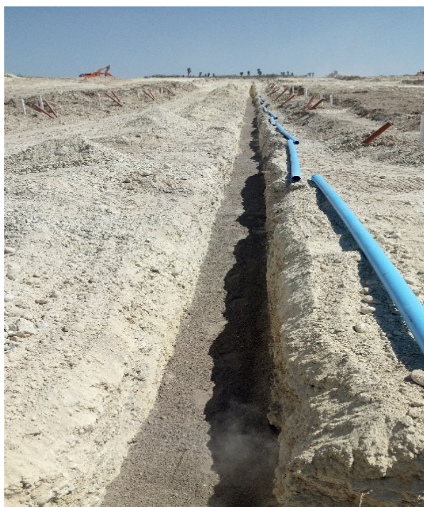
Figura 3.21 Tendido de tubería y plantilla colocada.
