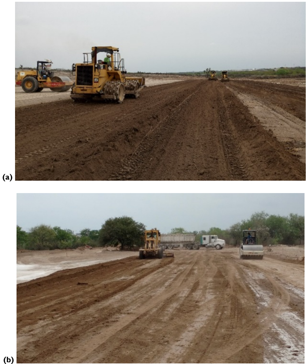
Figura 3.7 Compactación de suelo (a) con rodillo pata de cabra, (b) con rodillo liso
