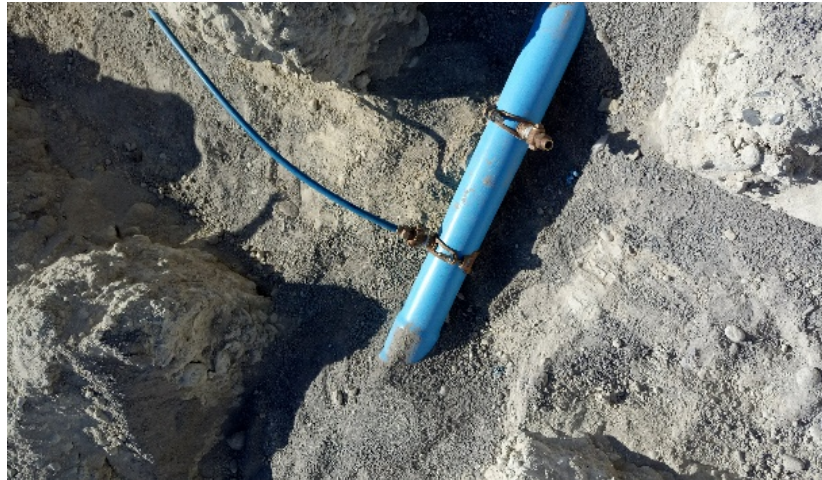
3.25 Abrazadera con su llave de inserción y manguera.
