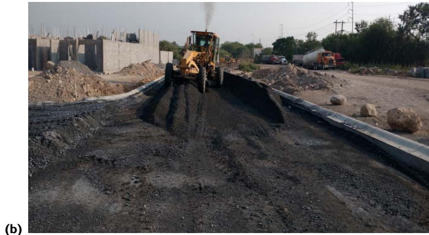
Figura 3.29 Conformación de la capa base (a) Tendido de material (b) Homogenización de material.
