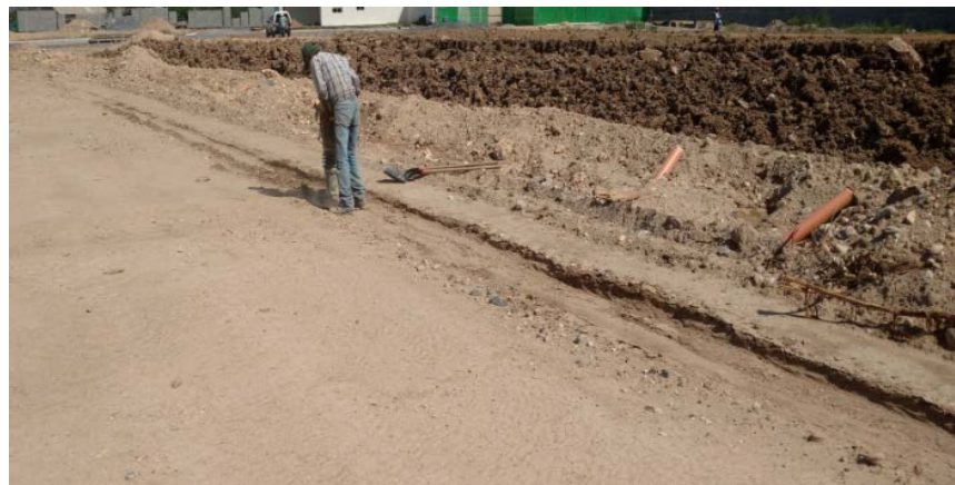
Figura 3.26 Compactación de zanja con pisón neumático.
