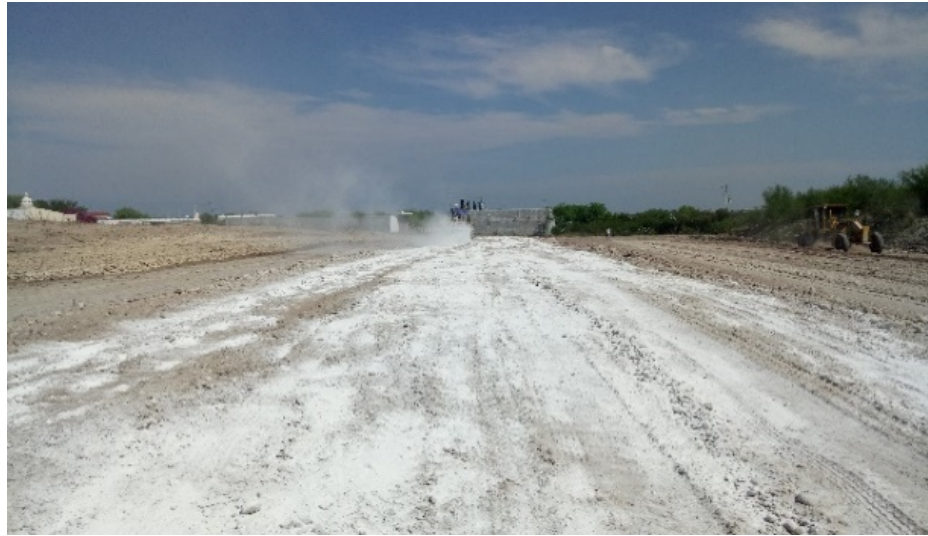
Figura 3.5 Tendido de cal para mejoramiento de suelo.
