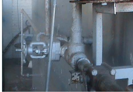
*Vista de la tubería y válvula de regulación por donde circula la salmuera geotérmica 2008*
