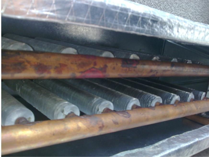
*Vista de la tubería aletada.*
