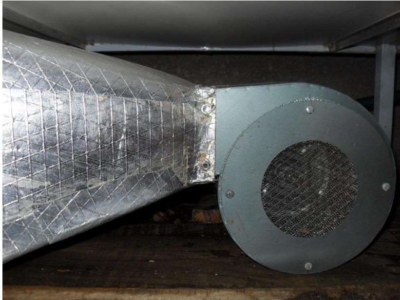
*Vista del filtro del ventilador y el difusor al túnel.*
