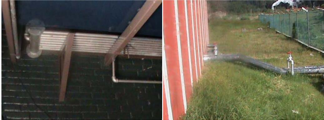
*Intercambiadores de calor en la estufa de secado de madera y tubería de calefacción geotérmica en los Azufres Michoacán [El autor]*
