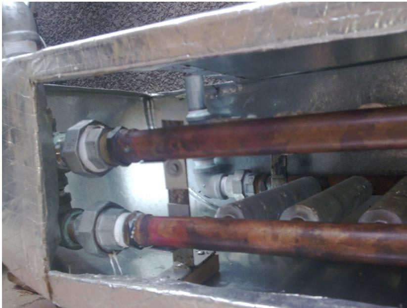
*Vista de los tubos principales del intercambiador de calor.*
