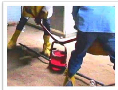
C) Posición del crisol en el porta-crisol
