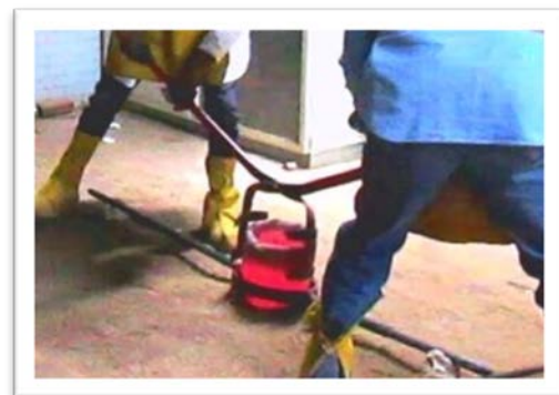
C) Posición del crisol en el porta-crisol
