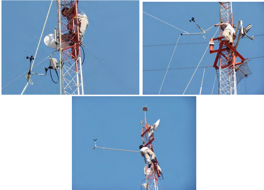
Fig. 3. 17 Maniobra de instalación
