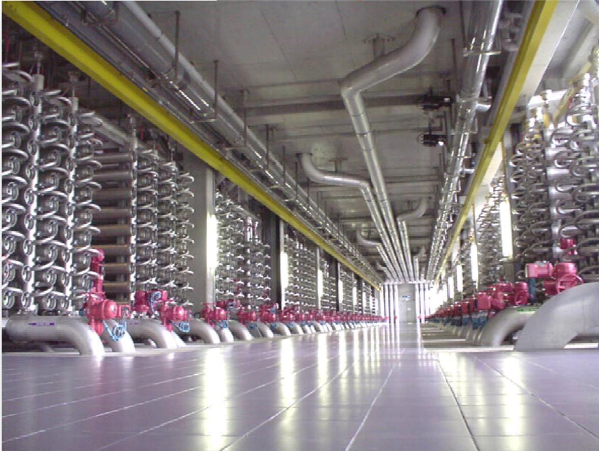
Figura 4.7. Pasillo de la planta en donde se pueden ver claramente los tubos de presión que contienen a las membranas de nanofiltración. Tomada de <http://www.veoliawater.com>
