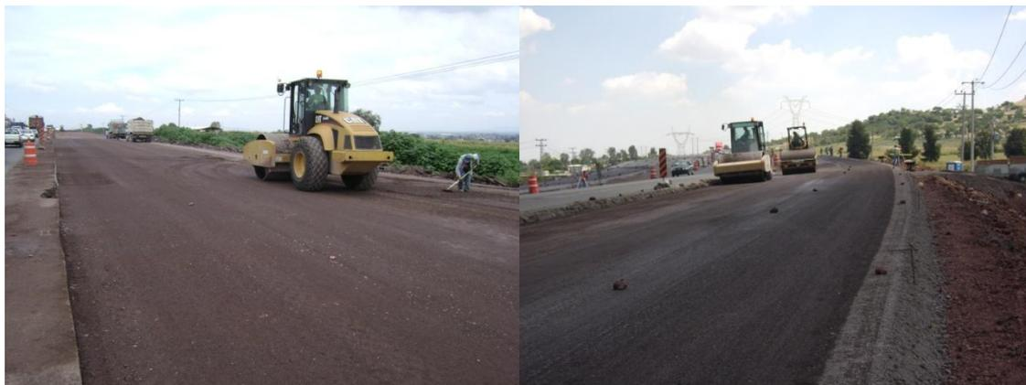
**Fig. 78 Trabajos de compactación de asfalto y terracerías.**
