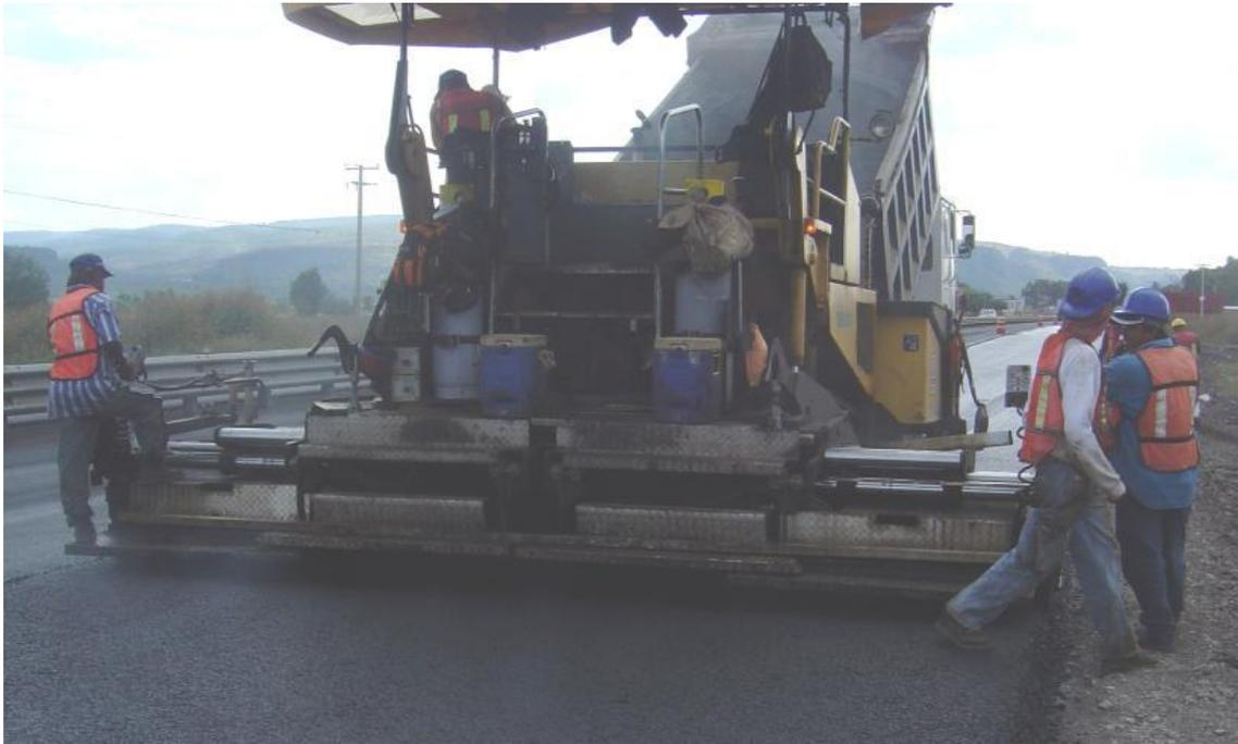
**Fig. 16 Pavimentadora de asfalto.**
