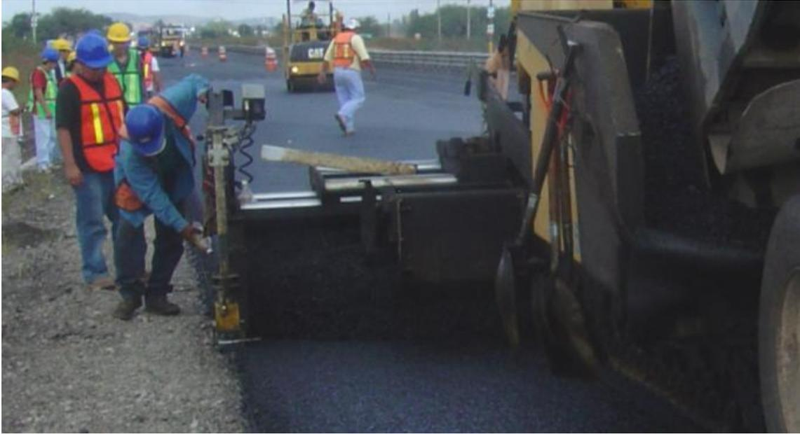
**Fig. 19 Nivelación del tendido de asfalto.**
