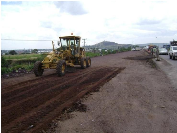
**Fig. 75 Motoconformadora en construcción de caminos.**
