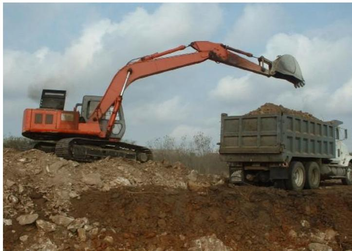
**Fig. 54 Utilización de camión para acarreo de material.**
