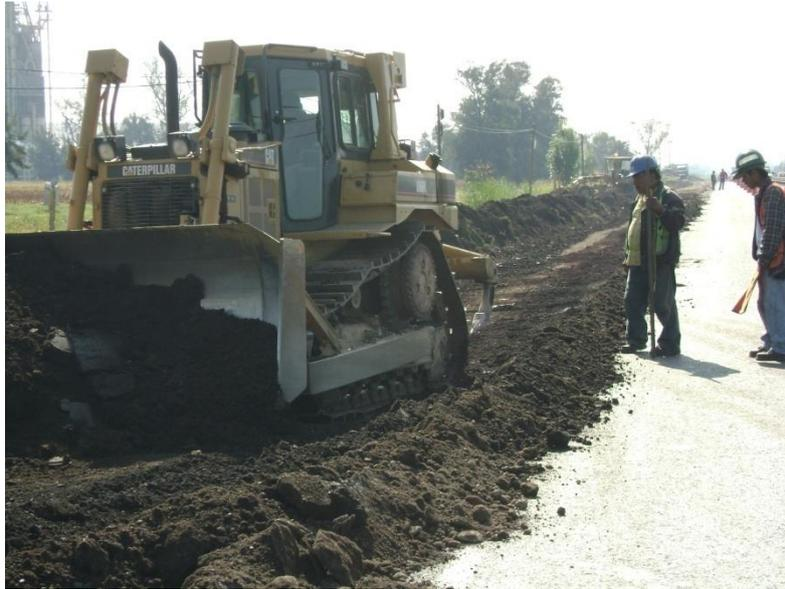
**Fig. 71 Tractor D6R III en empuje de tierras.**
