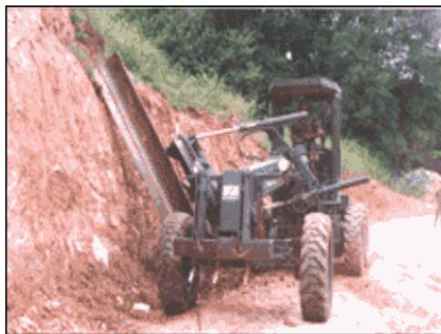
**Fig. 25 Afine de taludes.**
