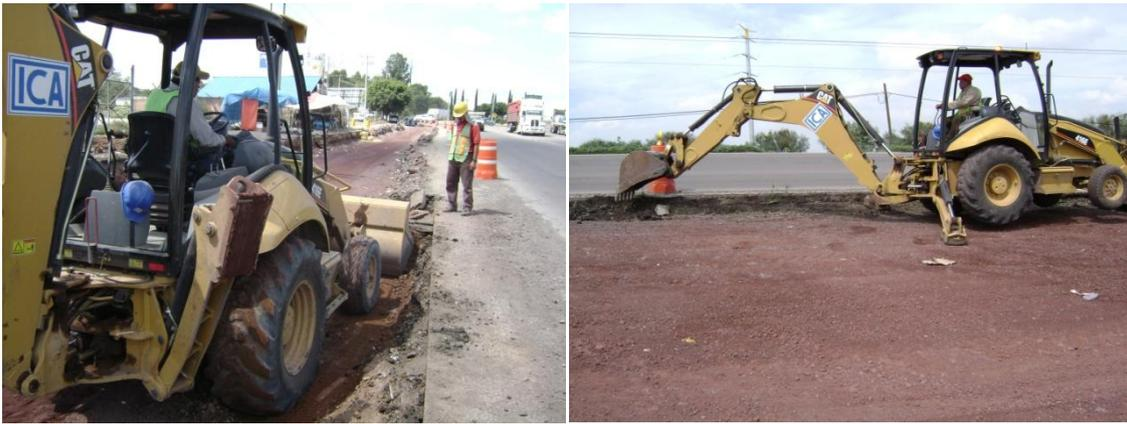
**Fig. 85 Retroexcavador en trabajos de excavación y corte de material.**
