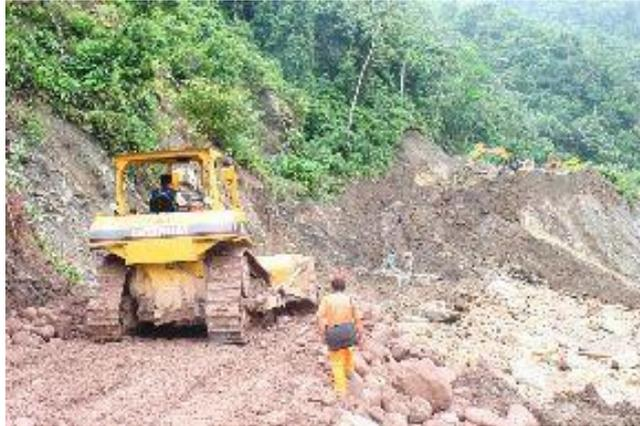
**Fig. 23 Tractor de orugas en construcción de caminos.**
