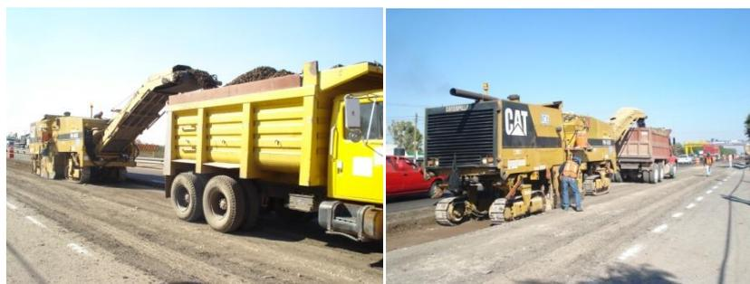
**Fig. 69 Fresadora Caterpillar en acción.**
