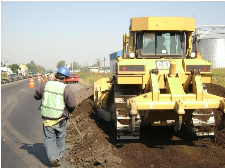
**Fig. 72 Tractor D6R III en desempalme de suelos.**
