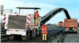
La **W 2100** es la de más grande rendimiento entre las máquinas que fresan en frío de Wirtgen de la clase de 2 m
