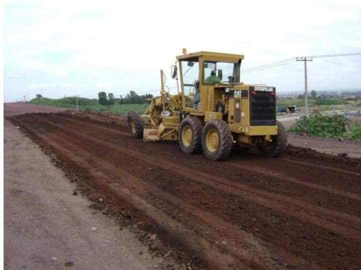
**Fig. 76 Motoconformadora nivelando carretera.**
