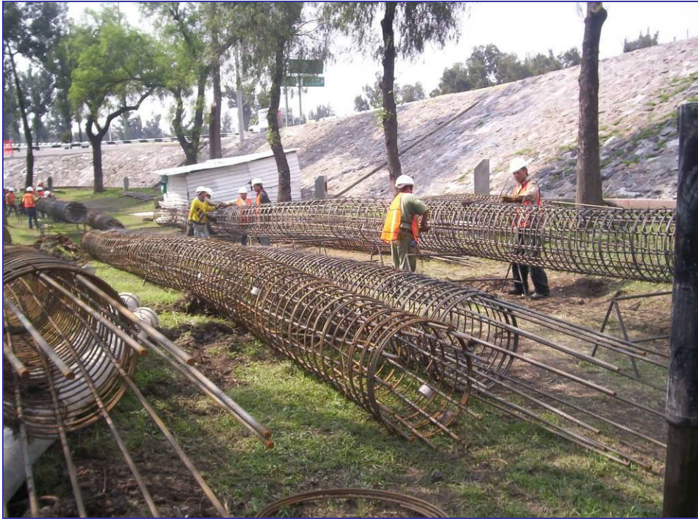
Armado de pilas en la obra.
