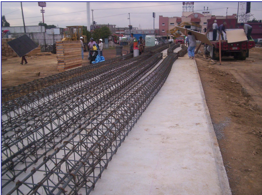
Refuerzo en pilotes
