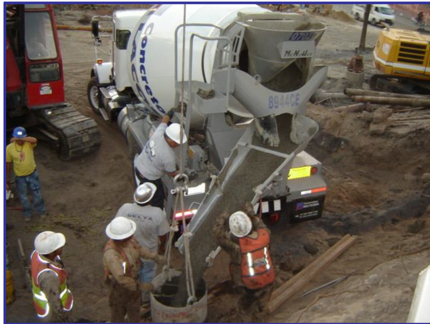
Colado de pila.
