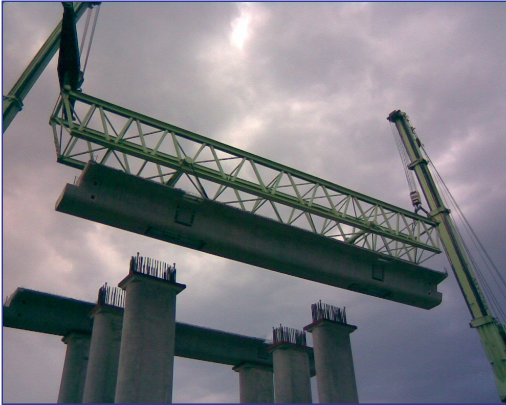
Montaje de traves TA.
