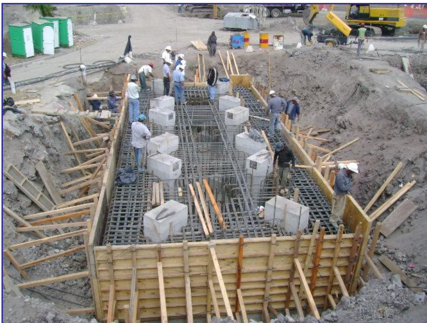
Cimbra de las zapatas.
