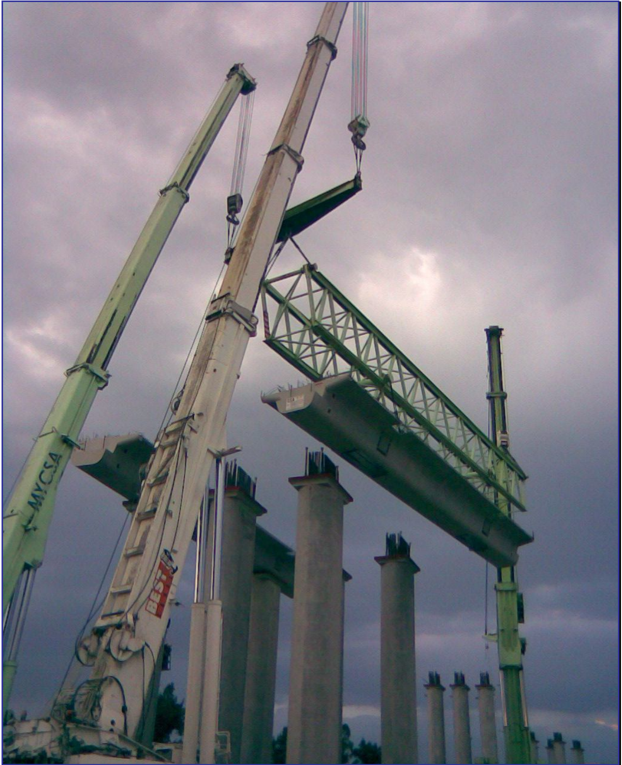
Montaje de traves TA.
