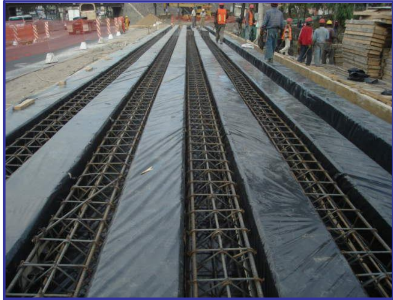
Fabricación de pilotes
