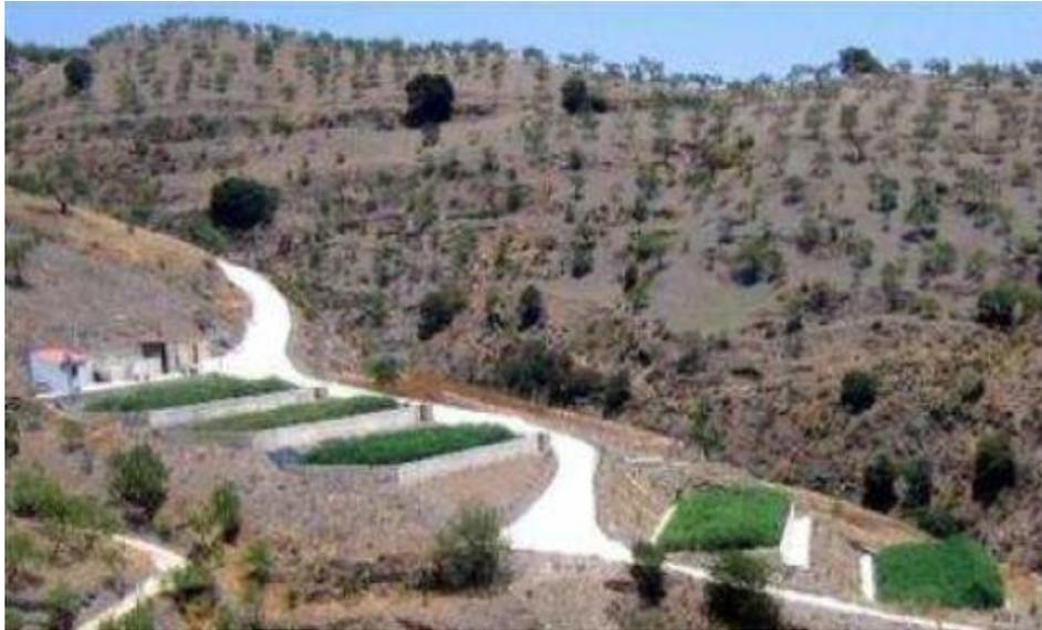
**Ilustración 0.2, Sistema francés para 800 PE, de izquierda a derecha: tres HFV (filtros) para el pretratamiento y dos HFV para el tratamiento secundario en Albondón, España.
