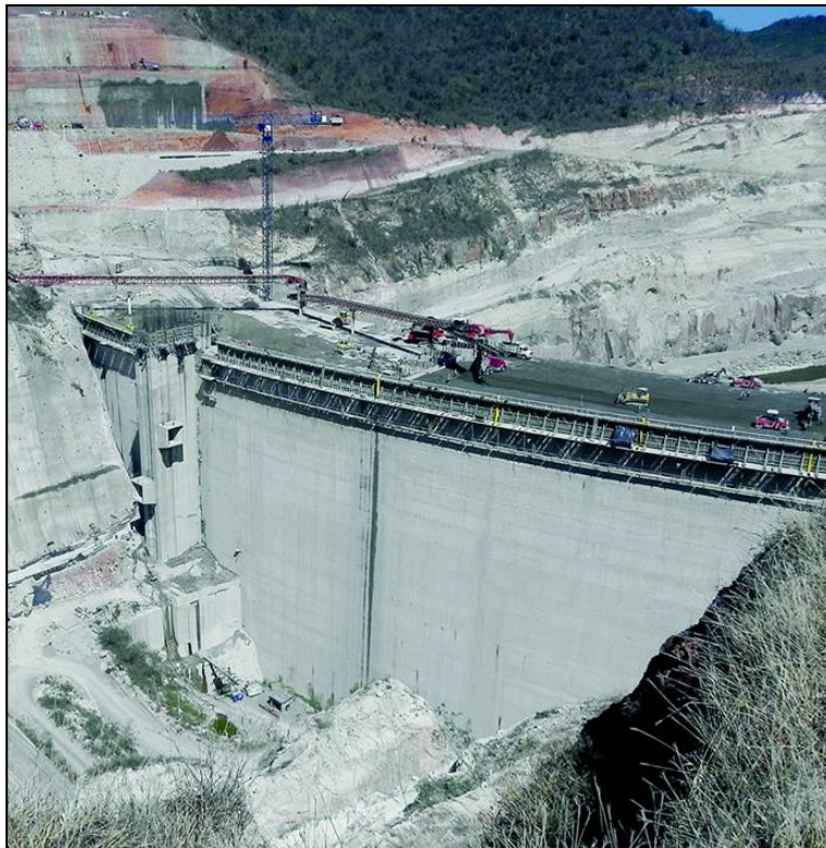
Figura 1-1. Construcción de la Presa El Zapotillo. Fuente: (SAPAL, 2014)
