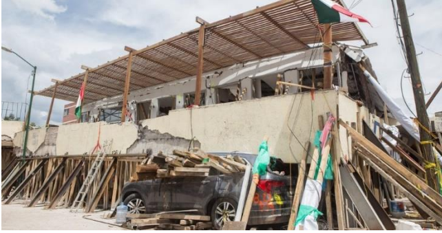
Fig. I. 10 Colegio Enrique Rébsamen después del sismo (Imagen de "Diario de Morelos")
