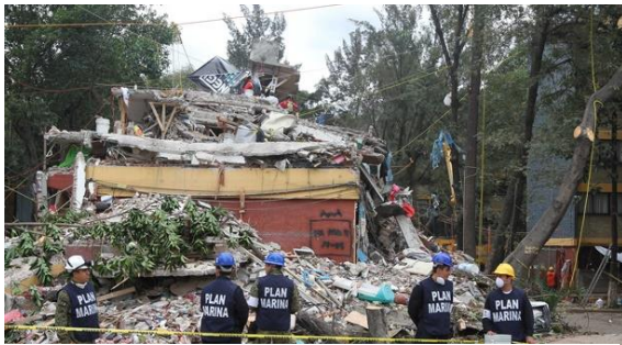
Fig. I.11 Colapso de un edificio del Multifamiliar de Tlalpan (Imagen de "Radio Fórmula")
