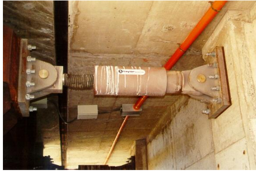
Fig. II. 9 Amortiguador viscoso 2 (Imagen de "/ingenieriasismicaylaconstruccioncivil.blogspot.mx" )
