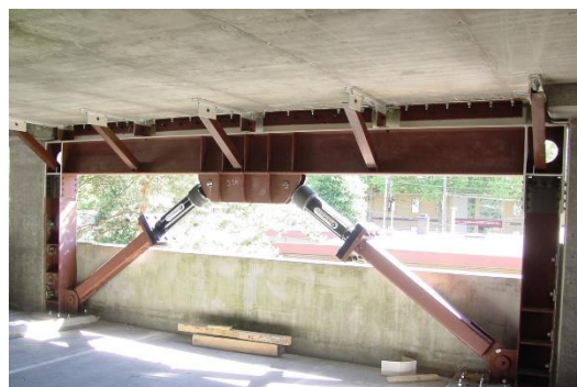
Fig. II. 8 Amortiguadores viscosos 1 (Imagen de "architecture.org.nz")
