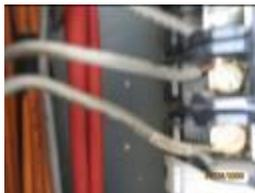
Tablero primer nivel, conductores con aislamiento dañado
