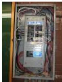
Tablero sótano cubículos, sucio, con empalmes, conductor duplex y alambre.
