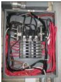
Tablero planta baja sala de computadoras línea regulada, sin tierra física
