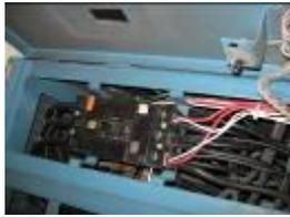
Regulador de línea sótano, sucio, sin mantenimiento, y varias conexiones derivadas a los demás niveles además de dos conexiones para aires acondicionados.
