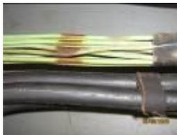
Tablero del cuarto nivel, conductores en mal estado.
