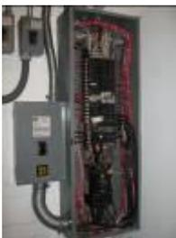
Tablero sótano línea normal, conductores sueltos, empalmes, derivación previa al interruptor principal.
