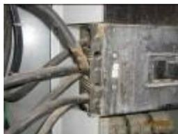
Tablero general del edificio, conductor de alimentador de fase suelta
