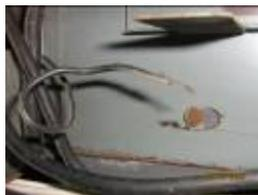
Conductores sueltos, tablero del tercer nivel.
