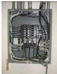
Tablero primer nivel comunicaciones, derivación para centro de carga desde las zapatas principales, conductores de uso rudo en los circuitos
