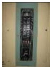
Laboratorio de eléctrica, empalmes, circuitos reinados de barras sin una buena conexión sin tierra física
