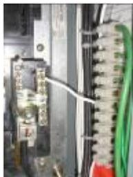
Tablero primer nivel comunicaciones línea regulada, unión de una tierra aislada con la barra del neutro
