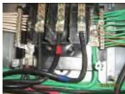
Tablero cuarto nivel, unión del neutro, conductor de tierra eléctrica desnuda y conductor forrado de tierra aislada
