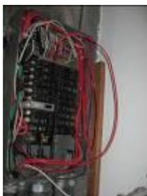
Tablero sótano línea regulada, empalmes, gabinete saturado, sin cubierta.
