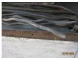
Tablero del segundo nivel, conductor suelto dentro del tablero.
