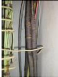
Tablero del cuarto nivel, conductores sueltos y empalmes dentro del gabinete.
