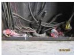
Empalme y suciedad dentro del tablero del segundo nivel.
