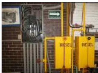
Tablero laboratorio de térmica, sin tapa de protección, conductores sueltos, conductores de uso rudo, sucio, sin tierra física y frente a tubería de diesel.
