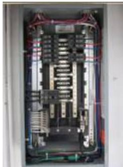
Tablero de línea regulada del área de cubículos, tierra eléctrica con tierra aislada y tierra del regulador, unido a la barra del neutro y al gabinete.
