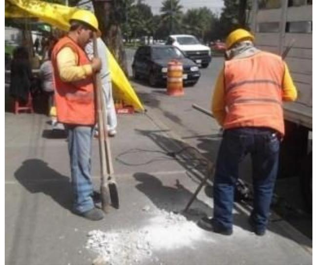
Imagen 99 Demolición de Concreto para la Instalación de SVB.
