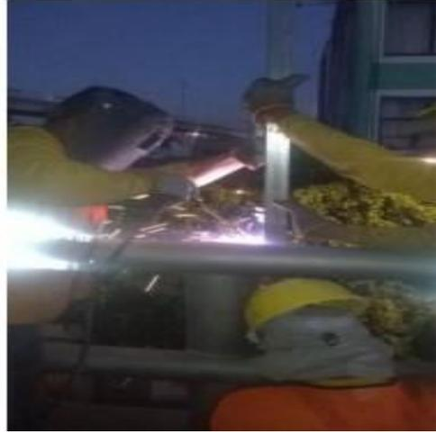
*Imagen 105 Instalación de SVB con soldadura*
