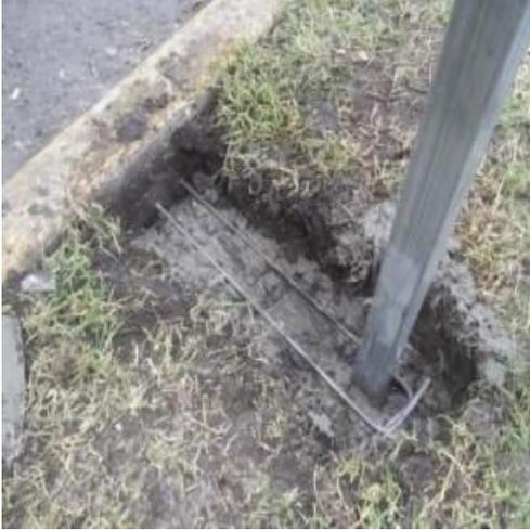
*Imagen 104 Fijación de varillas a guarnición para la Instalación de SVB*
