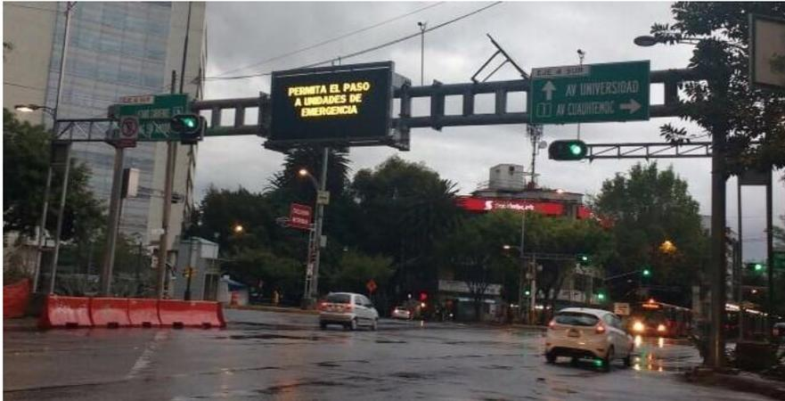
*Imagen 96 Montaje de Travesaño, Tableros y Pantalla Full Matix para Estructura Tipo Puente.*
