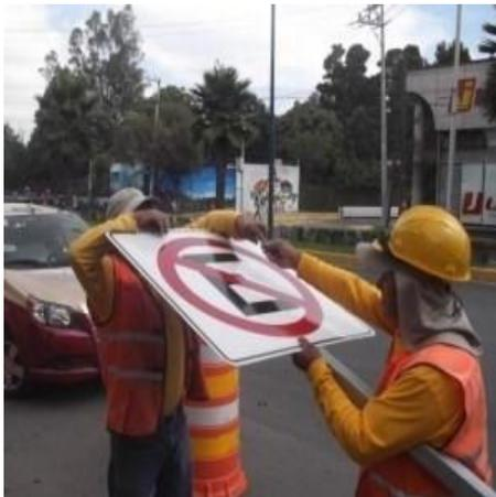
*Imagen 102 Fijación de la lámina al poste para la Instalación de SVB*
