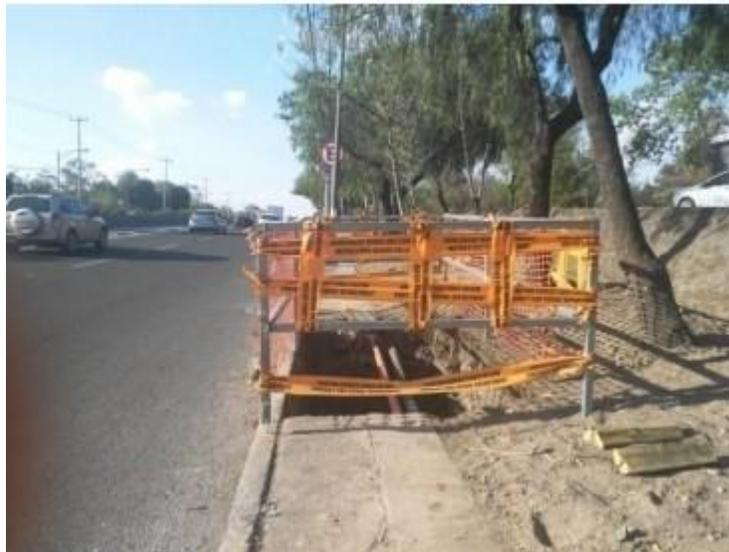
*Imagen 72 Confinamiento de Excavación para Estructura Tipo Puente*
