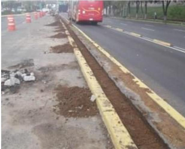
*Imagen 82 Relleno de Zanja con Tepetate Compactado para Canalización de Bandera Doble Con Módulo de Leds.
