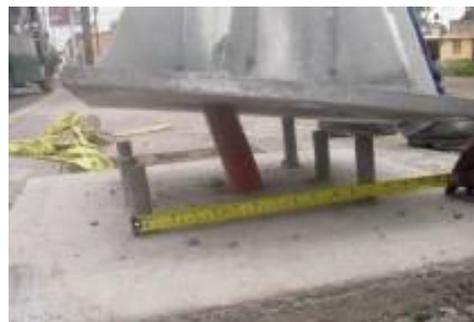
*Imagen 85 Verificación de Correcta Unión entre Poste y Anclas de Cimentación para Bandera Doble con Módulos de Leds.
