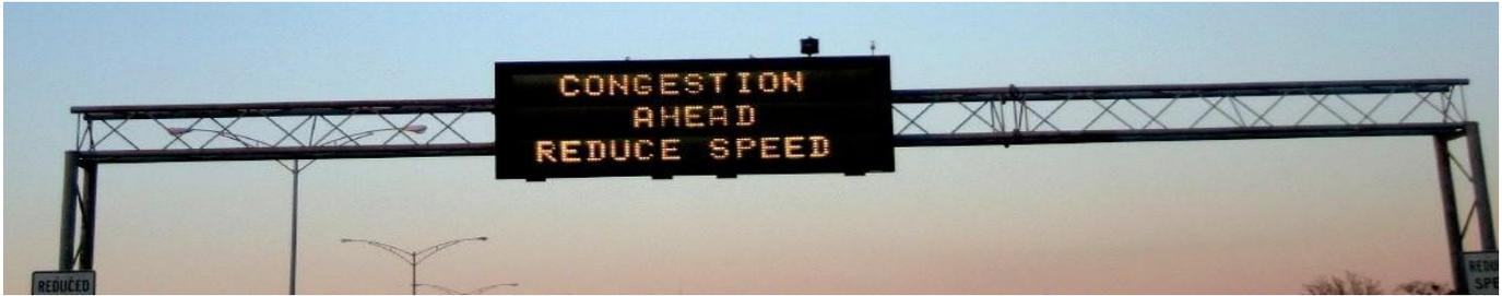
Imagen 1. VMS (señales de mensaje variable) en una auto pista
