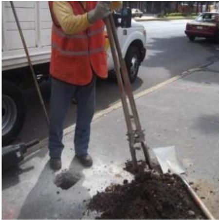
*Imagen 100 Excavación para la Instalación de SVB*
