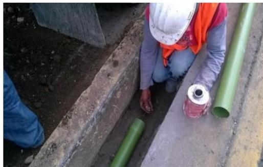
Imagen 80 Tendido y Unión de Tubo de PVC para Canalización de Bandera Doble Con Módulo de Leds.
