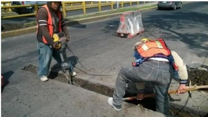
Imagen 77 Excavación en arroyo vehicular para canalización de bandera doble con módulo de leds
