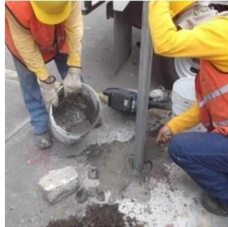
*Imagen 101 Elaboración de Concreto hecho en sitio para la Instalación de SVB*
