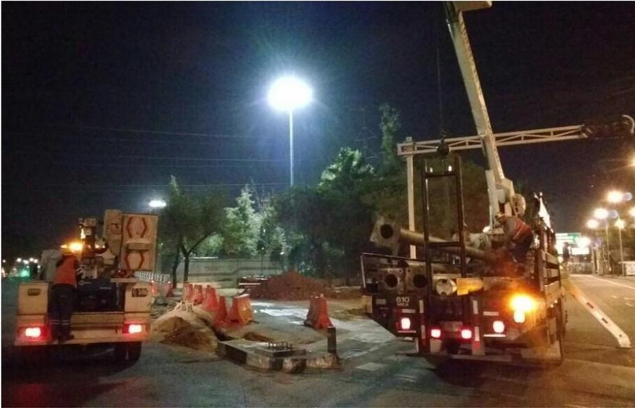
*Imagen 67 Montaje del perfil de acero.
