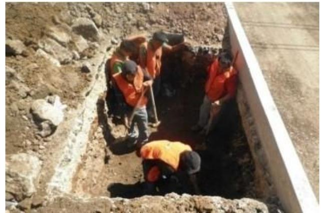
*Imagen 71 Excavación para Estructura Tipo Puente*
