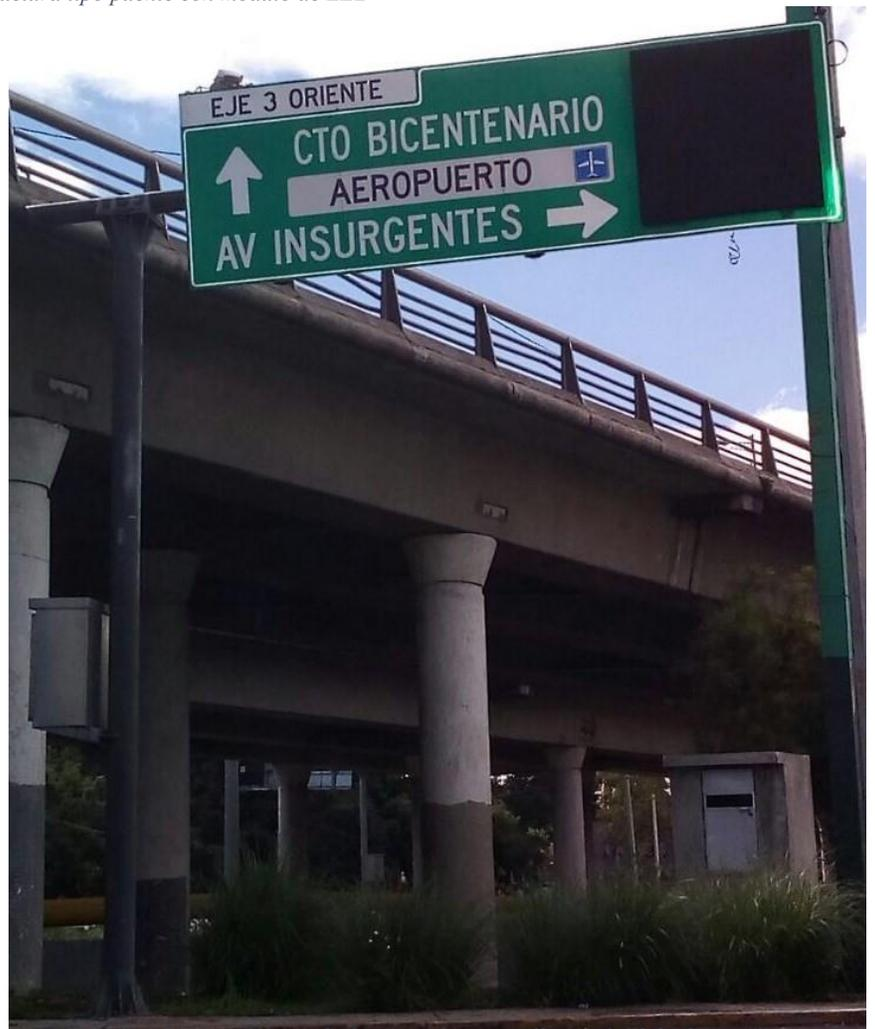
Imagen 15 Señalamiento Vertical Alto “Bandera sencilla con módulo de LED”
