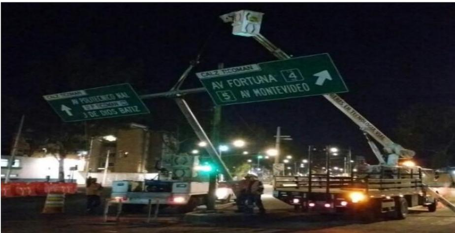
*Imagen 68 Montaje final de una bandera doble, armada en campo.
