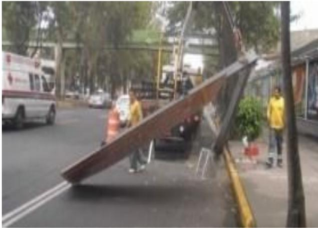
*Imagen 53 Apoyo de Grúa para Desmontaje*
