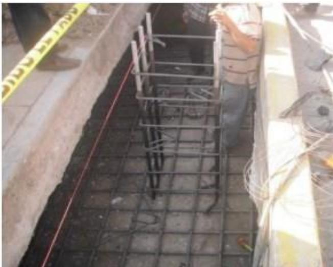
*Imagen 74 Armado de Acero para Cimentación de Estructura tipo puente*
