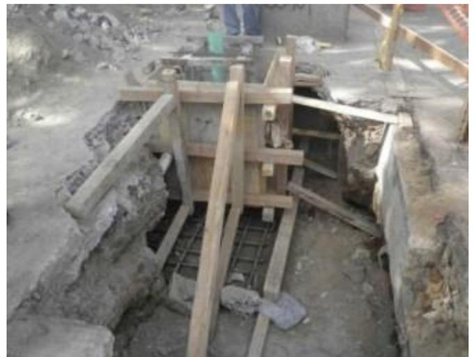
*Imagen 75 Cimbra para el vaciado de concreto en bandera Sencilla con Módulo de leds*
