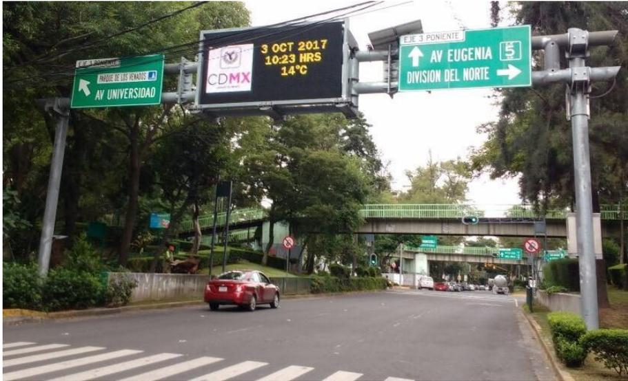
Imagen 13 Señalamiento Vertical Alto “Estructura tipo puente con módulo de LED”
