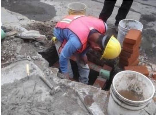
Imagen 78 Construcción de Registros para Canalización de Estructura Tipo Puente
