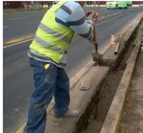
Imagen 79 Cama de Arena para Canalización de Bandera Doble Con Módulo de Leds.
