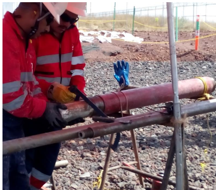
Figura 2.7 Tubo TGC, extracción de muestra de 20 cm
