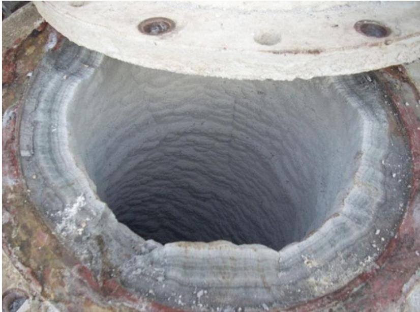
**Figura 1. 5.- Incrustación de carbonatos de calcio en una tubería del campo geotérmico Kizildere, Turquía (tomada de Haklidir et al., 2017).**
