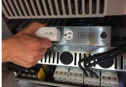
Figura 9. Desconexión del ventilador (Ortega & Soladana. 2018).
