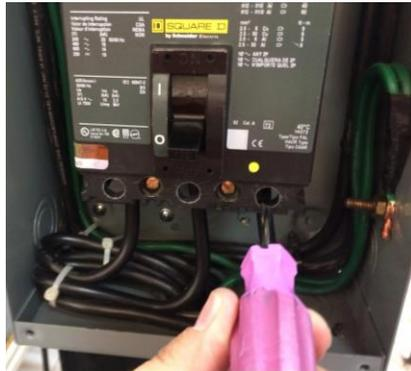
Figura 3. Paso 1-d: desatornillar (Ortega & Soladana. 2018).
