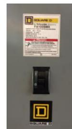
Figura 2. Paso 1-b: caja de alimentación apagada (Ortega & Soladana. 2018).
