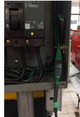
Figura 4. Paso 1-e: conexión a tierra (Ortega & Soladana. 2018).
